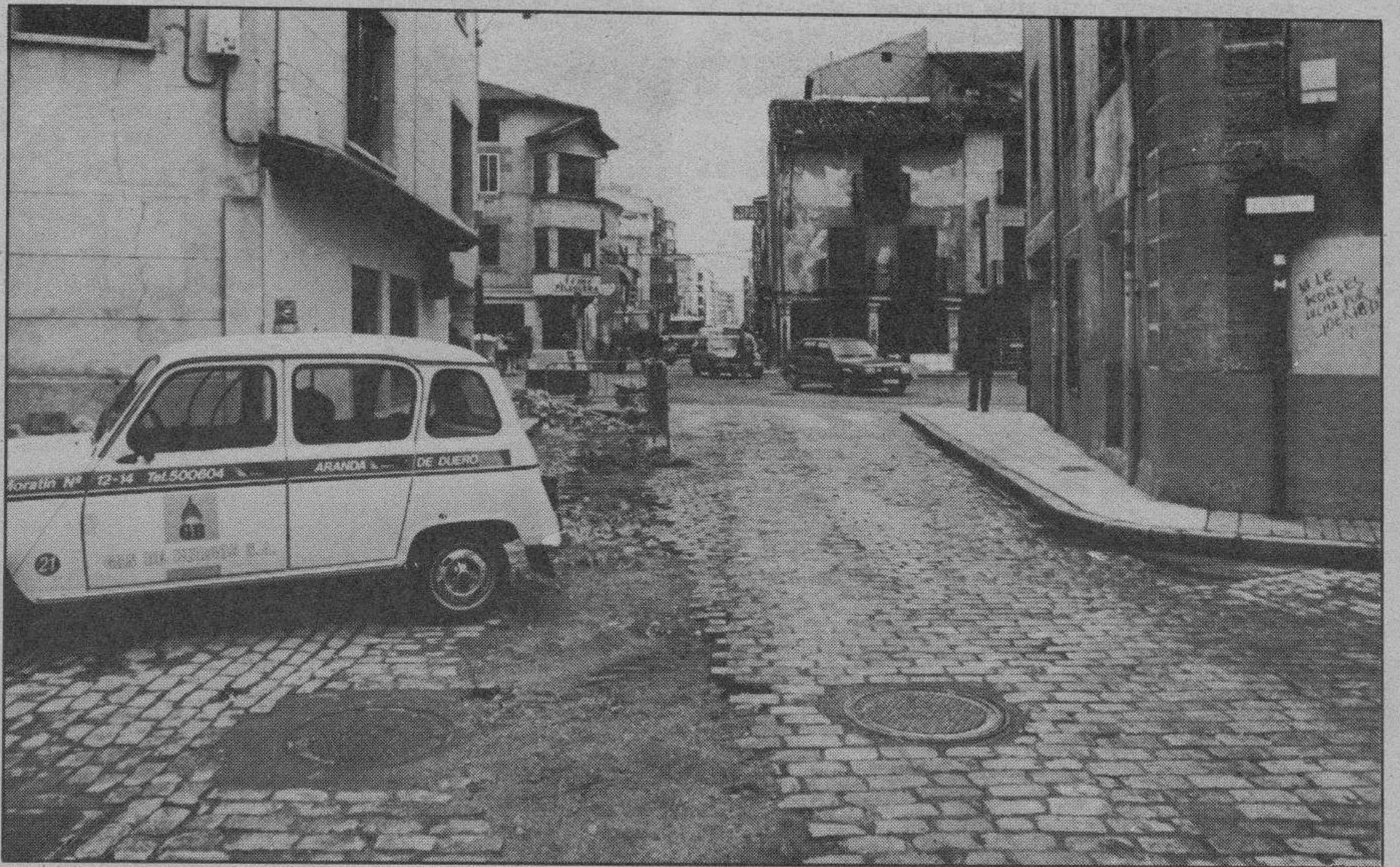
Aranda de Duero, nuevamente en obras. Gran parte de las calzadas de nuestra localidad están nuevamente levantadas, existen calles cortadas y señalizaciones por doquier. Varias son las causas: en primer lugar, la peatonalización de la zona centro, que llevará unos meses, y por otra parte la instalación del Gas Natural. En algunas calles del centro que todavía no van a ser peatonalizadas se han levantado ya los adoquines para ir introduciendo los cables de Telefónica, agua, y demás elementos necesarios para que a continuación se inicien las obras de arreglo, para que no se retrasen más. Son las molestias que los ciudadanos debemos sufrir a cambio del progreso. Foto Florentino Lara.
