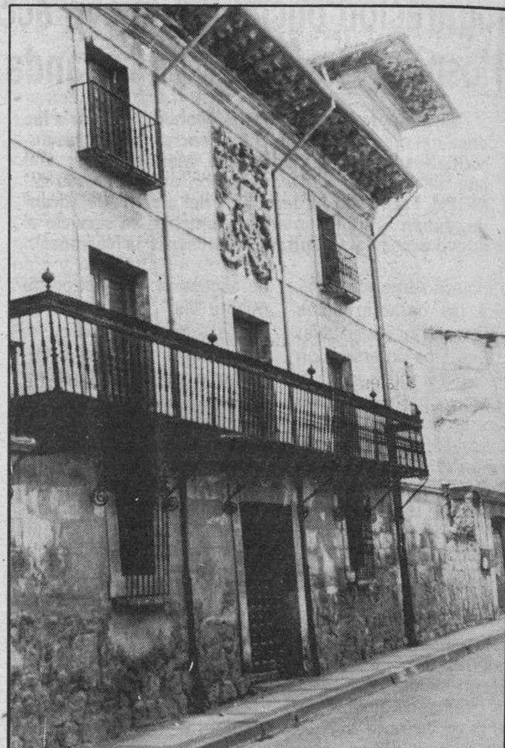
Palacio de «Los España», donde se están haciendo trabajos de restauración.
