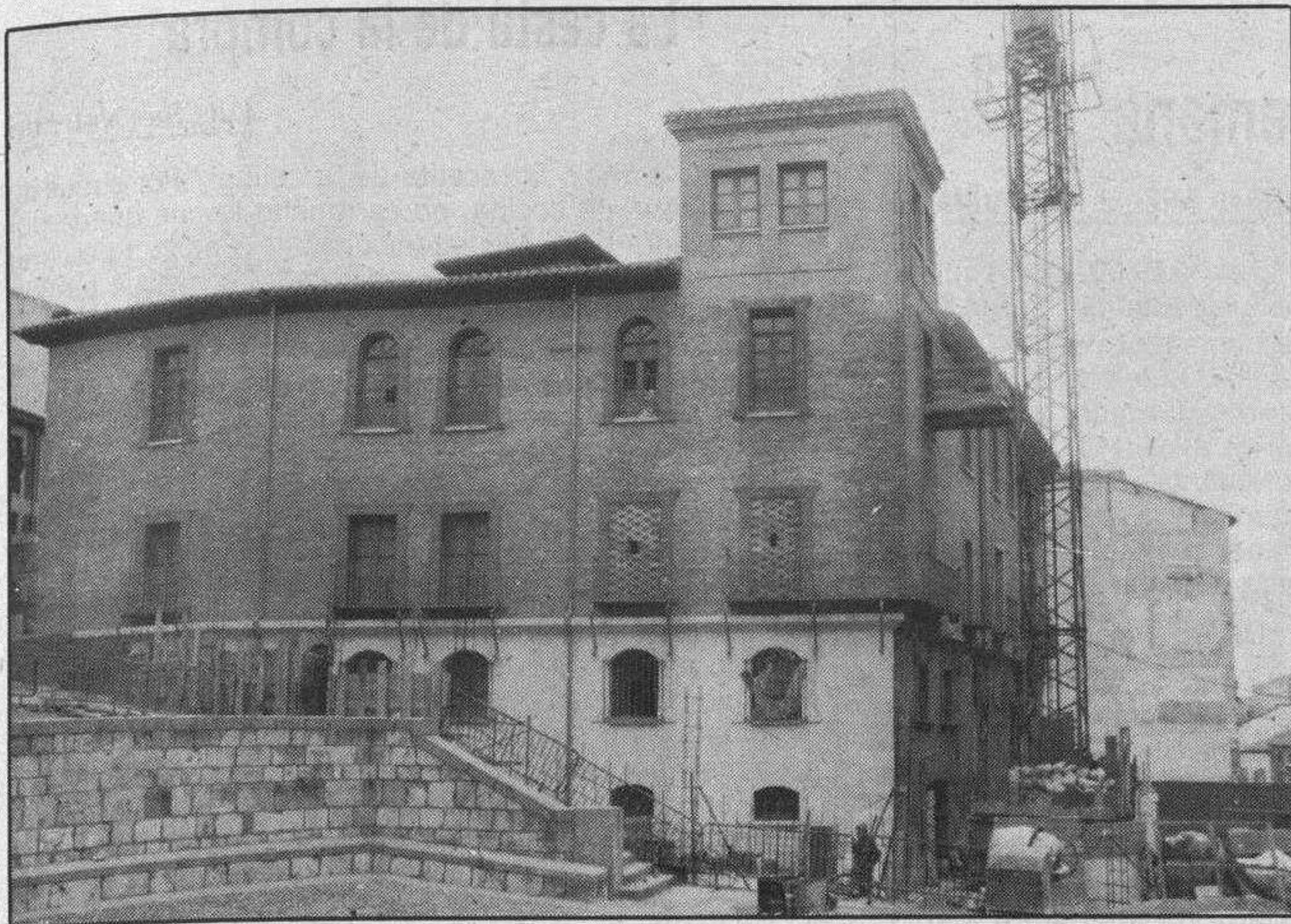
Las obras de rehabilitación y consolidación del edificio finalizarán a principios del próximo verano.
