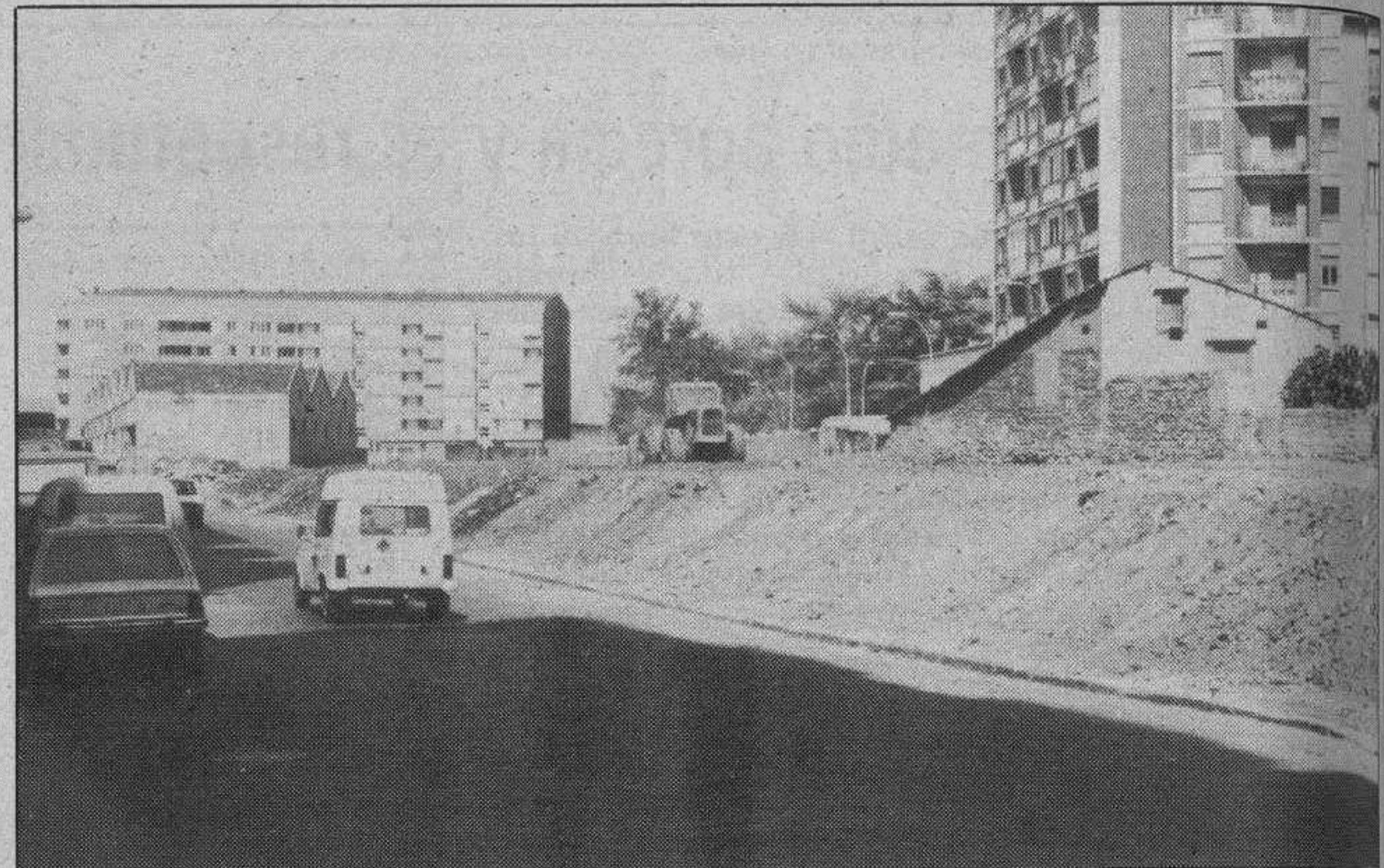
Demolición de las tapias de la Ronda del Ferrocarril y cobertura del paso inferior. — Dos importantes obras urbanísticas están siendo acometidas estos días por la empresa Fontecha, adjudicataria de las mismas por un montante de 1.300.000 pesetas. Los trabajos comenzaron por la cubrición del paso inferior de la calle de La Estación, que servía para salvar el paso del tren por la vía férrea Castejón-Bilbao. Actualmente los vestigios del paso que nos muestra la fotografía ya no existen. Por otro lado también se ha procedido a la demolición de las tapias del ferrocarril del antiguo trazado de la susodicha línea a lo largo de la calle de Los Almacenes, aspecto que recoge la cámara de Truchuelo, barruntándose ya lo que será la futura configuración de la calle Ronda del Ferrocarril. Sin duda son aspectos históricos de nuestra urbanística.
