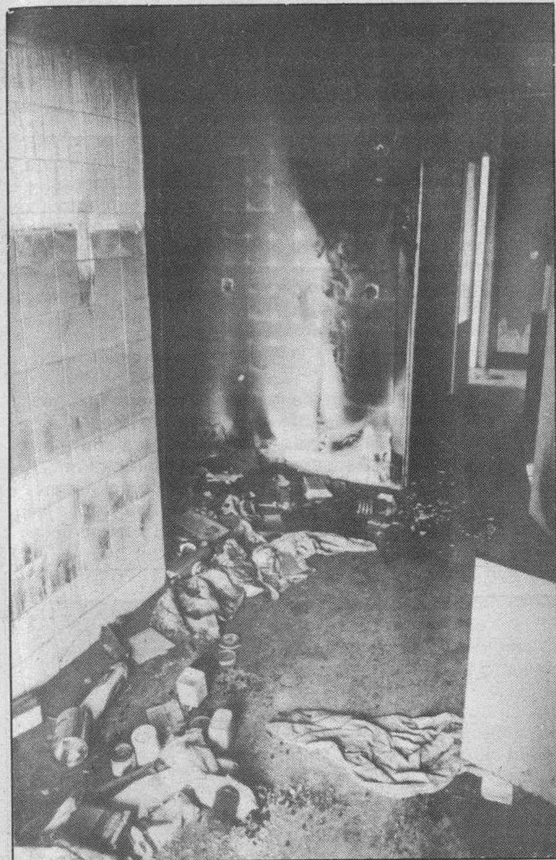
La comunidad de vecinos del número 9 de la calle Comneros de Castilla han denunciado el deterioro de la convivencia causado por los ocupantes de un piso situado en la séptima planta. El propósito de la comunidad es privar a los citados inquilinos del uso de la vivienda, para lo que está dispuesta a iniciar las acciones legales, dado caso que prosiguiera la situación. Los vecinos han elevado su problema a varios estamentos oficiales.
