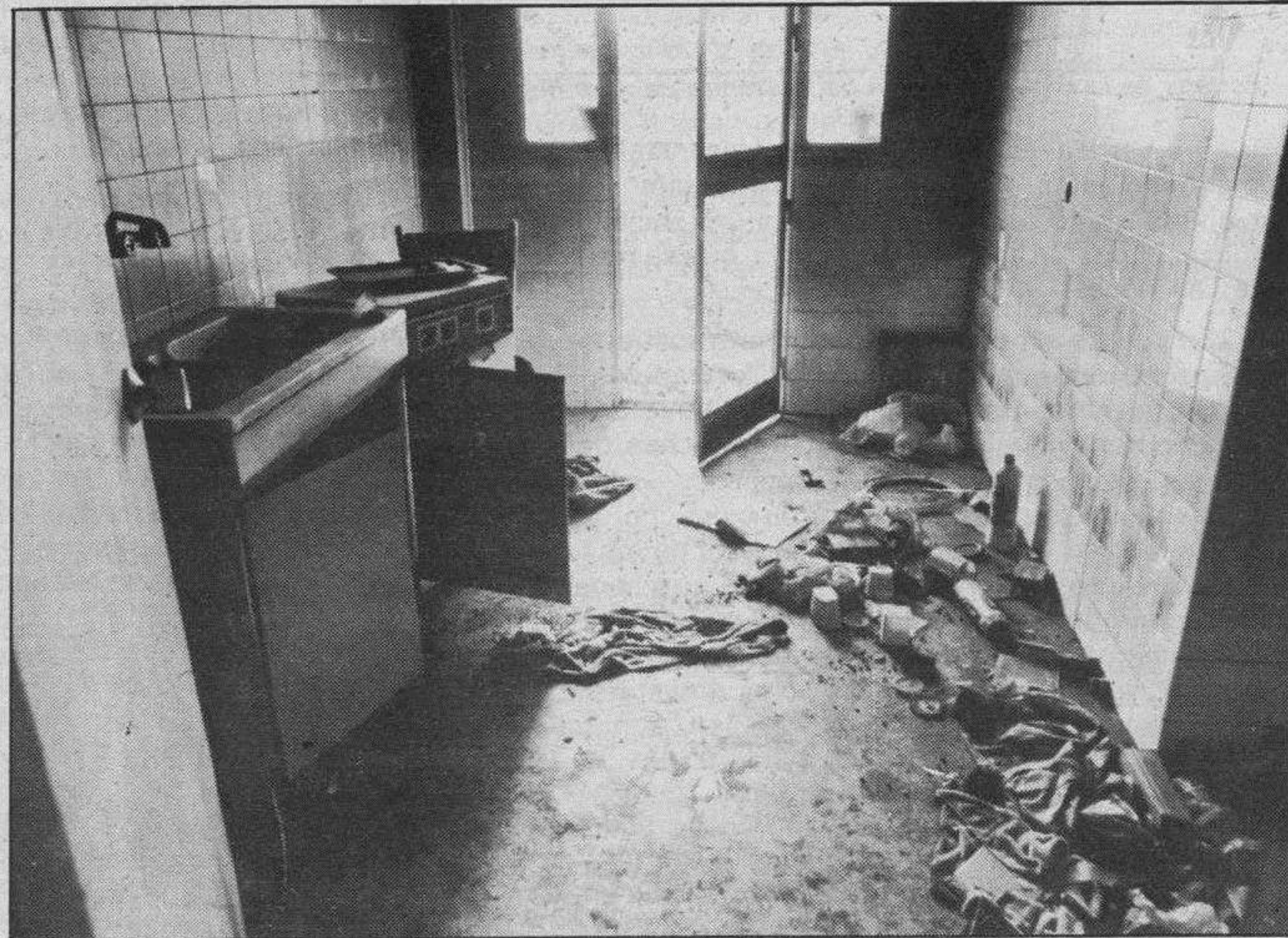
La higiene de la vivienda es nula debido a la acumulación de basuras.
