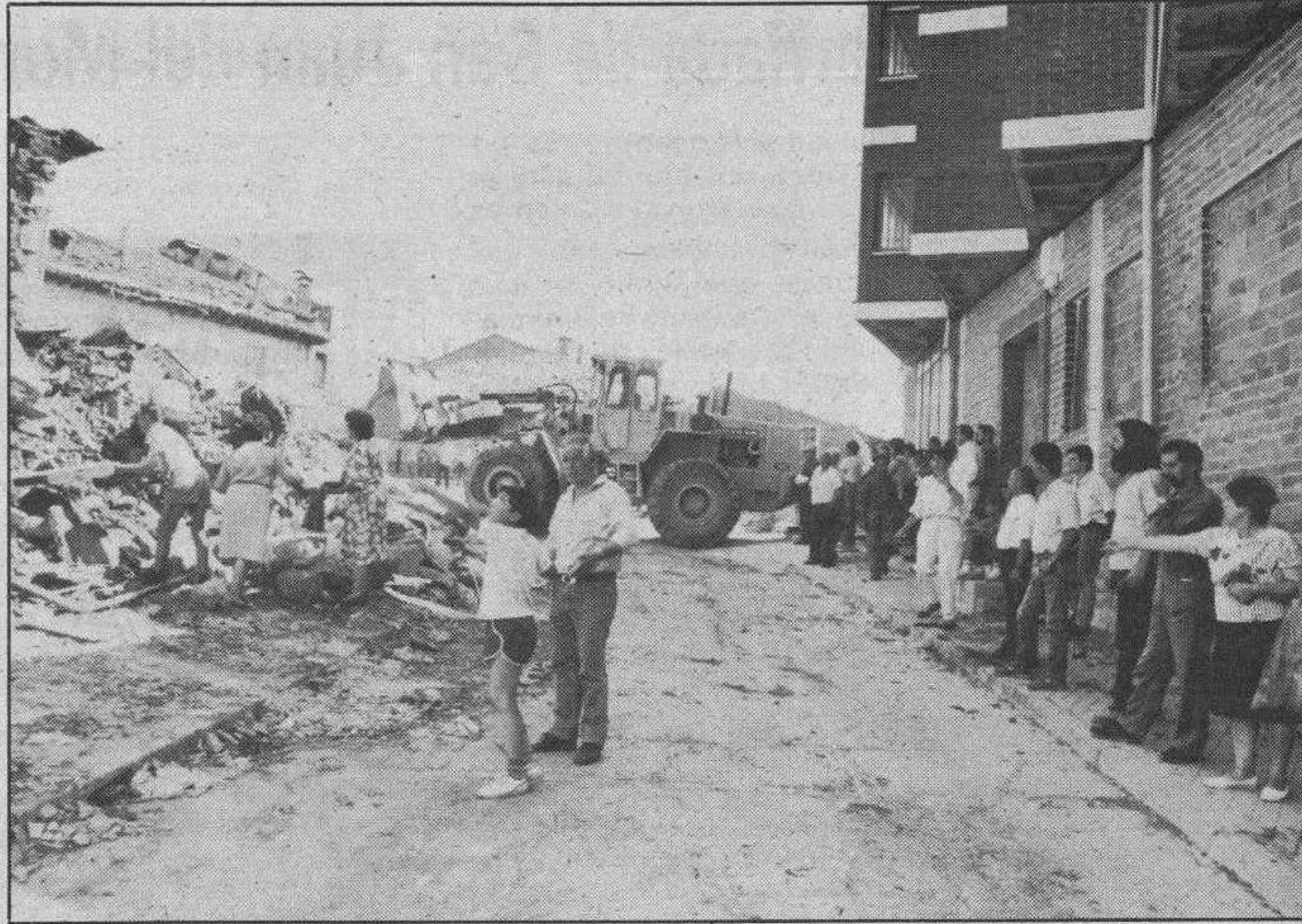
Los dueños de las viviendas buscan entre los escombros algo que pueda ser recuperable.
