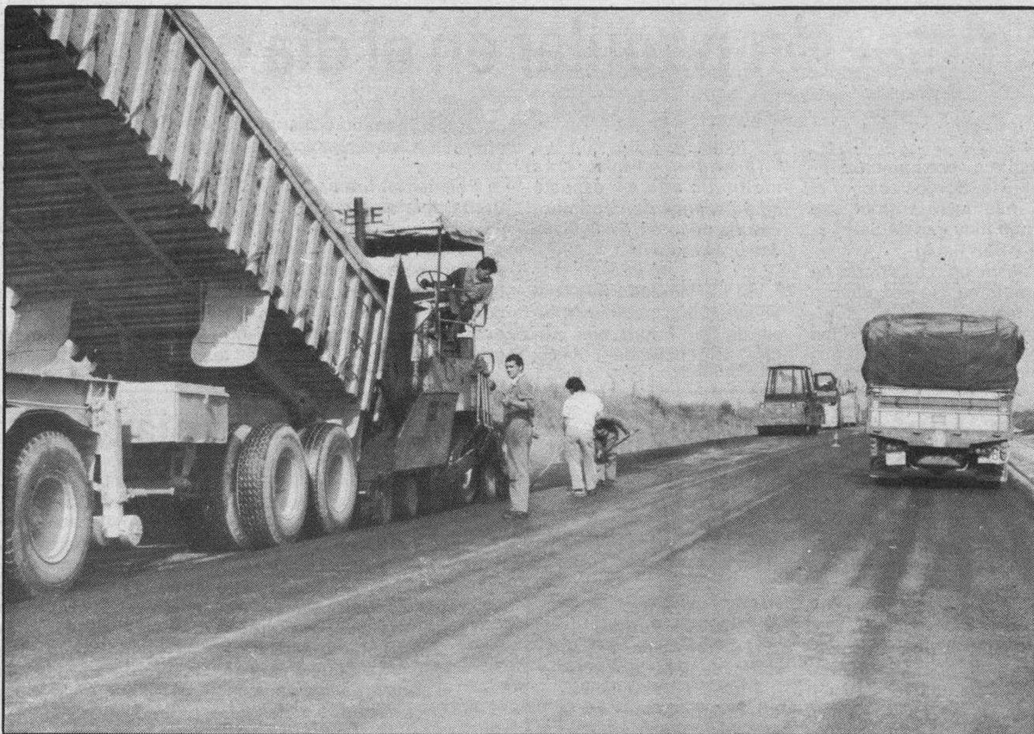
Obras en la carretera. — Una de las múltiples obras que se puede encontrar en la carretera si usted sale de vacaciones o simplemente se traslada es ésta, en el tramo Landa-Buniel, de la circunvalación a Burgos. El MOPU está procediendo de nuevo a asfaltar todo este tramo que ha planteado serias dificultades a los técnicos desde su apertura al tráfico. Las molestias están perdonadas.
