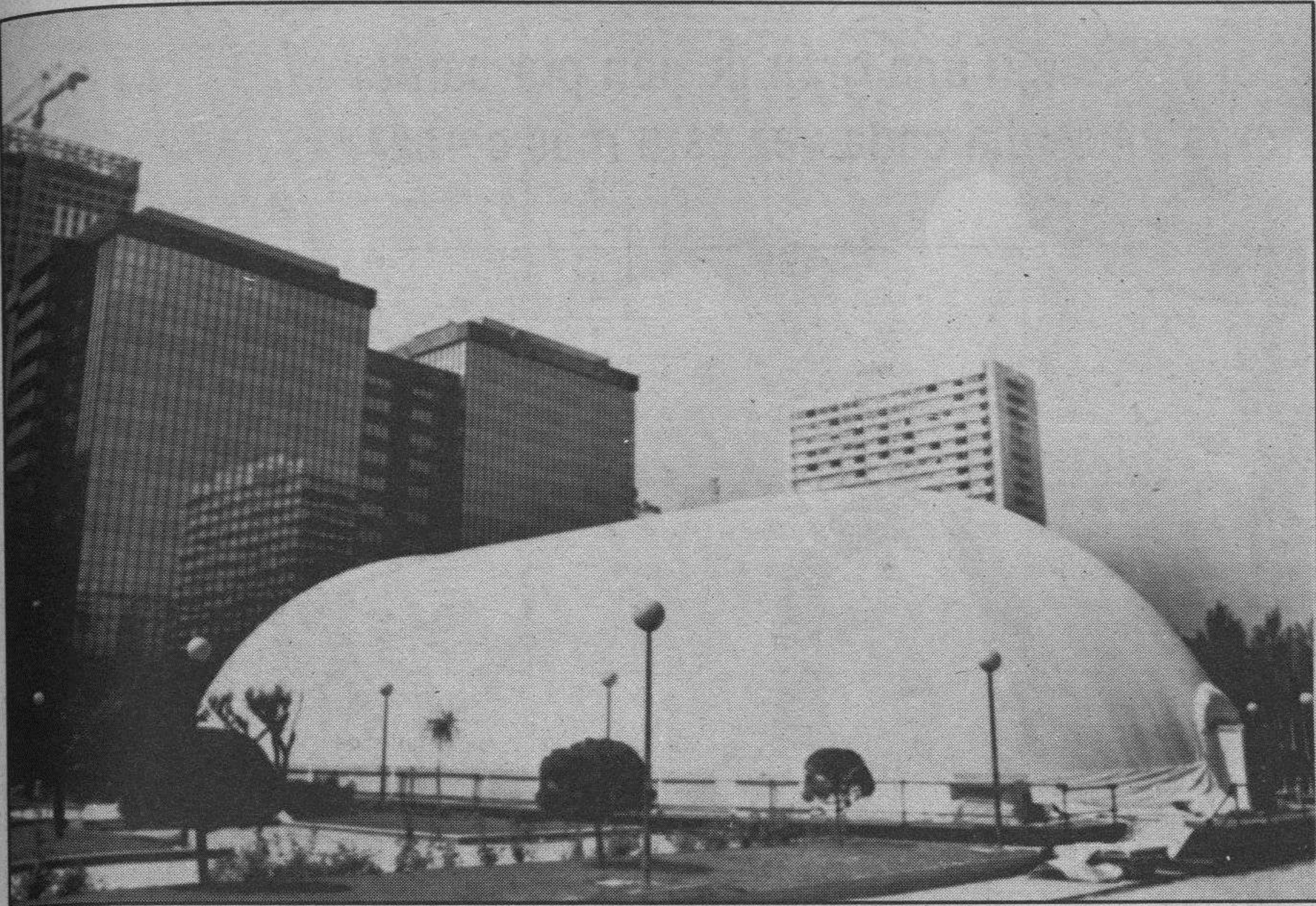
Carpa gigante. — Enorme carpa instalada junto al Palacio de Congresos y Exposiciones que albergará una muestra sobre Telecomunicaciones y Electrónica. Tiene 1.200 metros cuadrados, 12 metros de altura y una capacidad para unas 1.500 personas. — Telefoto Efe.
