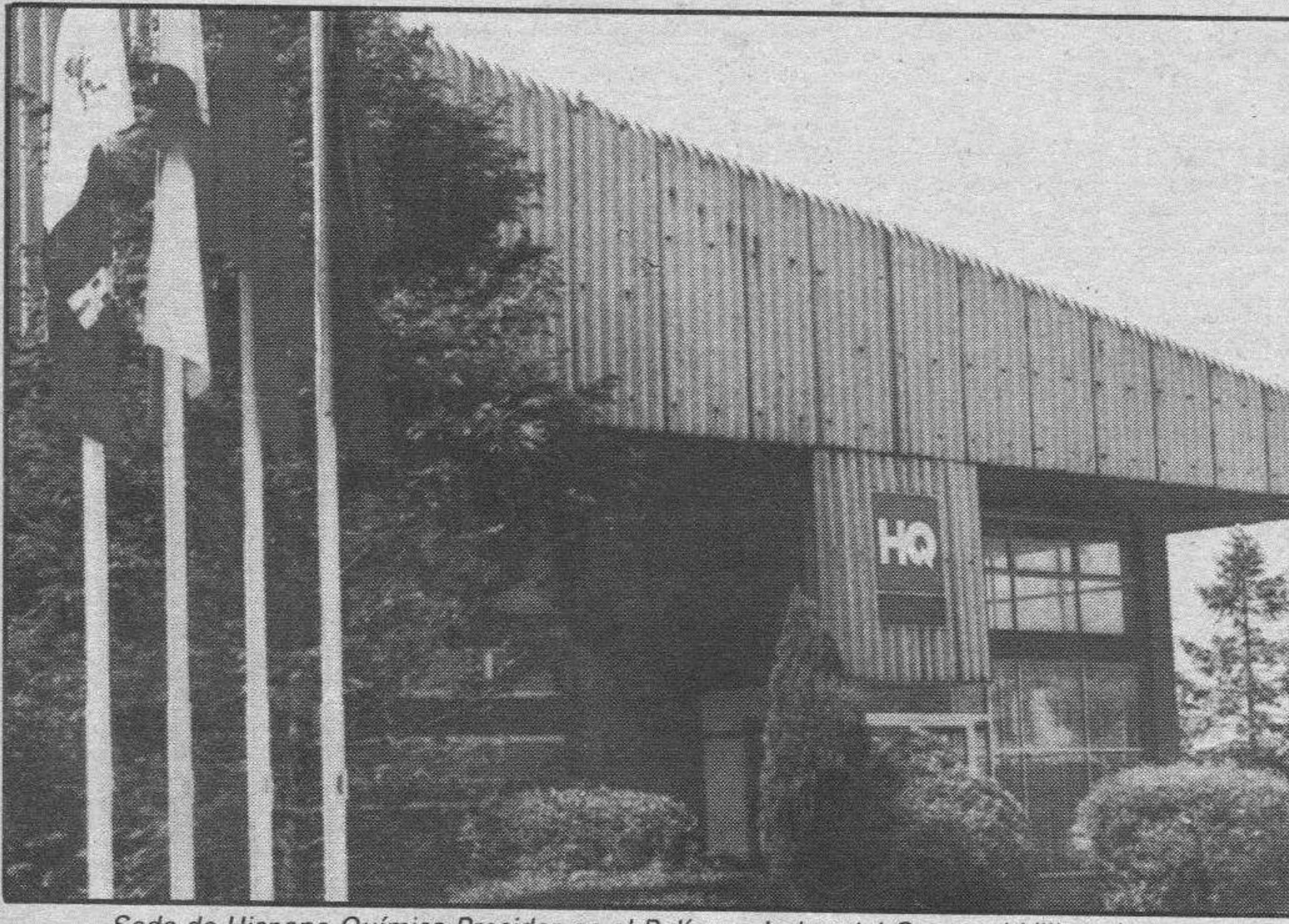
Sede de Hispano Química Prosider en el Polígono Industrial Gamonal-Villayuda.
