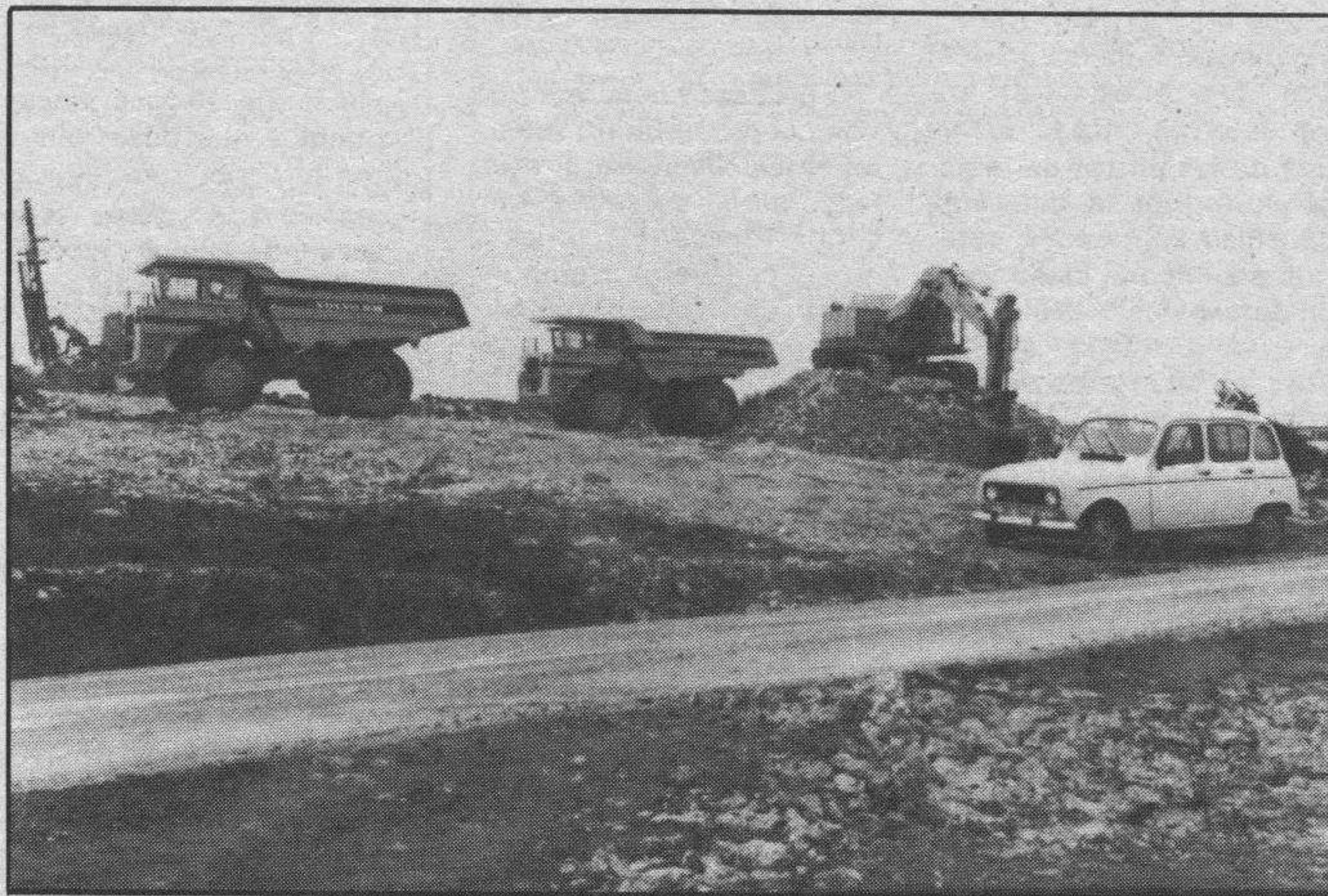
Vista parcial de la zona de trabajo en la zona de Orbaneja.
