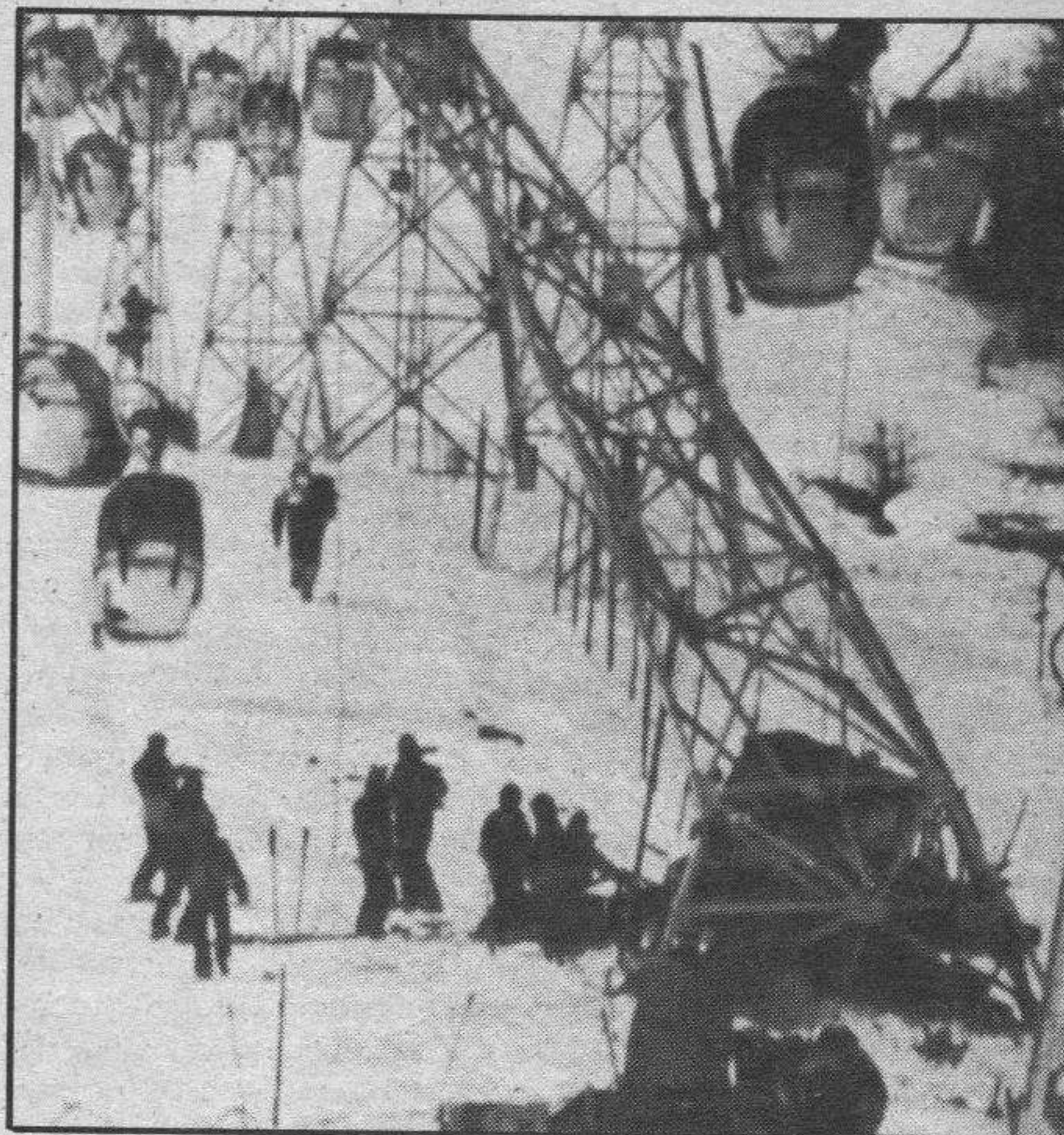
Vista general de las pistas de Val D'Iserre tras la rotura de uno de los soportes del telesilla. Una persona murió en el accidente. — Telefoto Efe.
