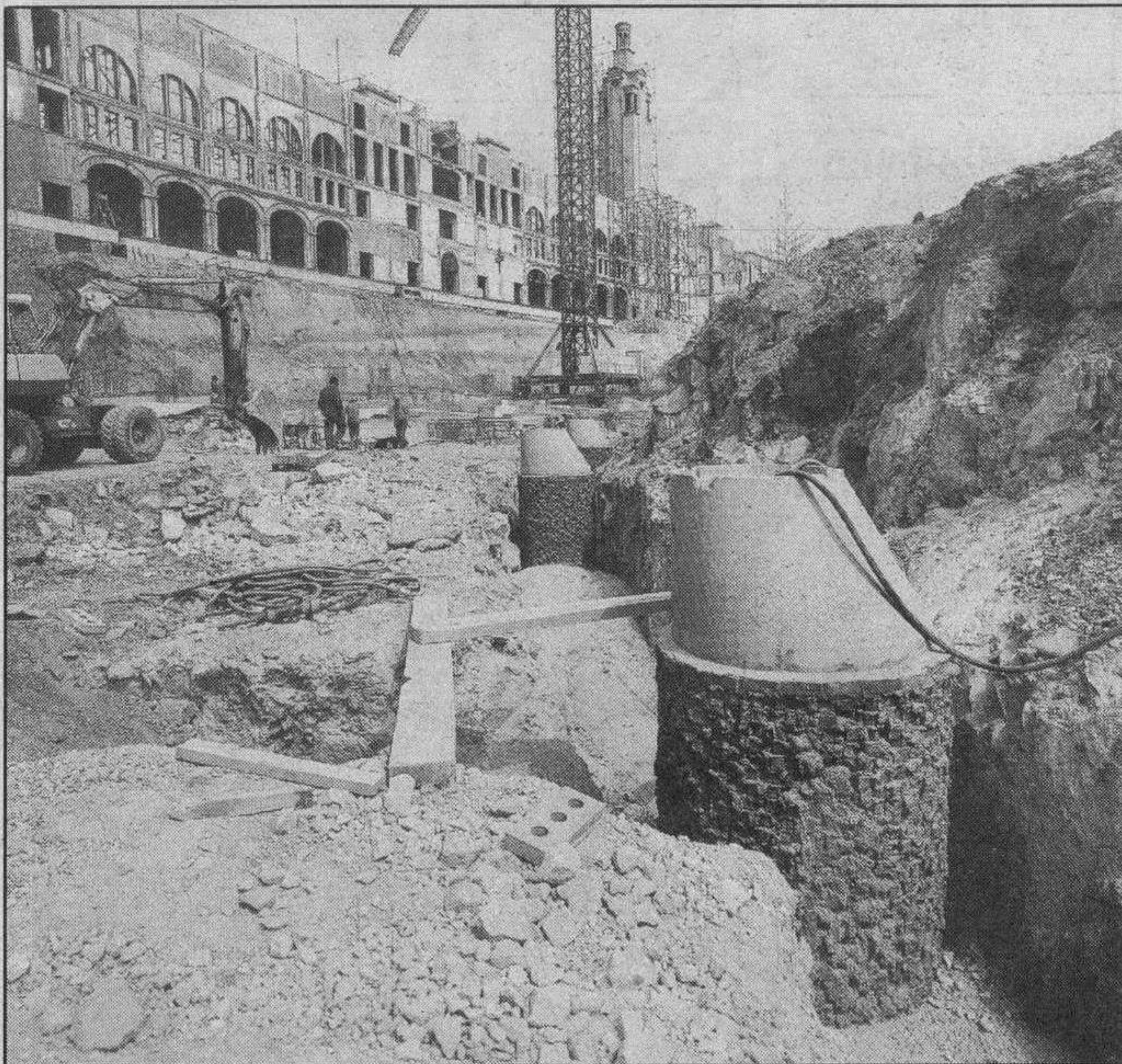
Las obras están avanzadas pero todavía faltan muchas cosas por hacer.
