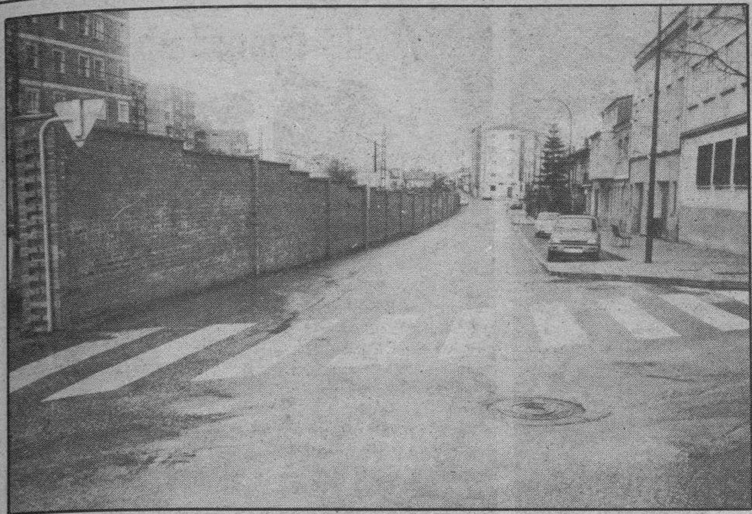
Calle Cortes, es su estado actual tras la realización de la tapia.
