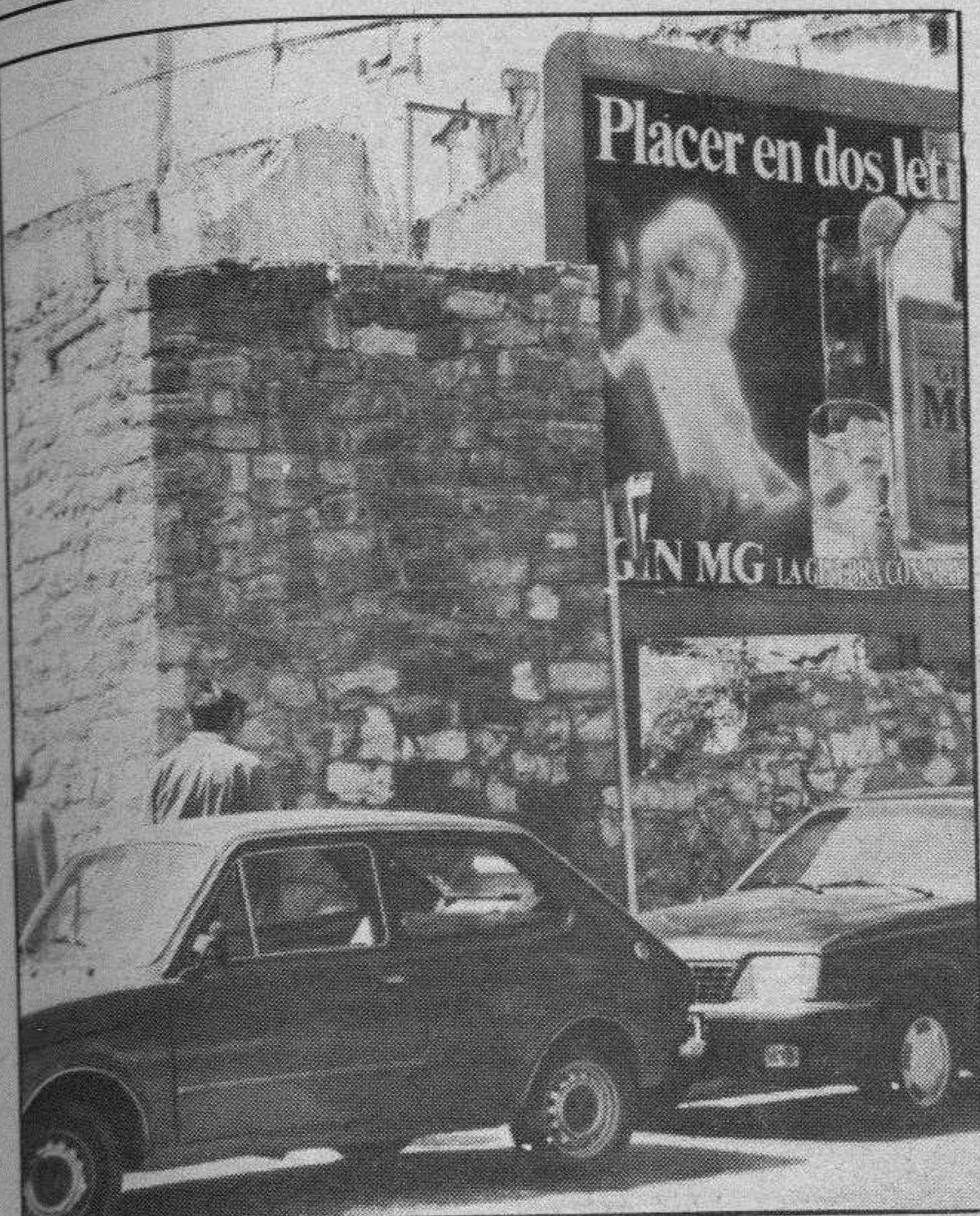
Ruinas y publicidad. — Este es el feo aspecto que presentan los restos de la antigua muralla de la ciudad, en un solar contiguo al arco de San Juan y frente al cauce del Vena y la iglesia de San Lesmes. Las ruinas de la vieja muralla no impiden la colocación del panel de publicidad. Arte, urbanismo y estética jamás deben reñir entre sí. En este caso, bien hará el Ayuntamiento en suprimir definitivamente el tramo de la muralla en ruinas. Es un vestigio aislado y pequeño que, al decir de la vecindad, no justifica una restauración.
