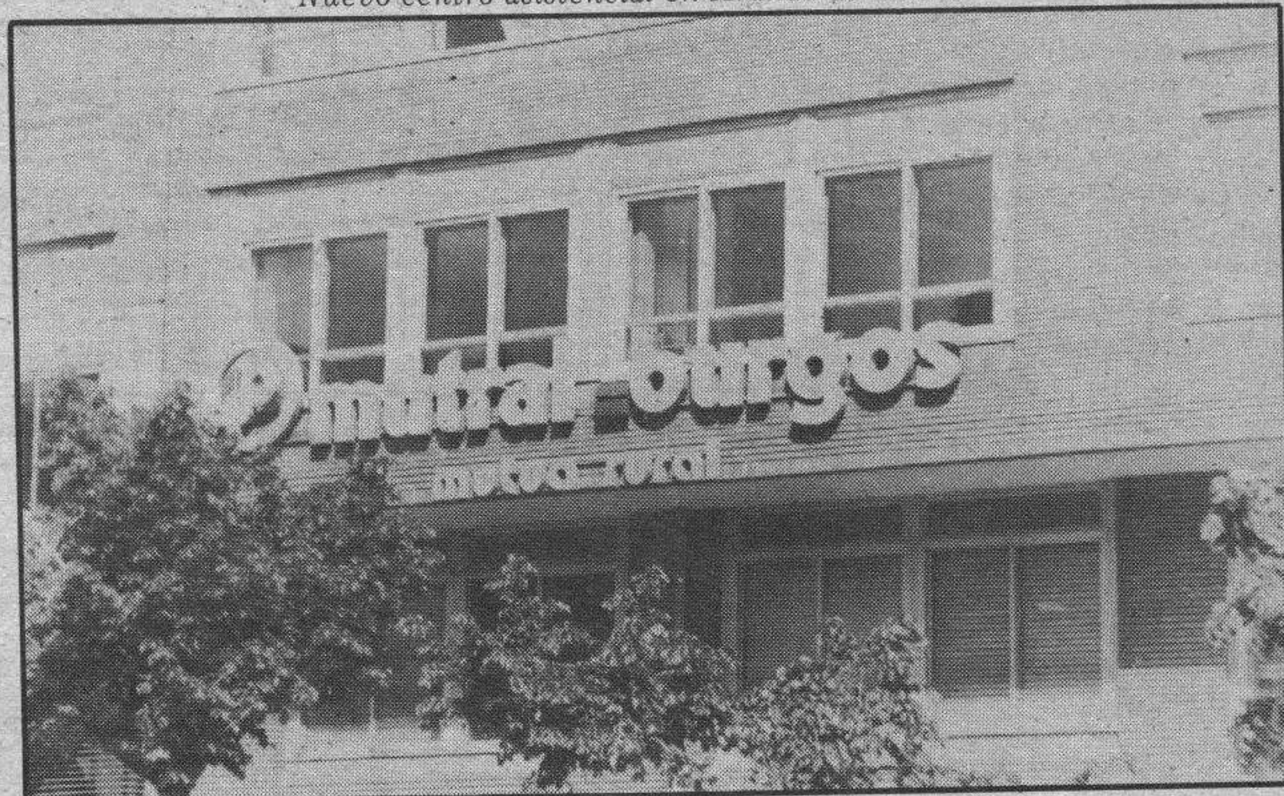
Oficinas centrales en Burgos
