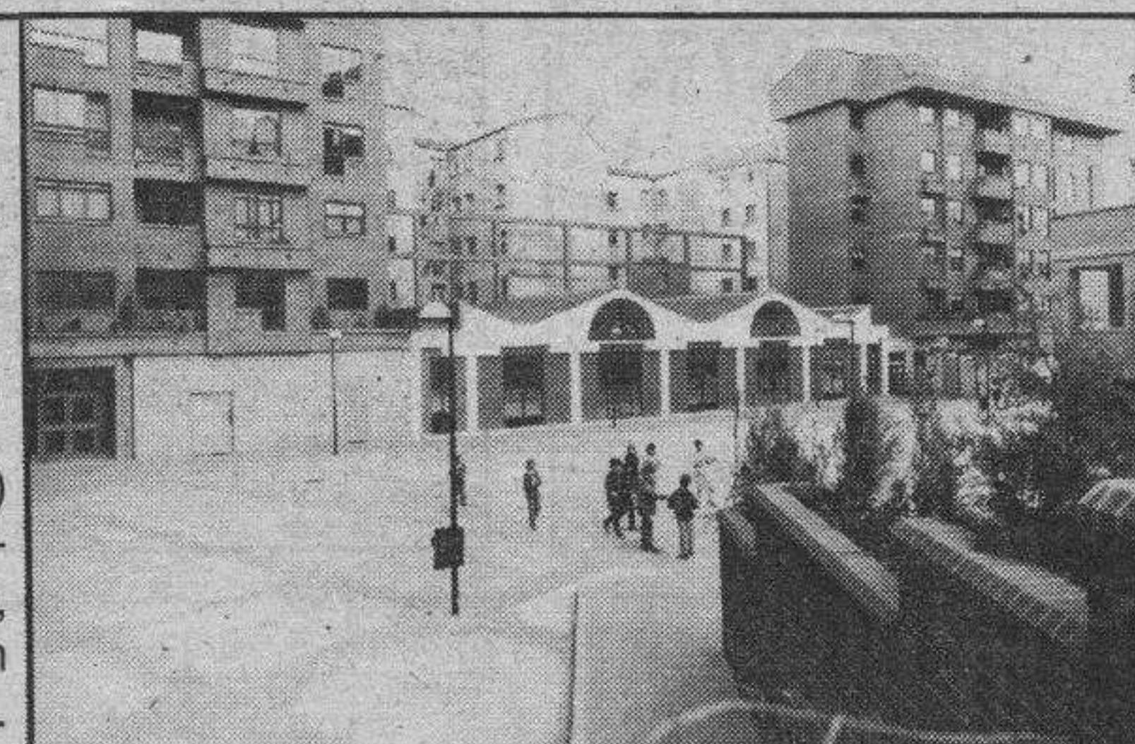
Cesión de un local (350 m 2 ) para Salón Social del Barrio-Zona San Francisco y Delicias, y ejecución de la urbanización de la Plaza de los Vadillos.
