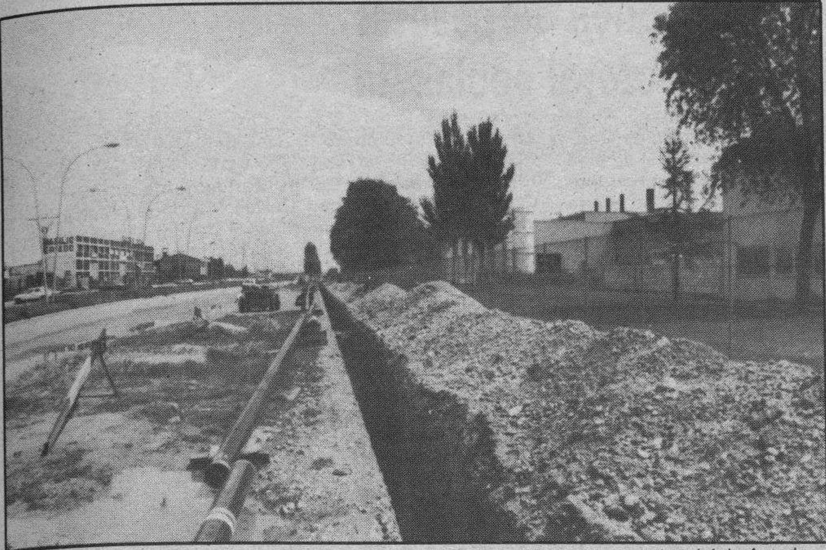
Estos días se está procediendo a la conducción del gas natural al polígono industrial de Aranda. Foto Lara.
