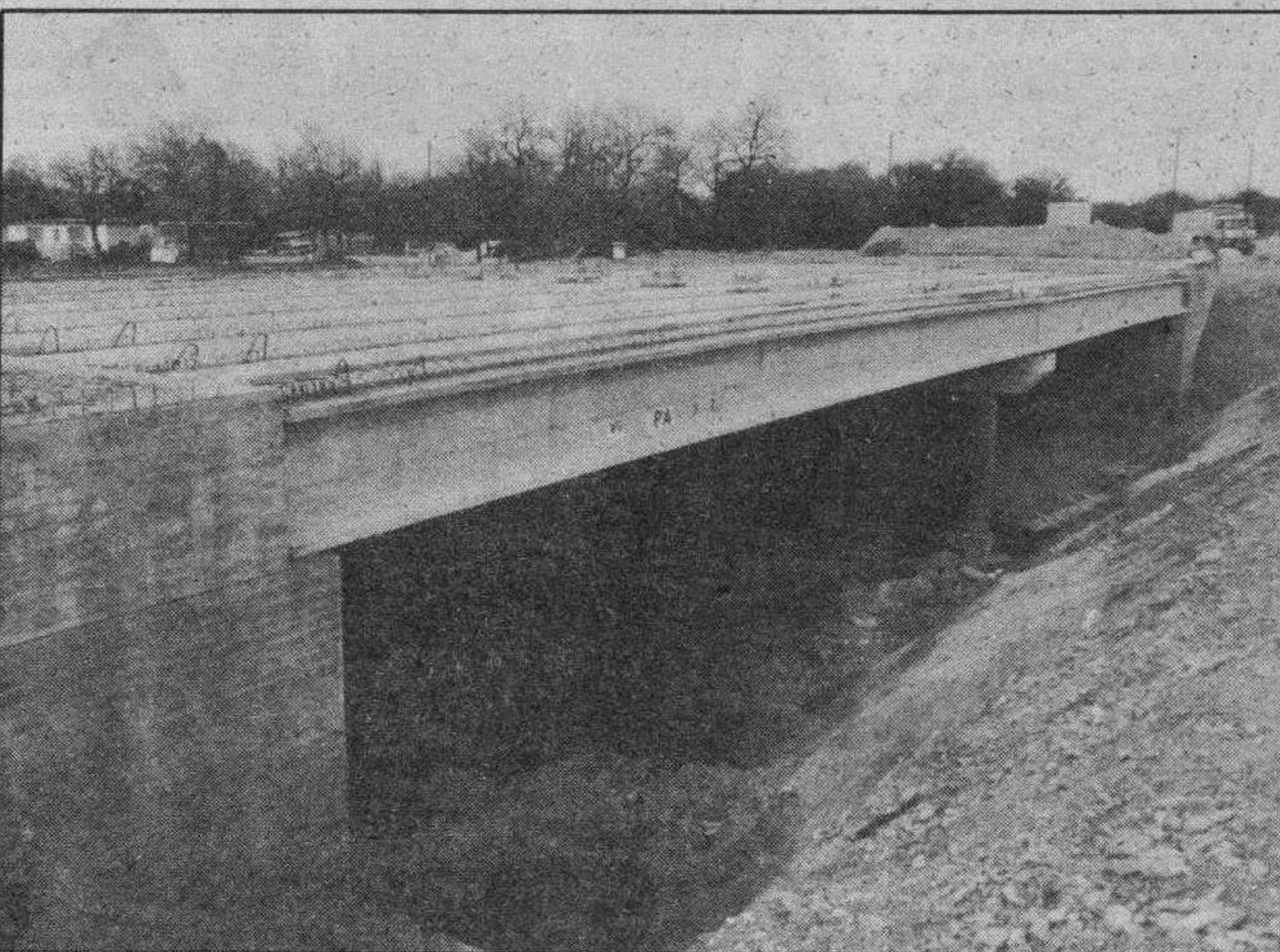
Obras de ferralla en el puente de la N-1.
