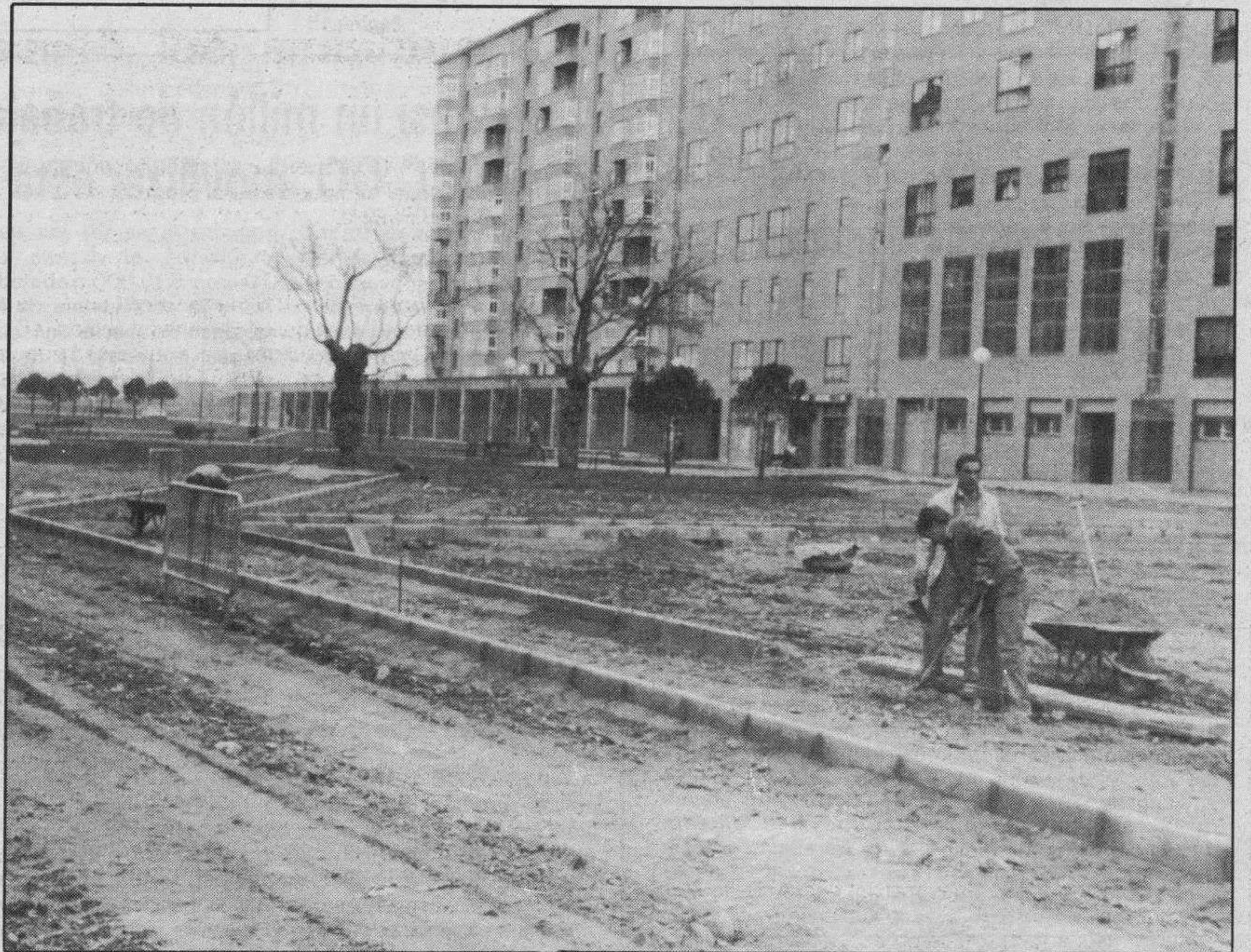
Configurando el nuevo parque. — En esta misma sección comentamos, en su día, la necesidad de crear una zona verde en la calle Manuel de Falla con amplios espacios. El Ayuntamiento está abordando ya esa iniciativa y la imagen recoge un momento de los trabajos en los que se configura una lugar de esparcimiento y recreo.
