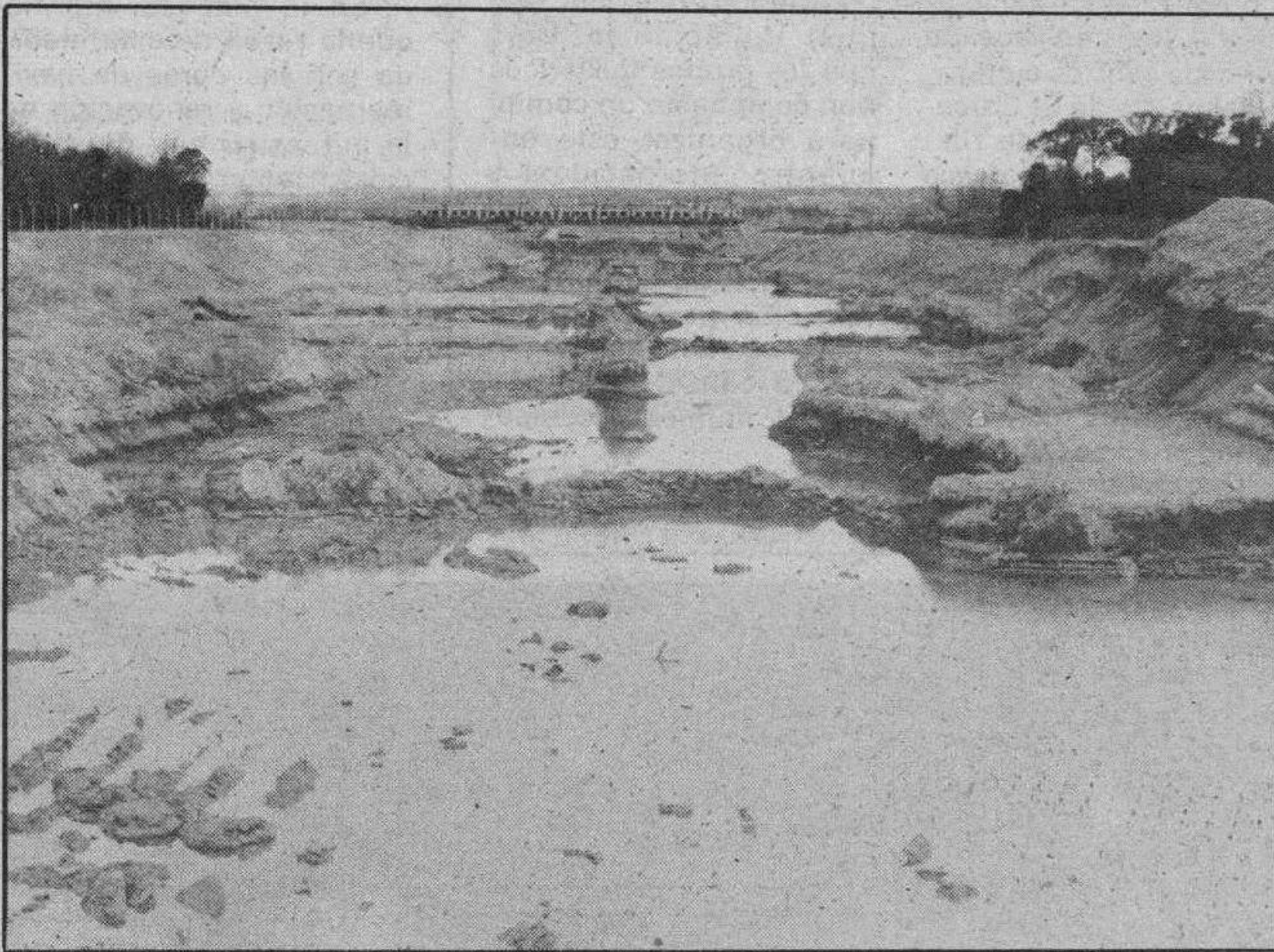
Lecho de la futura penetración en fase muy avanzada.
