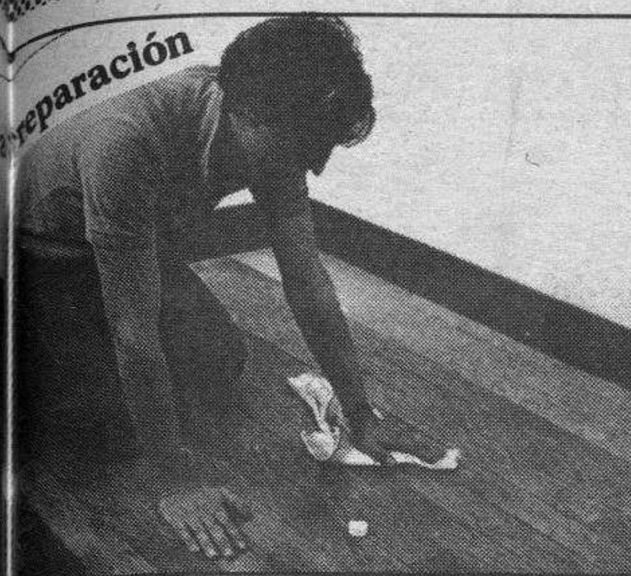
1.— La duración de vida de una moqueta depende de la calidad del soporte como de la calidad de la moqueta. Vuelva a clavar las tablas del parquet que están sueltas, cambie las defectuosas y encolado las tablas encerradas con un producto adecuado.
