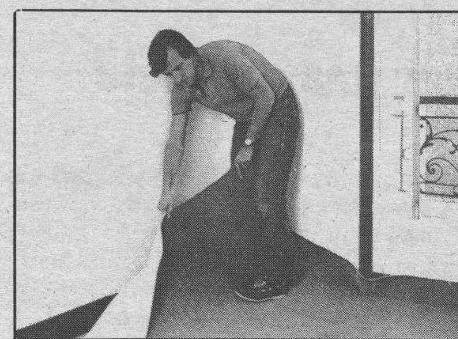
2.— Coloque la moqueta en la habitación de manera que cubra toda la superficie y que quede de 5 a 10 centímetros por encima del rodapié. Para colocarla con precisión, colóquese a caballo sobre un borde sujetando la moqueta con las dos manos y dé golpecillos con el talón.
