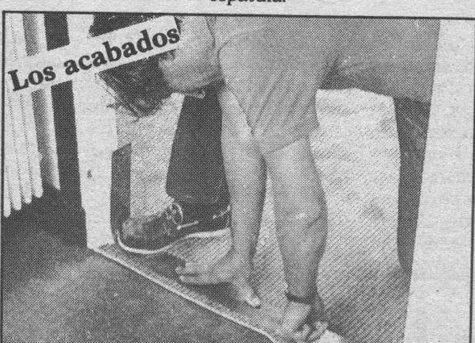
11.— Para la unión de las moquetas, a la altura de las puertas, deje una banda del suelo de unos 10 cms. de anchura sin encolar y superponga las dos moquetas. Apoyándose en una regla metálica, proceda a cortar la unión con el cuchillo de lámina recta cortando las dos juntas.
