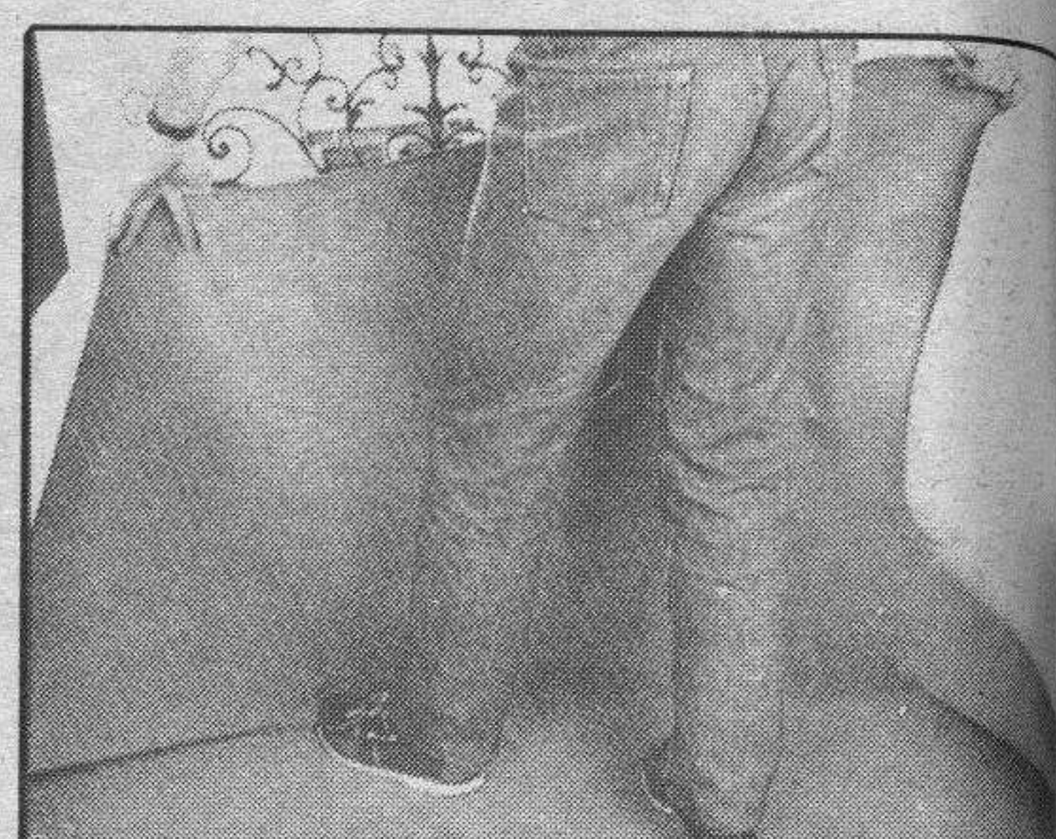
6.— Deje actuar la cola de 5 a 10 minutos, después, recogiendo la moqueta por el borde, extiéndala sobre el suelo encolado, colocándola con los pies a medida que vaya avanzando.
