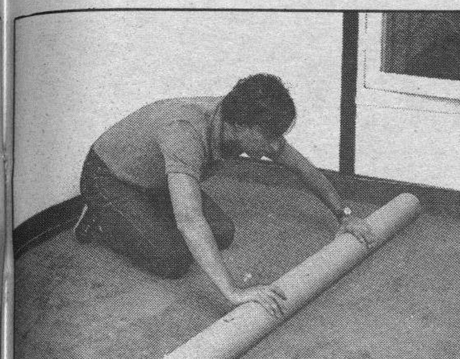
7.— Con las manos, o mejor, con el rodillo en la que estaba enrollada la moqueta, aplánala desde el centro hacia los bordes para quitar las posibles burbujas de aire.
