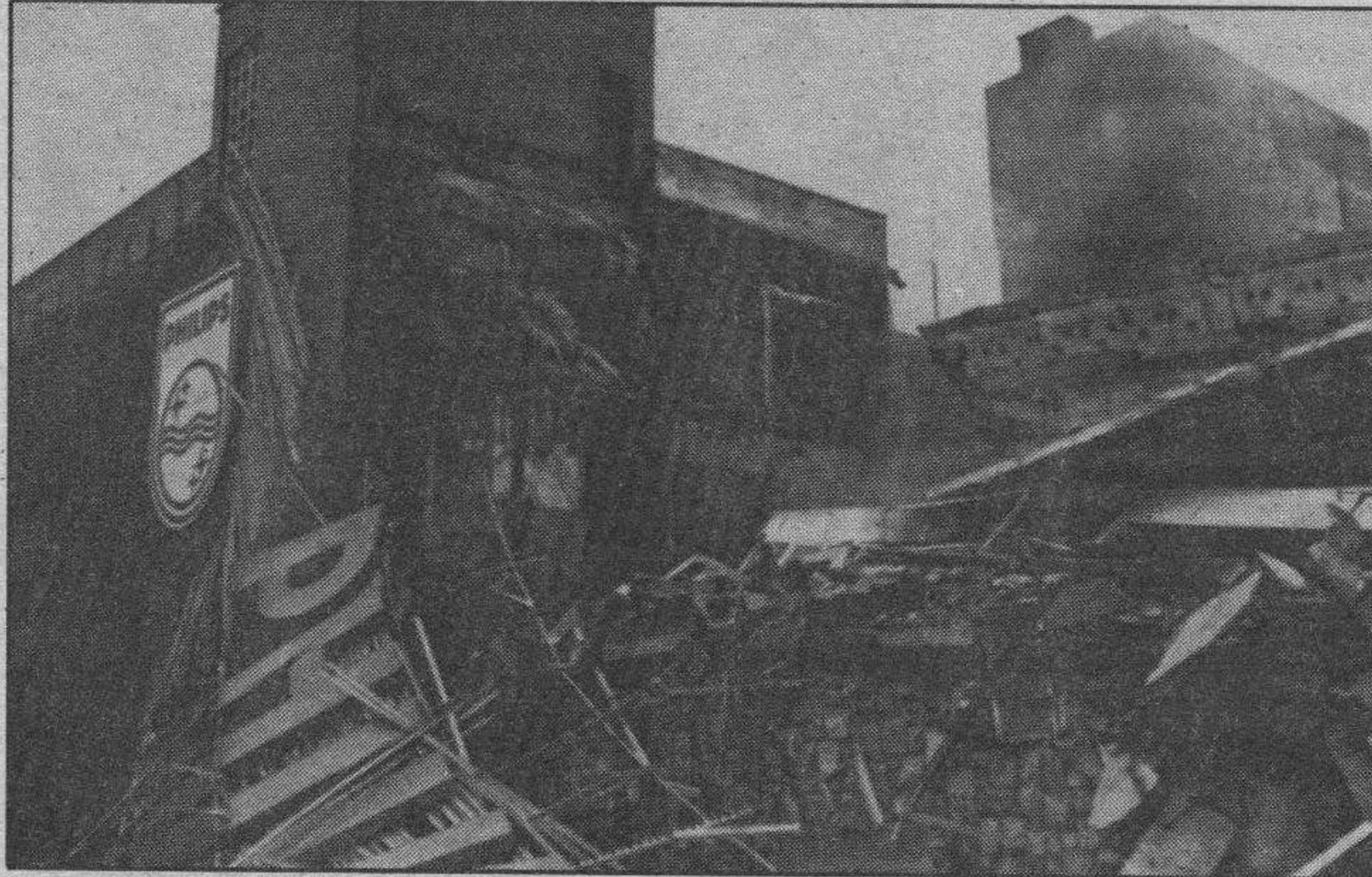
Estado en que quedó el edificio que albergaba el centro asistencial técnico de la casa Phillips, de la calle Albasanz, después de que un incendio, que comenzó a primeras horas de la mañana, lo destruyera. Telefoto Efe.
