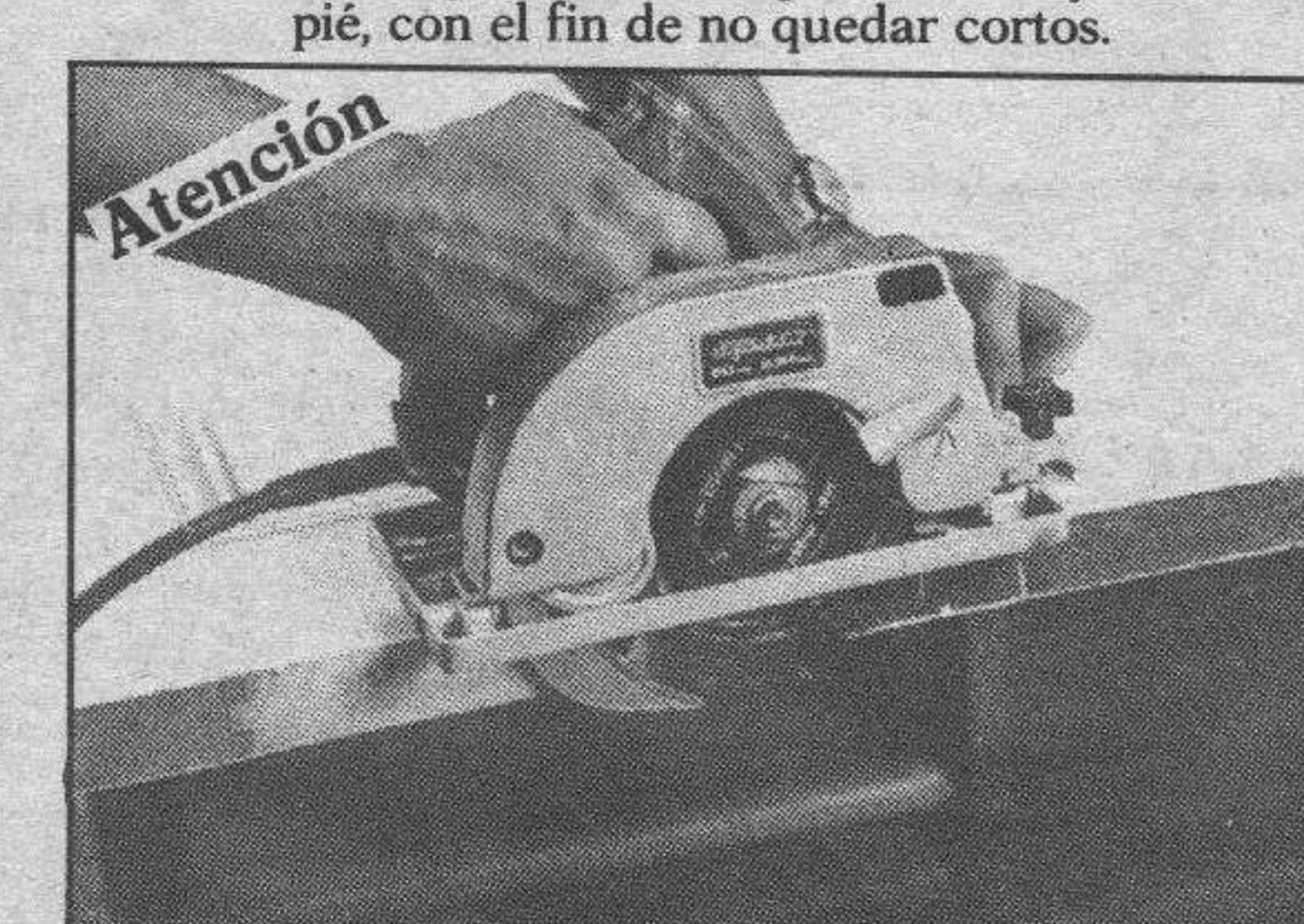
Atención 15.— Antes de pegar la moqueta, si usted tiene puertas que se abren hacia la habitación que va a enmoquetar, tendrá probablemente que rebajarlas algunos milímetros para que pueda pasar sin rozar la moqueta. Para ello, utilice una sierra circular.
