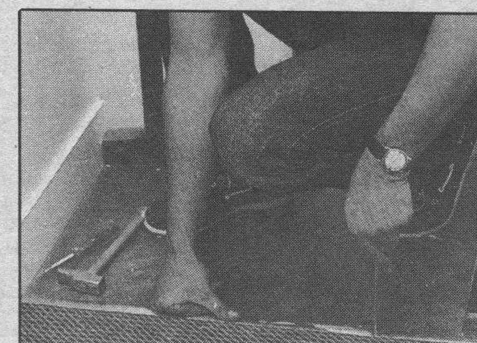
14.— Para hacer la unión con otro revestimiento, coloque una barra de latón poniéndola sobre la moqueta y el parquet.
