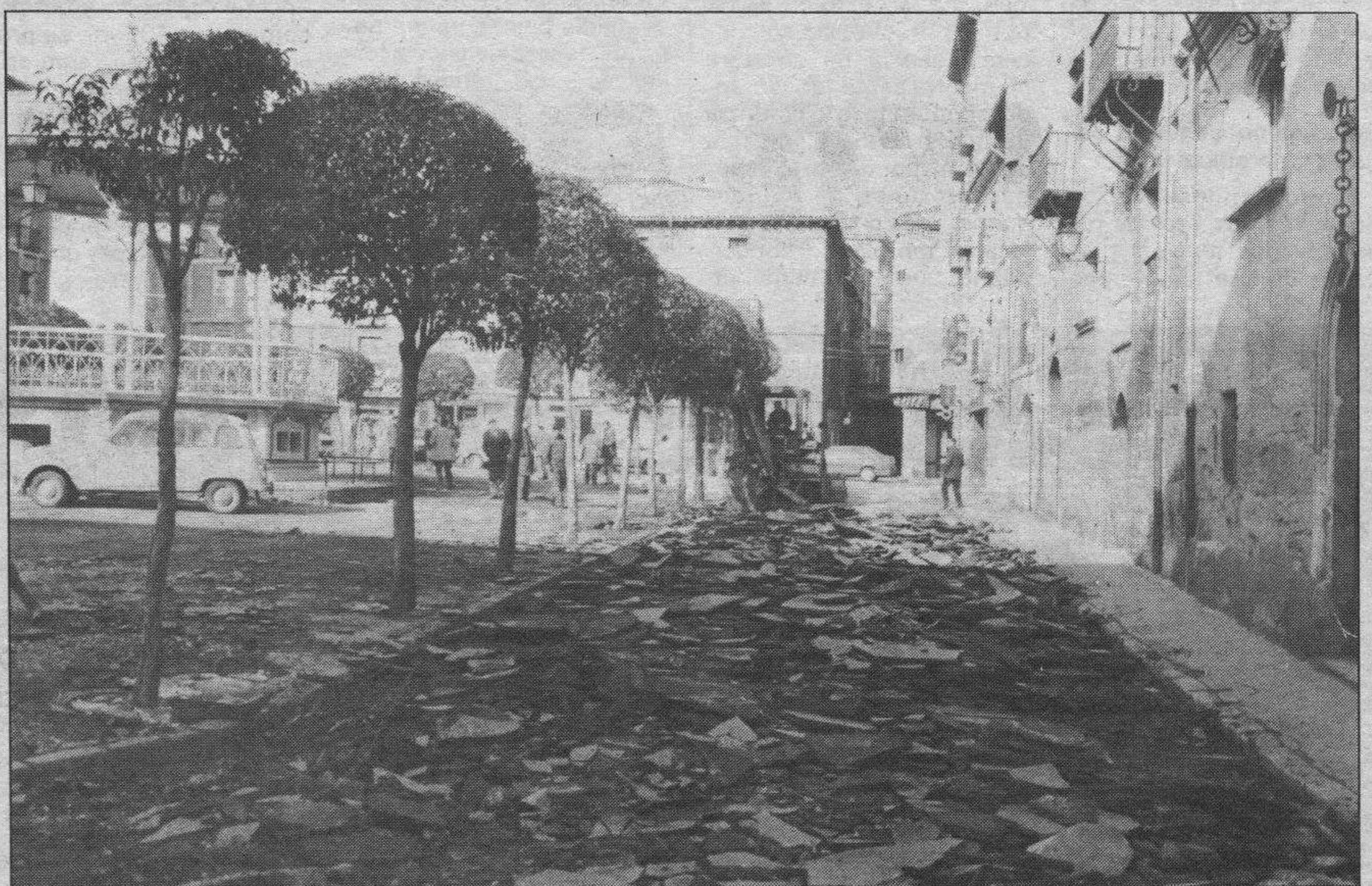
La plaza levantada. — El hombre propone... Las obras preliminares para la nueva pavimentación de la plaza de España, tuvieron como primer problema el temporal de nieve, que suspendió las tareas. Luego vino una avería en la conducción de aguas que se arregló rápidamente pero el martes, a la altura del número 4 de la citada plaza se producía otra rotura de tubería que obligó a un corte general en el sector que afectó a todo el vecindario y en particular a los cafés, y bares de la zona cuyos propietarios se vieron sin café y con bastante mala leche. Los fontaneros trabajaron de firme para arreglar el estropicio producido por el peso de la maquinaria que está operando sobre la plaza y sobre las seis y media de la tarde, el suministro de agua volvía a la normalidad. En cuanto a los árboles de la mencionada plaza, no es exacto que vayan a ser eliminados sino que lo serán en parte, unos ocho que posiblemente serán trasplantados al camino que conduce al monumento a San Juan Ermitaño, en La Laguna de San Juan del Monte. En la foto de Truchuelo, aspecto que ofrece la Plaza de España estos días. Cuando acaben las obras ya se la mostraremos a ustedes.
