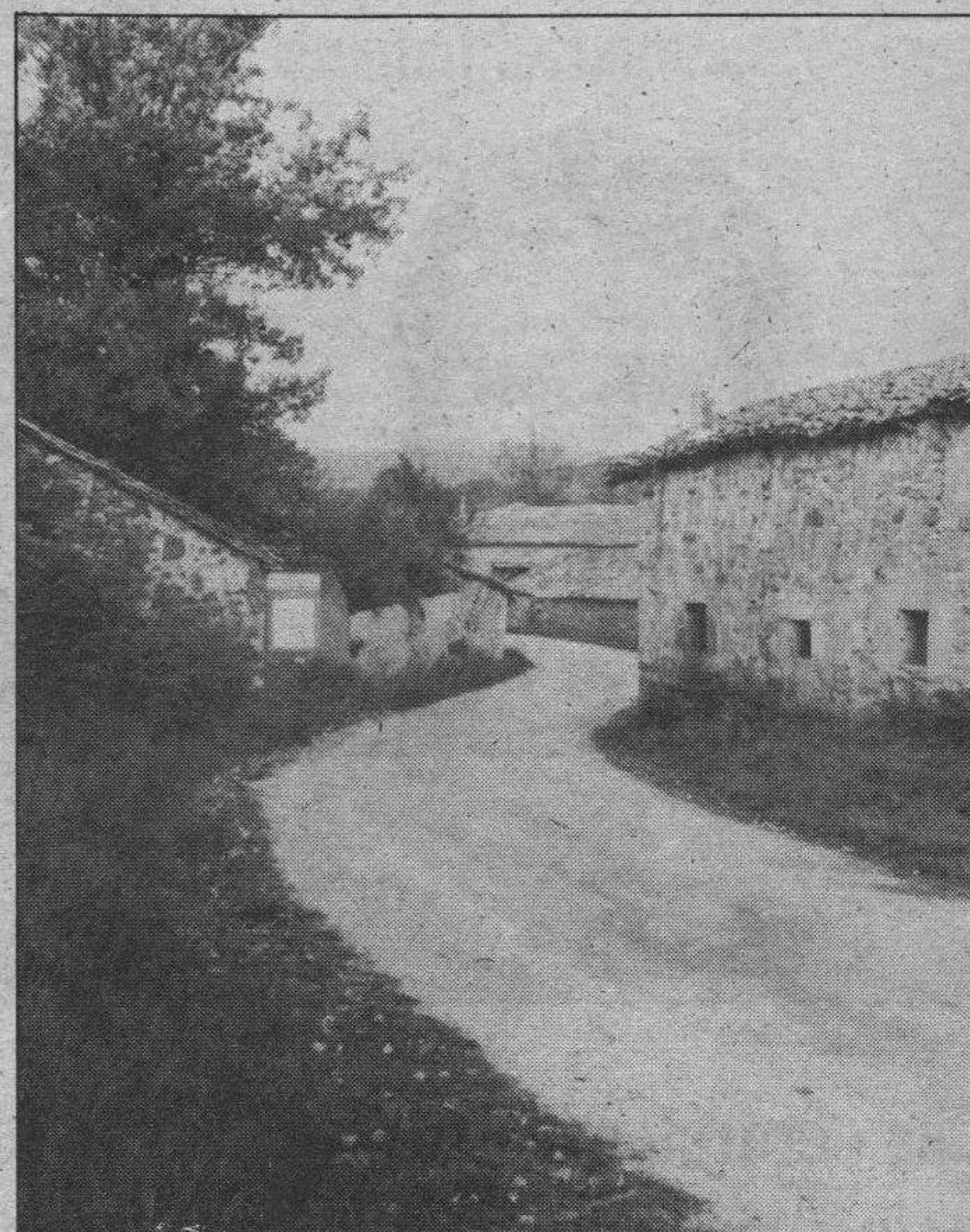
Villanueva de Puerta, travesía en dirección Villadiego - La Piedra.
