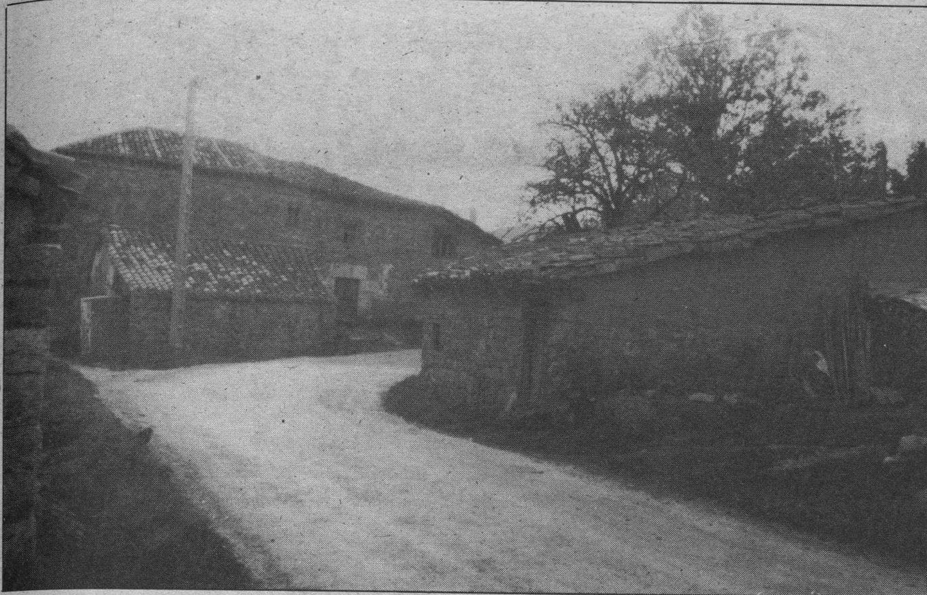
Villanueva de Puerta, travesía en dirección La Piedra - Villadiego.
