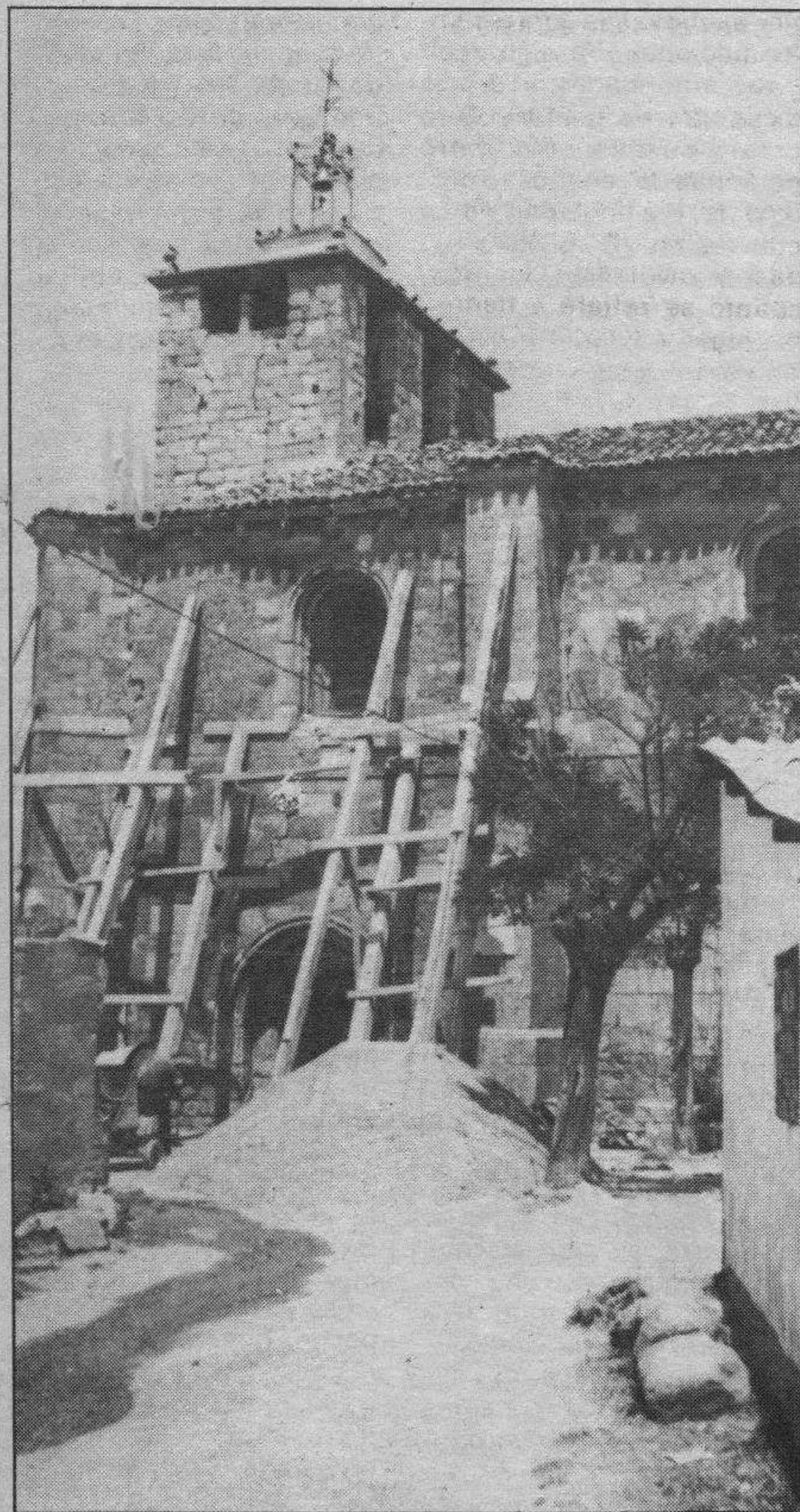
La iglesia de Santa María, en obras.
