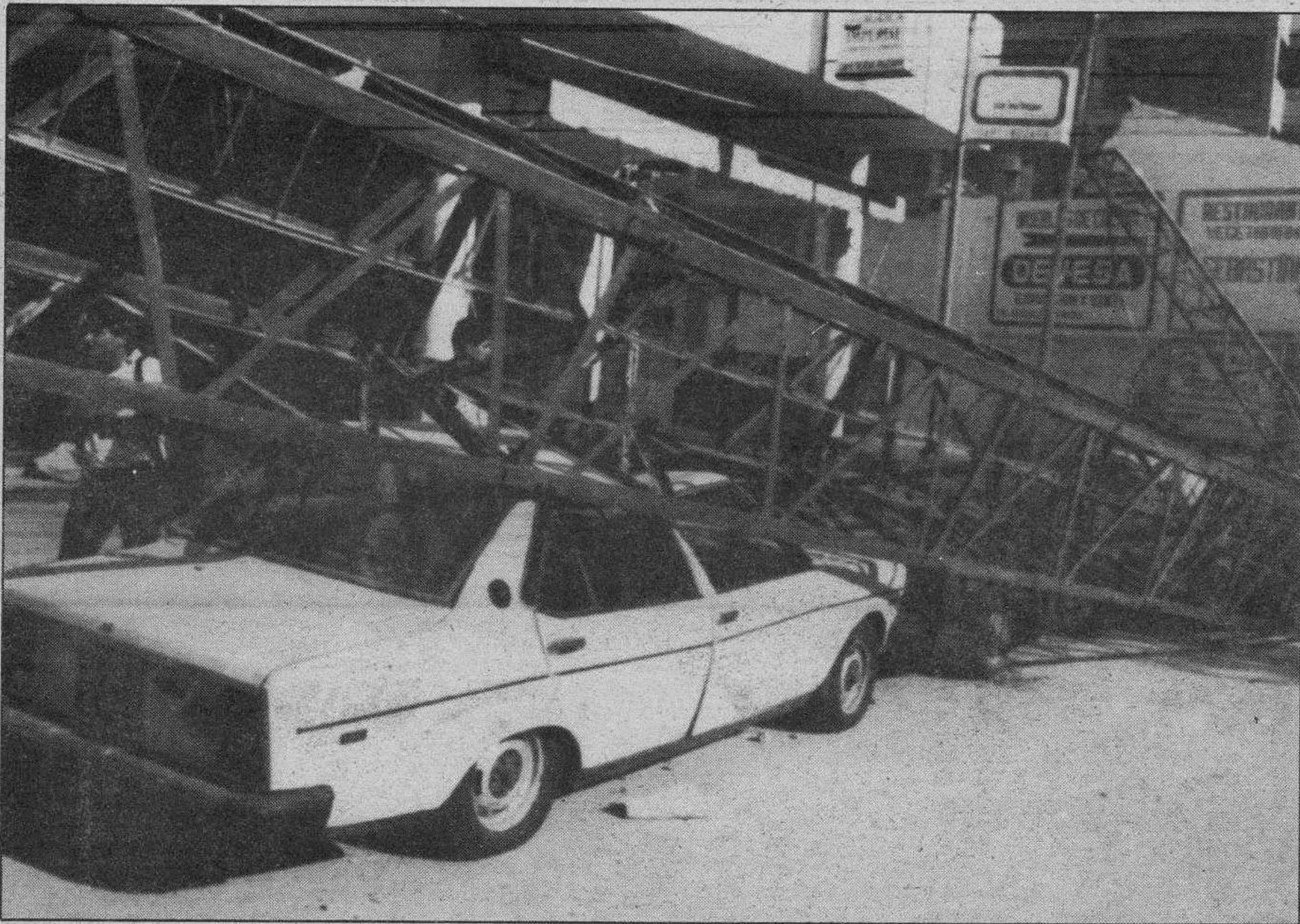
Aparatoso accidente. — En Benidorm, cuatro vehículos fueron aplastados por una grúa pluma, situada en una obra de ampliación de un hotel en la calle Ruzafa, que se desplomó por causas que se desconocen. A pesar del estruendo y aparatosidad que produjo esta caída, sólo quedó en susto, y afortunadamente no hubo que lamentar desgracias personales. — Telefoto Efe.
