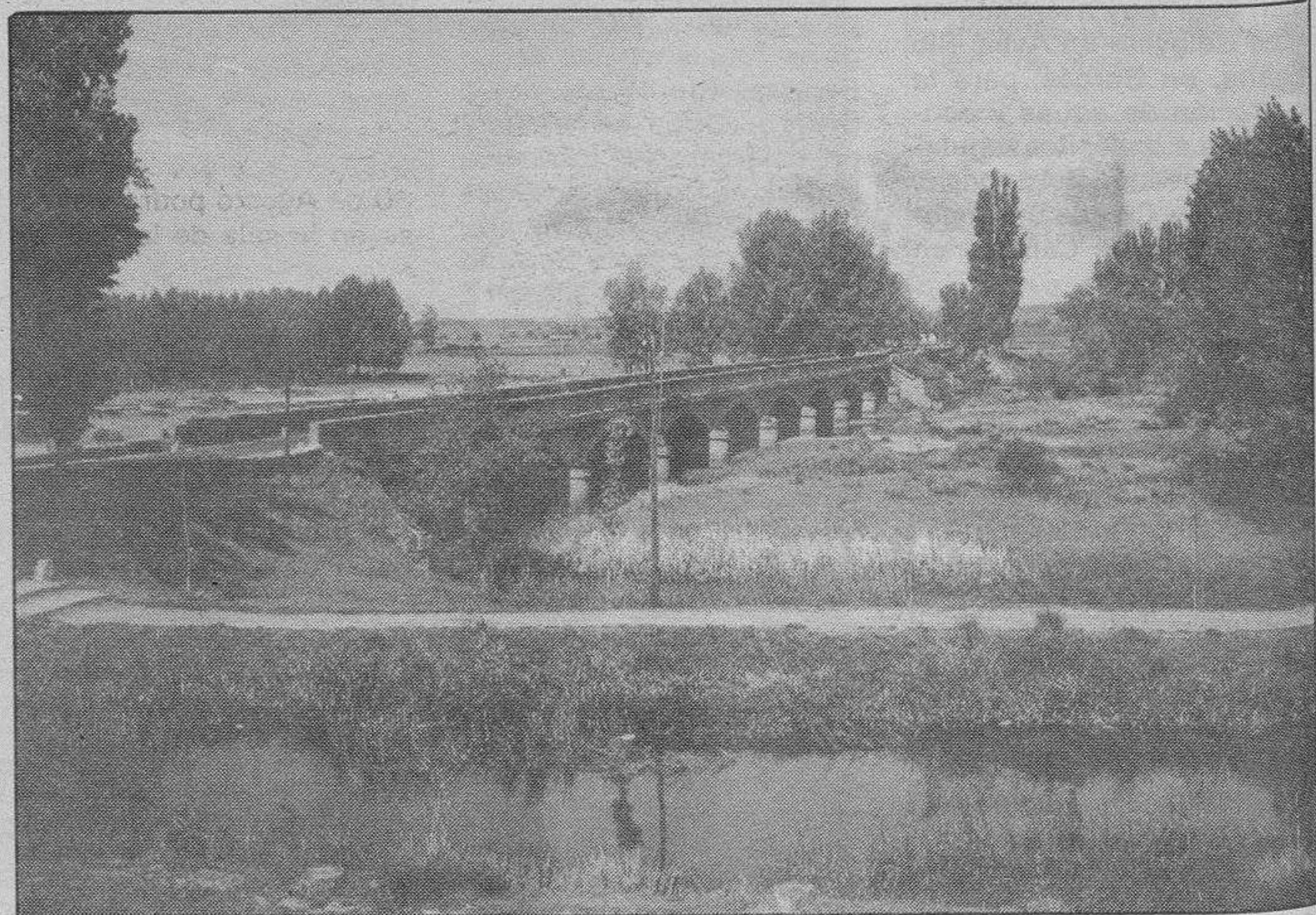
Puente sobre el río Pisuergra a su paso por Melgar.
