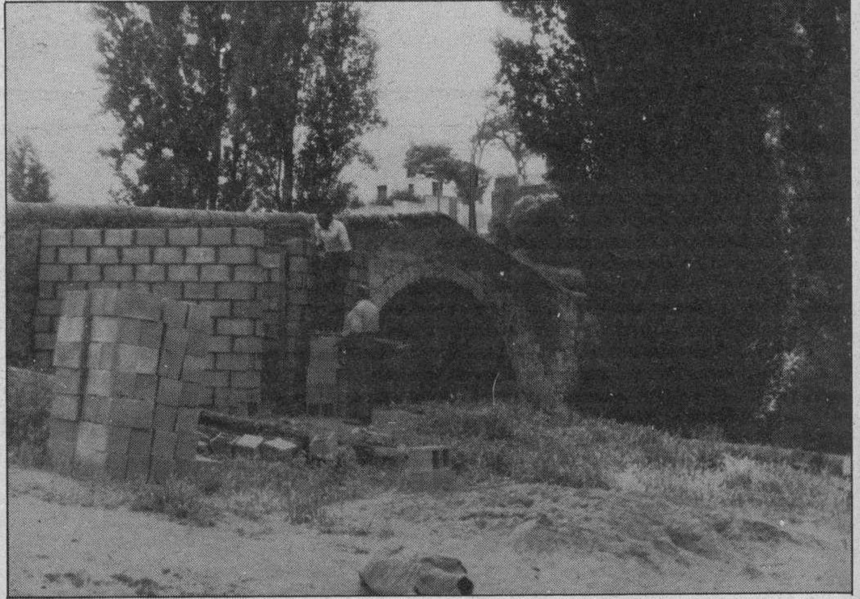
Adiós a la fotogenia de un puente, por lo menos por unas semanas. El motivo, guardar las herramientas de las obras que se llevan a cabo en su entorno. Los vecinos, con voz pero sin voto, dicen: ¿es que no hay sitio menos visible? Foto Lara.
