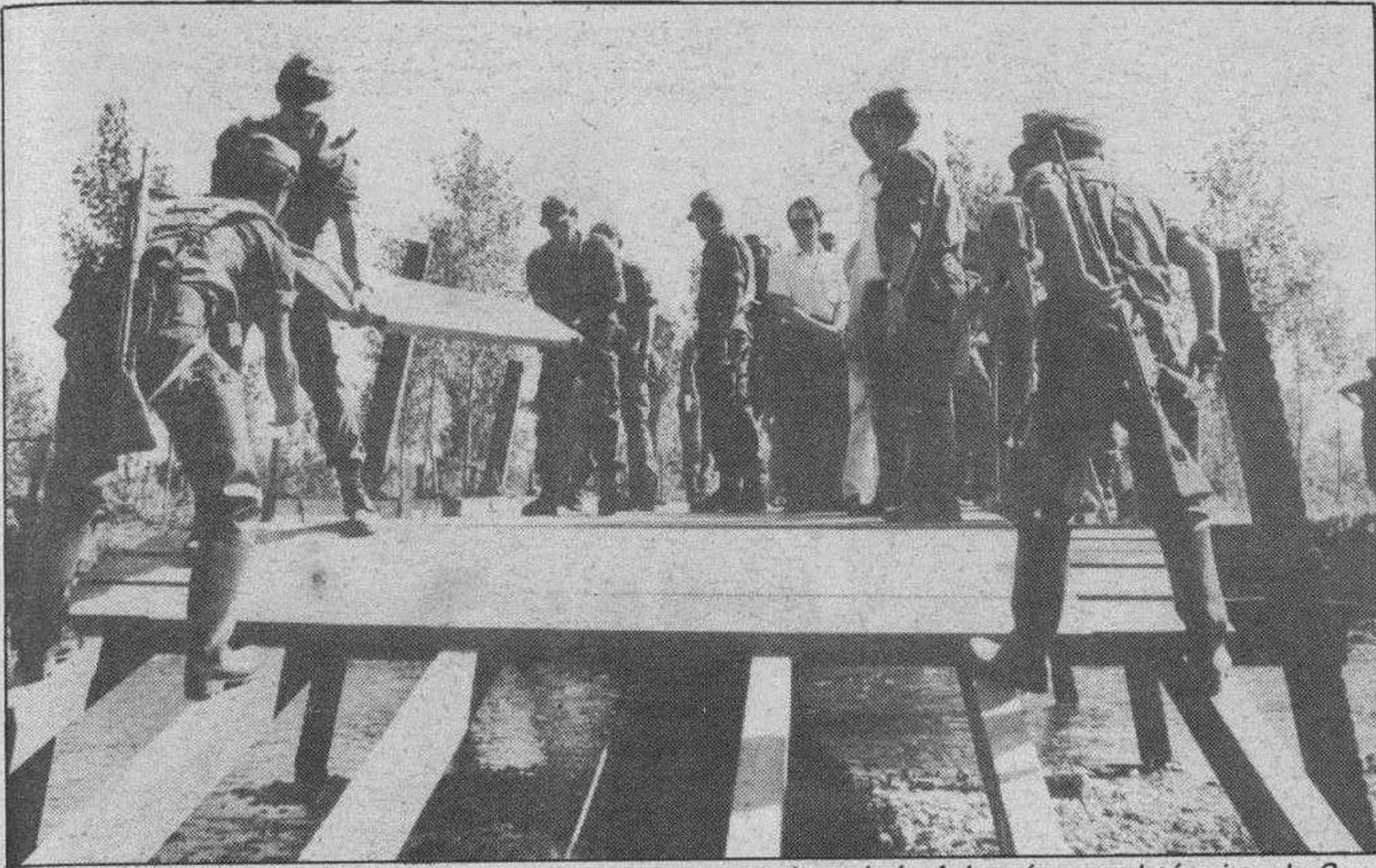
Soldados del Arma de Ingenieros tienden un puente sobre el río Arlanzón, en el término de San Medel.
