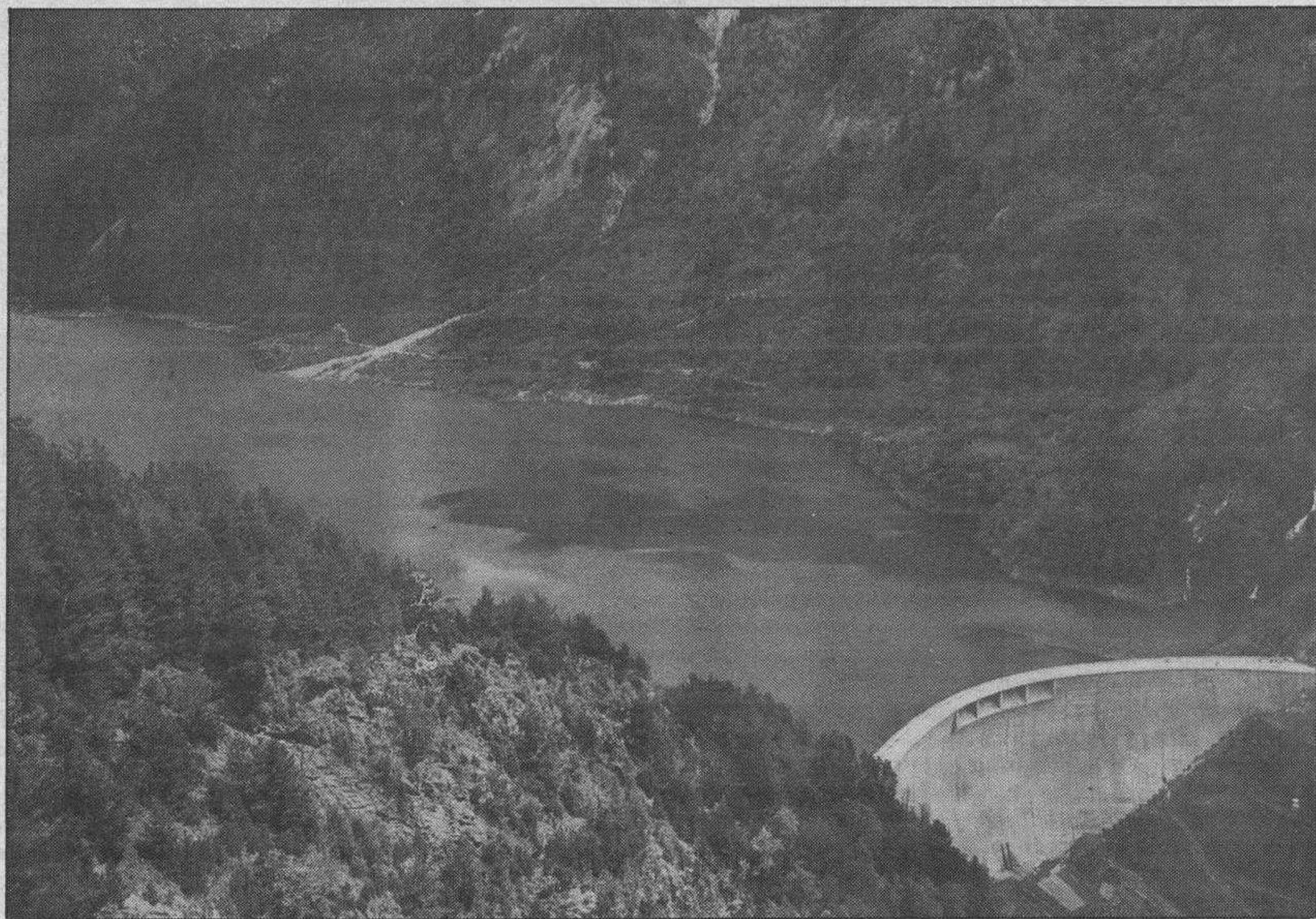
Central hidroeléctrica de Moralets.
