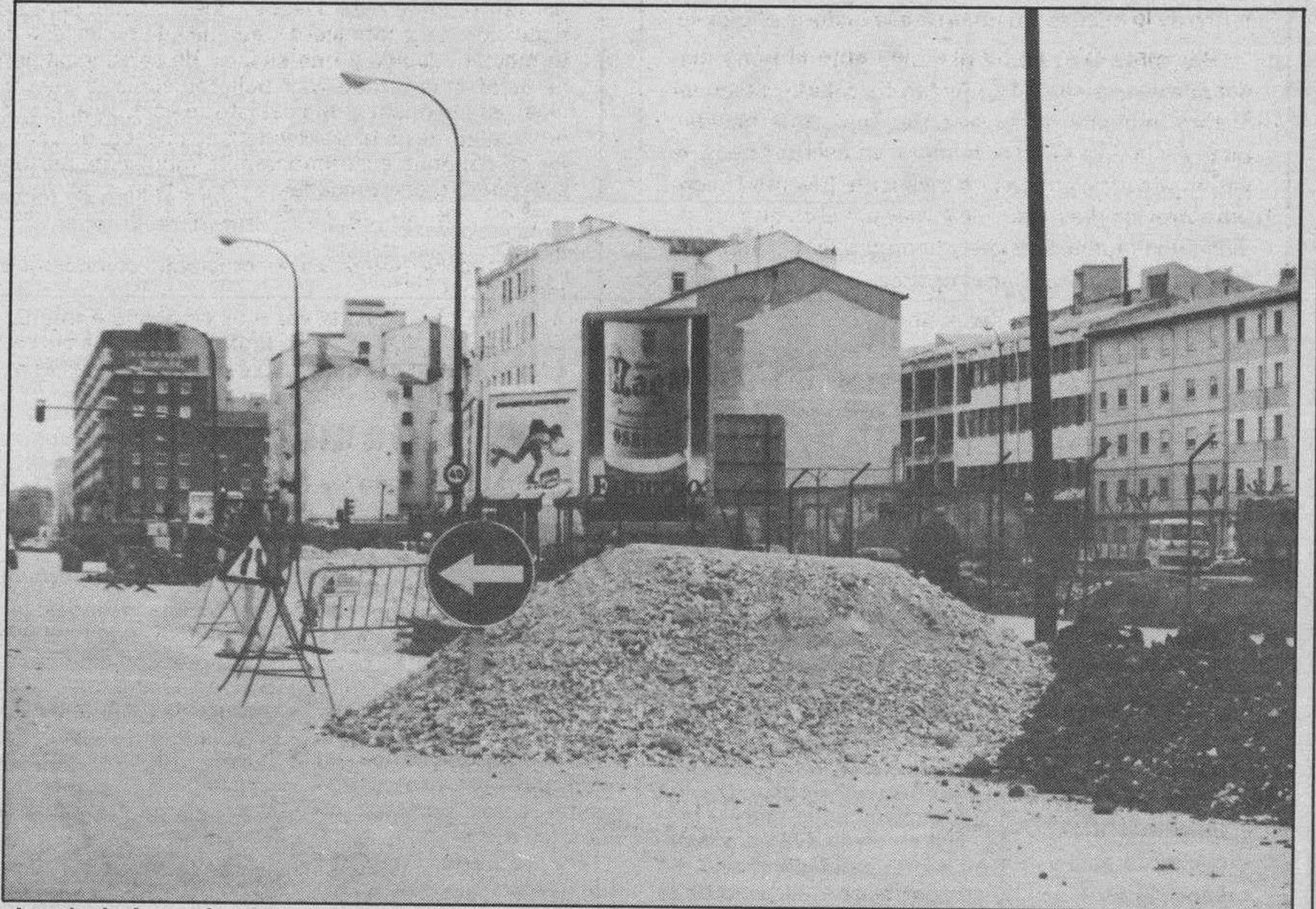
La ciudad en obras. — Como consecuencia del tendido de las conducciones del gas, «media ciudad está levantada». Son los inconvenientes transitorios del progreso, pero ello al final es una ventaja. Los trabajos que muestra la fotografía corresponden a la avenida de Yagüe, una de las grandes arterias burgalesas, también en obras en estas fechas.
