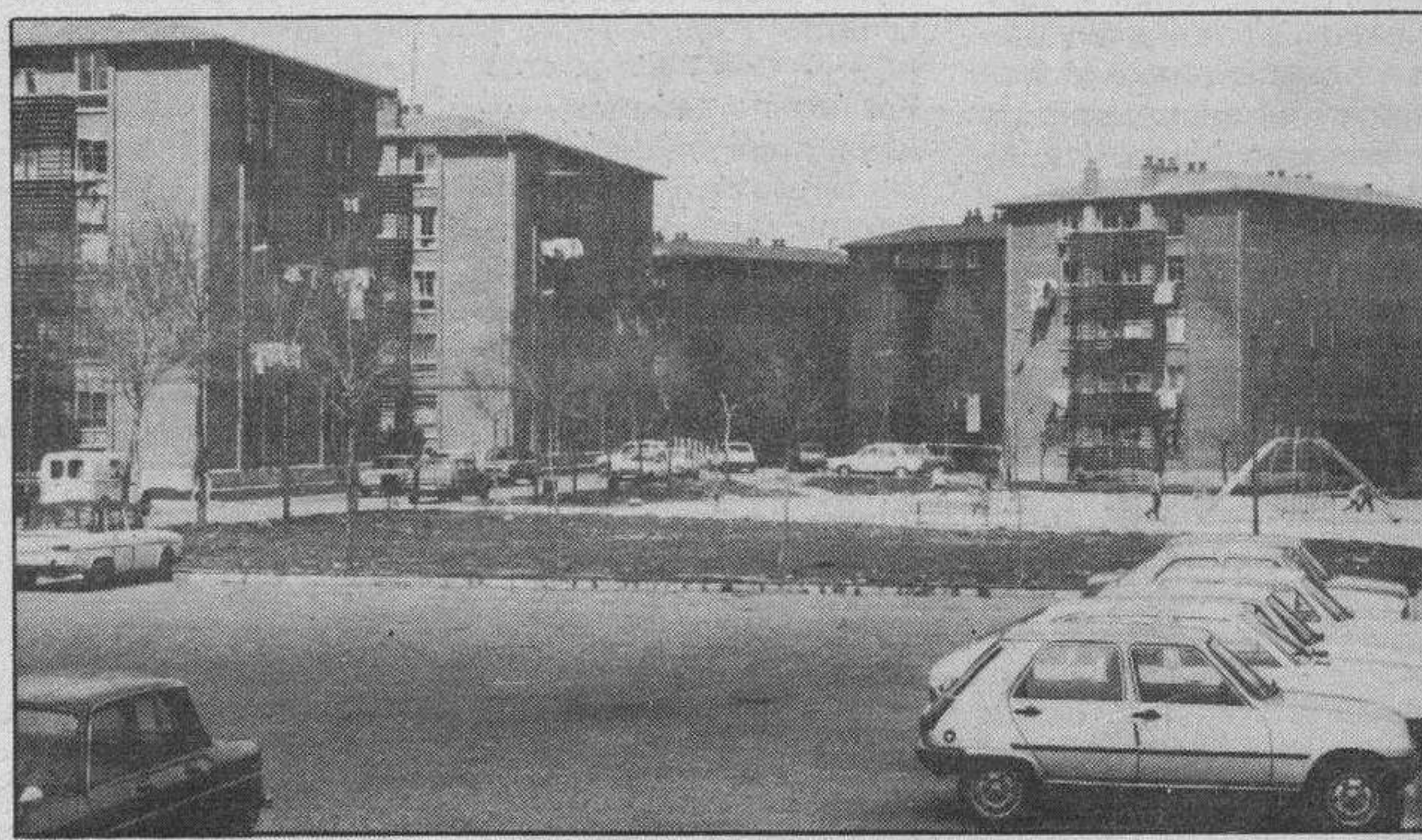
Centro de la moderna barrida de San Cristóbal.
