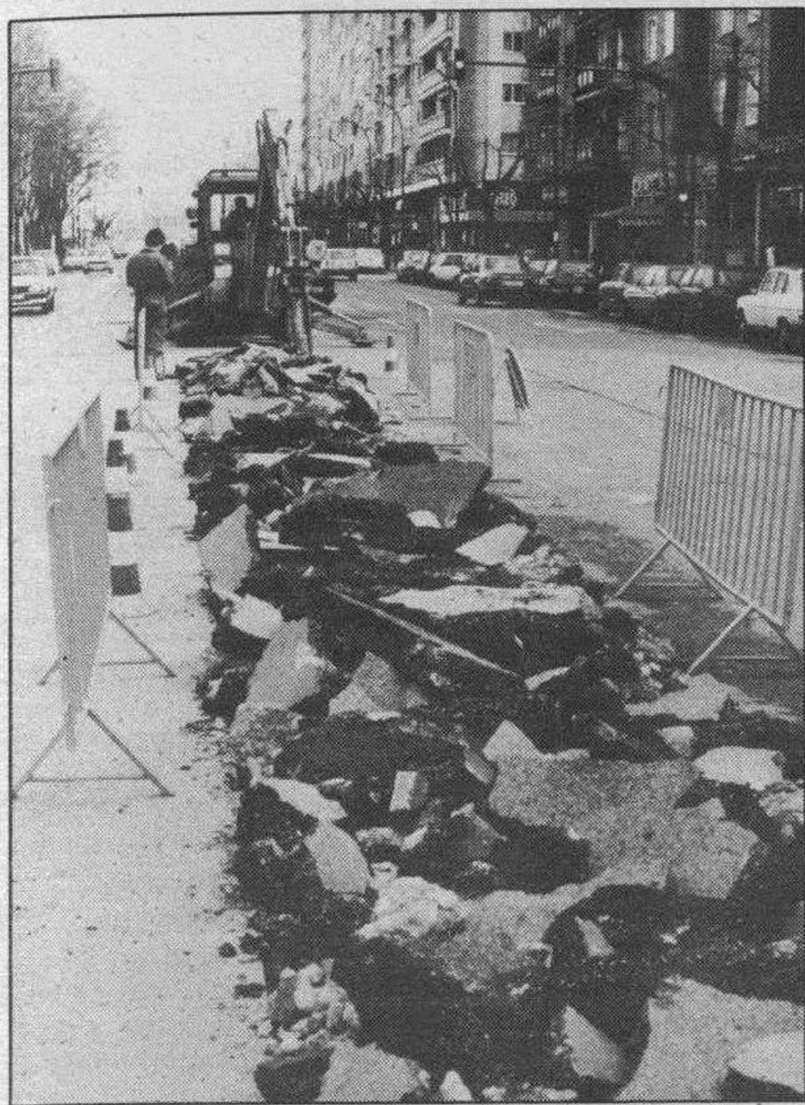
Obras hidráulicas. — La calzada de la avenida del Cid comenzó ayer a ser levantada, dando así inicio al proyecto de construcción de una red arterial hidráulica por parte del Servicio Municipal de Aguas. El gasto es de cuarenta y siete millones de pesetas. Los burgaleses se preguntaron ayer sobre la razón de estos trabajos que supondrán una mejora en las dotaciones a nuestra capital.
