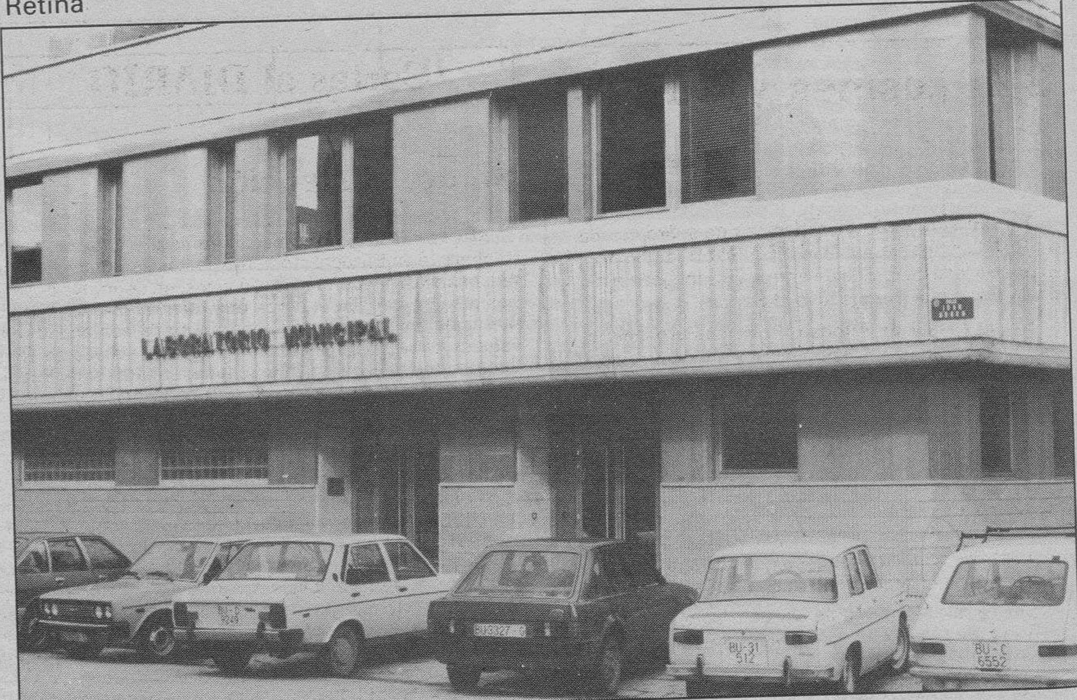
Sanidad municipal se agrupa. — Con el traslado a la sede del Laboratorio Municipal, en la calle Juan Bravo, de los servicios sanitarios, incluido cementerios, que hasta ahora se venían prestando en las dependencias ubicadas en los bajos del Teatro Principal, frente al Palacio Provincial, se ha reagrupado de alguna forma la Sanidad municipal en un mismo edificio. Esto va a suponer, a pesar de que han aumentado las distancias, una mejor atención al público y una mayor agilidad administrativa. Por otro lado, los servicios de Asistencia Social van a disponer en las dependencias municipales del paseo de El Espolón de un mayor espacio para realizar sus trabajos.
