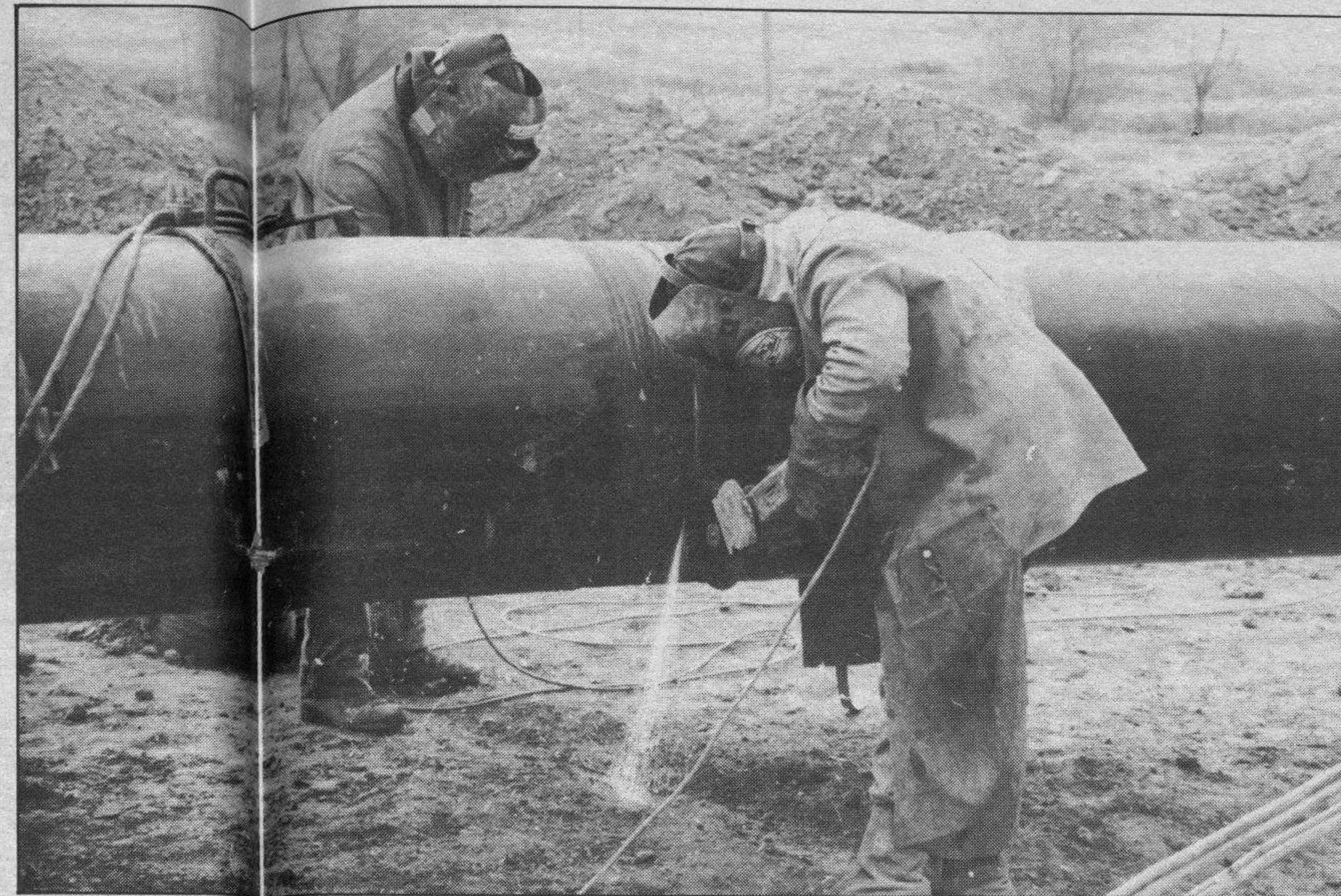
Trabajos de construcción del gasoducto, en las proximidades de Burgos.
