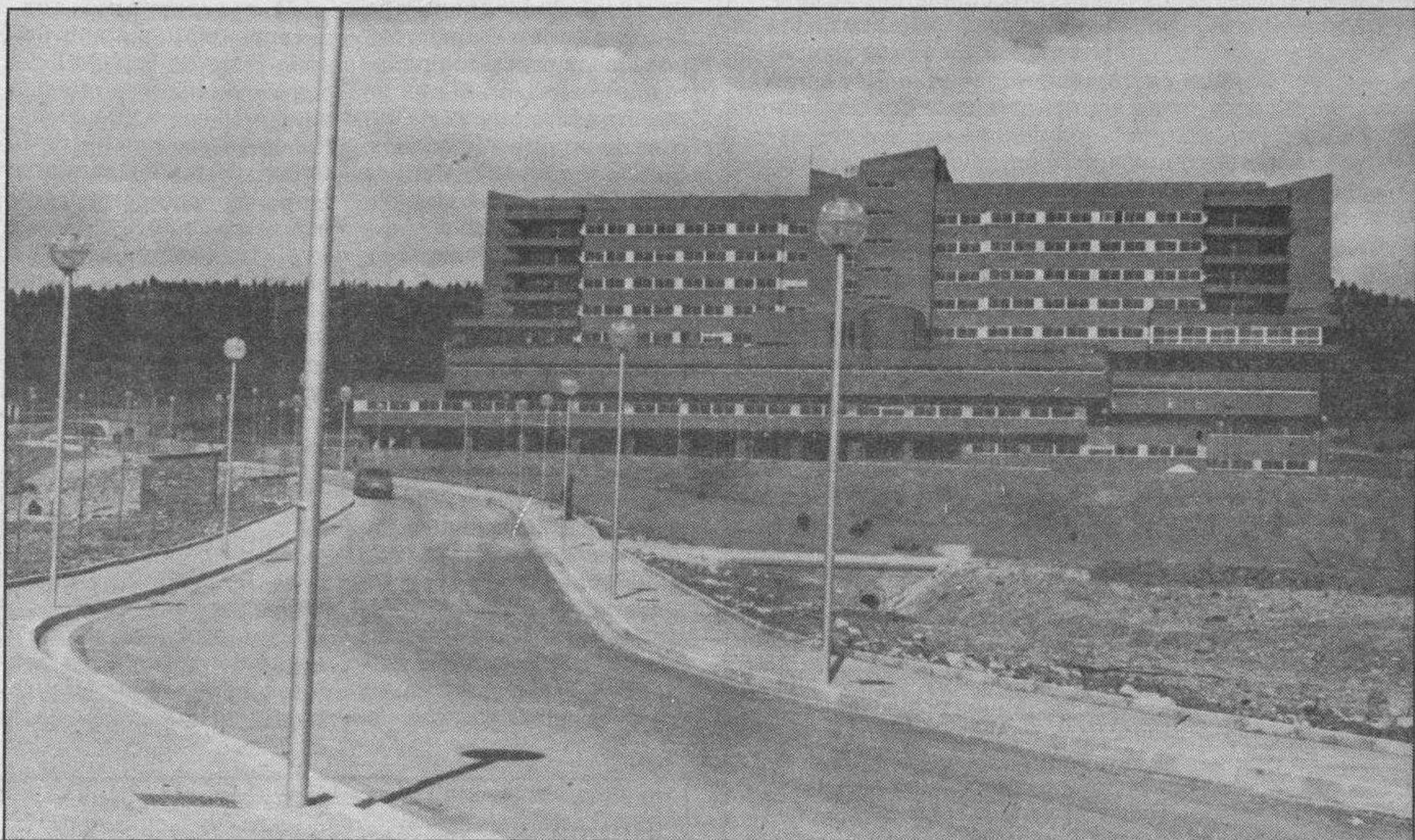
EL NUEVO HOSPITAL, A PUNTO. — El nuevo Hospital Provincial de la Diputación Provincial está ya prácticamente terminado. Ayer viernes se registró la primera visita a las instalaciones por parte de alumnas del Colegio de las RR.MM. Concepcionistas. Quedan únicamente por concluir los trabajos complementarios de los accesos.
