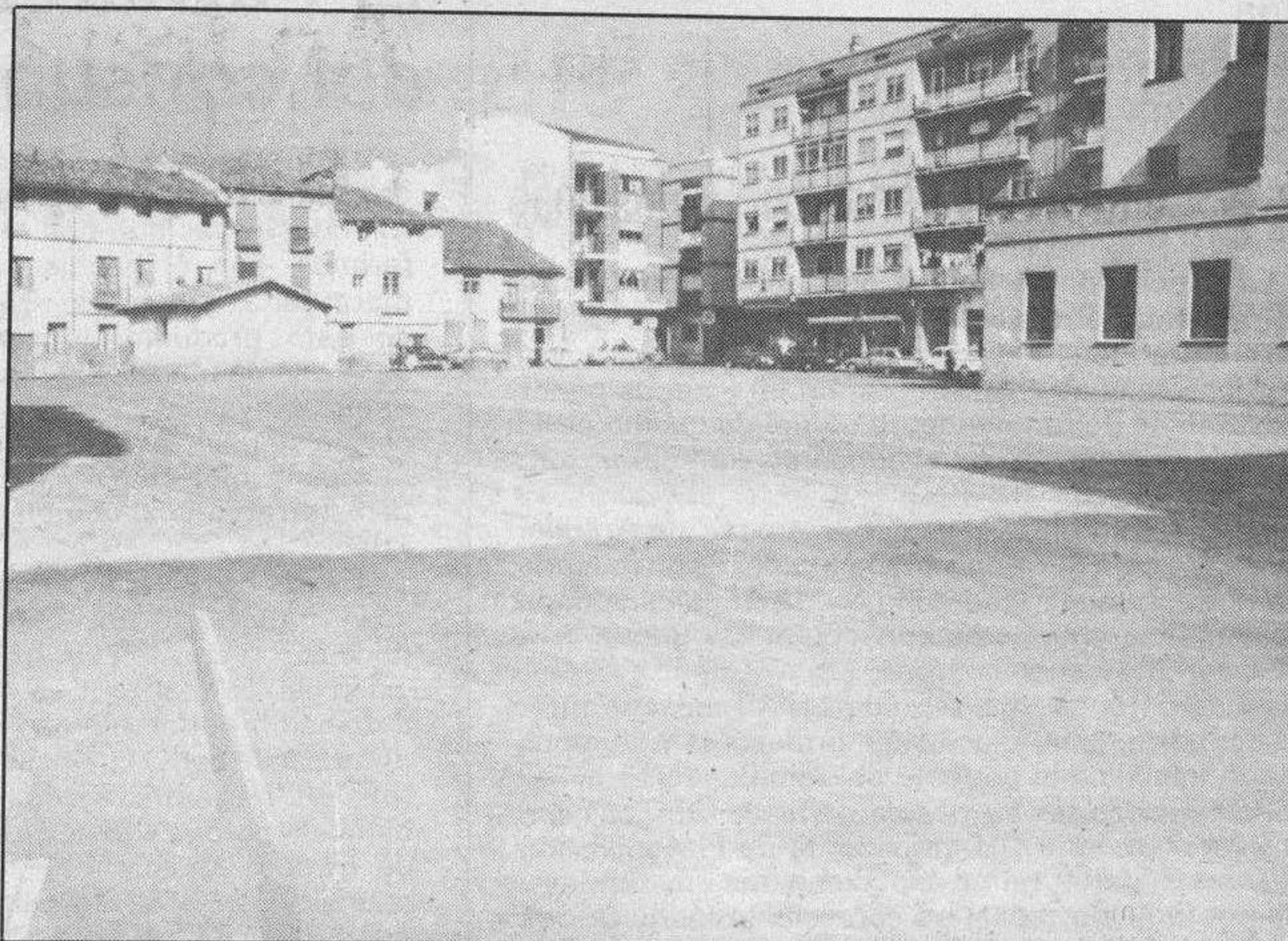
El solar de la Plaza del Trigo actualmente ocupado por un aparcamiento que atiende la Asociación de Minusválidos es un caso de obra a medio terminar. Se extendió sobre él una capa de zahorra pero faltan los trabajos de compactación. De lo contrario habrá sido un gasto inútil. (Foto Florentino Lara)
