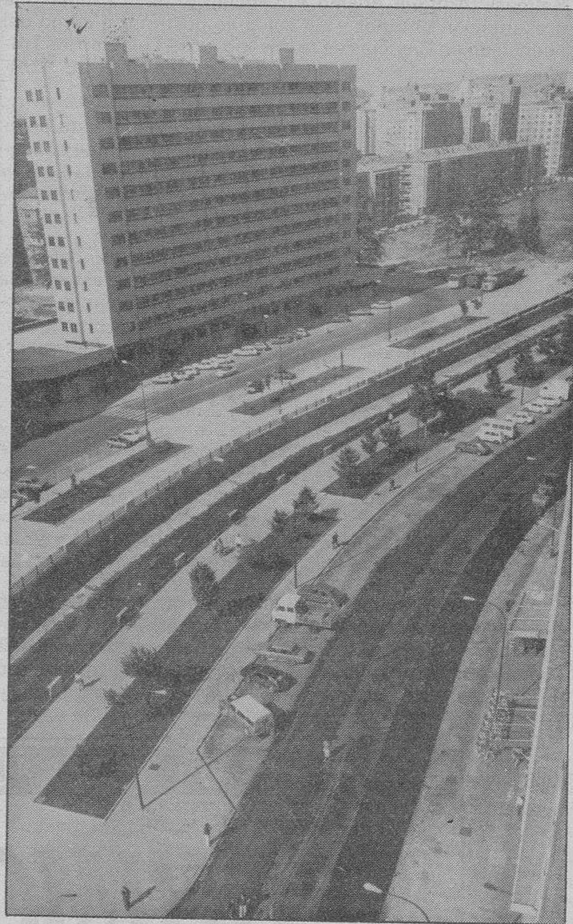
Asfaltado de la Avda. de los RR. CC.
