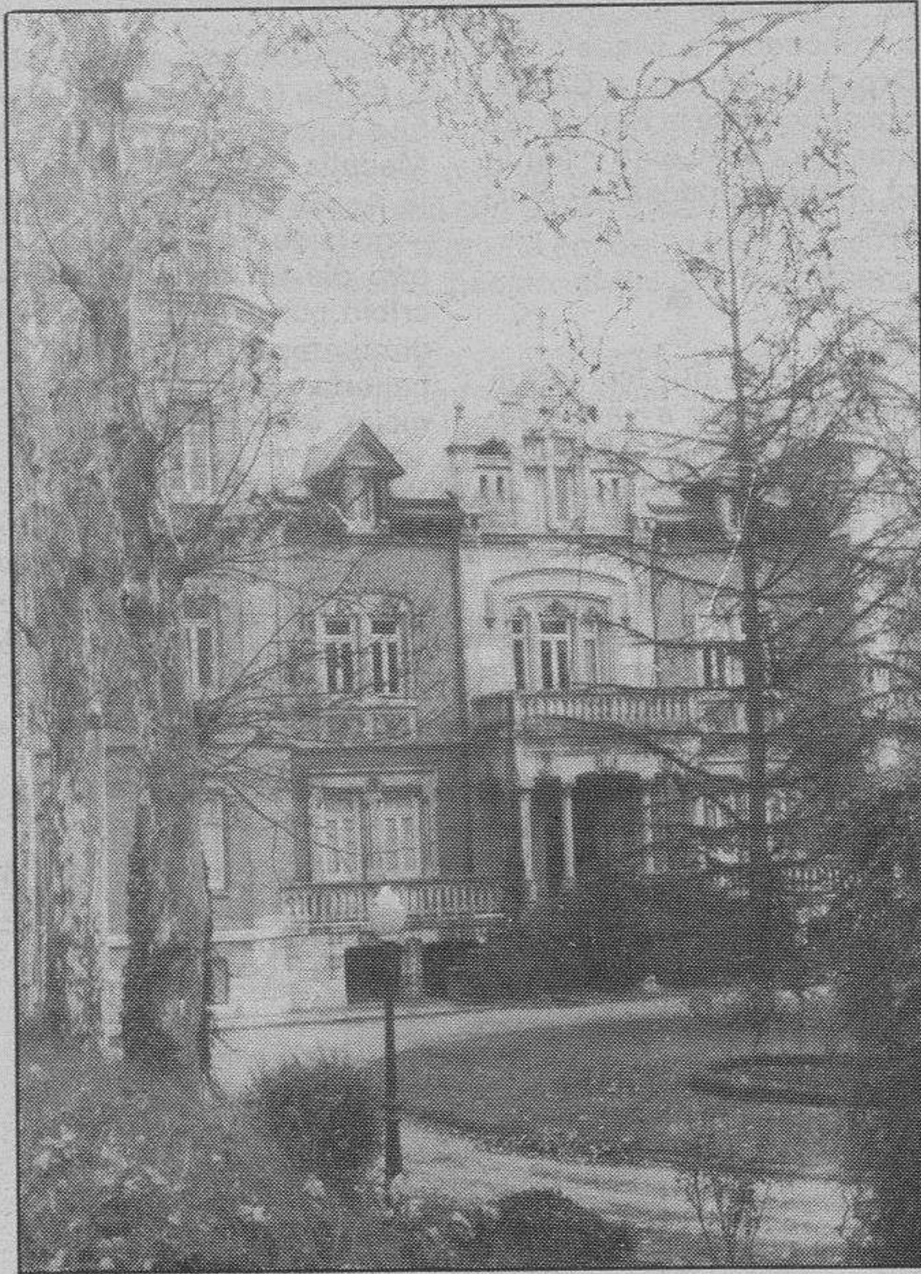
UN DESTINO PARA ESTE PALACIO.—Desde hace ya varios meses la Diputación y el Ayuntamiento de Burgos tratan de llegar a un acuerdo para dar destino al Palacio de la Isla, un tema pendiente sobre el que urge tomar una resolución para la mejor conservación del noble edificio.
