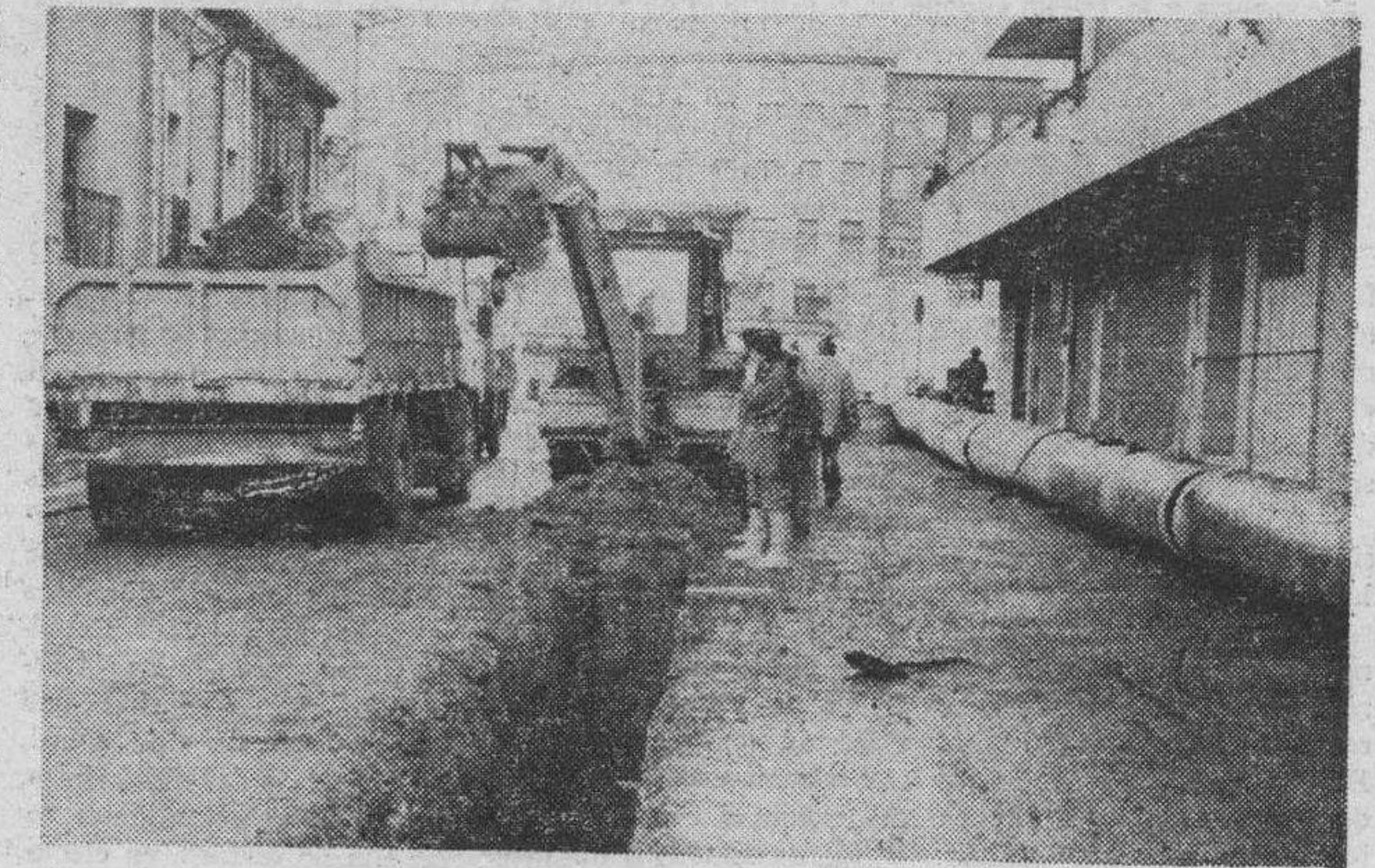
La fotografía de «Fede» corresponde a las obras del nuevo colector de la zona de las Casillas, que lleva a cabo el Ayuntamiento.
