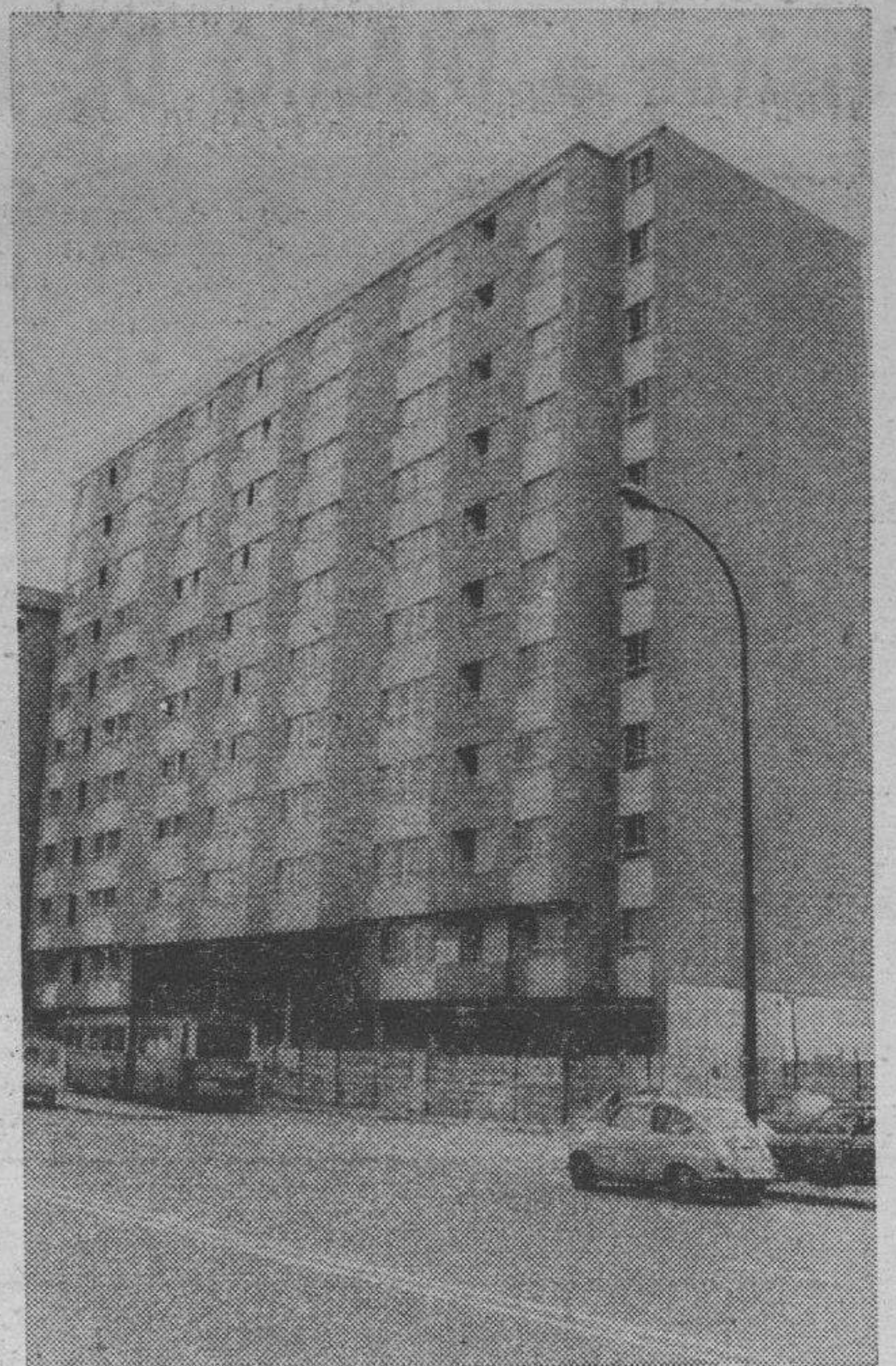
Este es el bloque de viviendas que ha construido el Ayuntamiento en el polígono «G-9». — (Foto FEDE).
