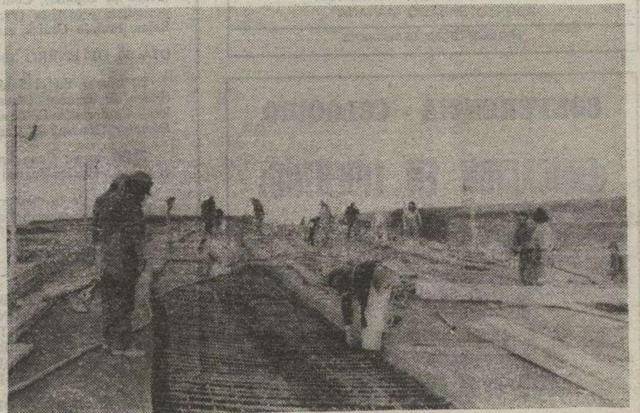
Doce horas seguidas se ha trabajado para el hormigonado del puente de la carretera de circunvalación sobre la N-1, a la altura del Landa Palace. La operación ha necesitado la utilización de setecientos metros cúbicos de hormigón, doce camiones-cuba y todo un equipo de especialistas. Poco a poco se va configurando la carretera que unirá la Madrid-Irún con la Burgos-Portugal, evitando el paso por el centro de la ciudad (Foto FEDE). — (Información, en páginas interiores)
