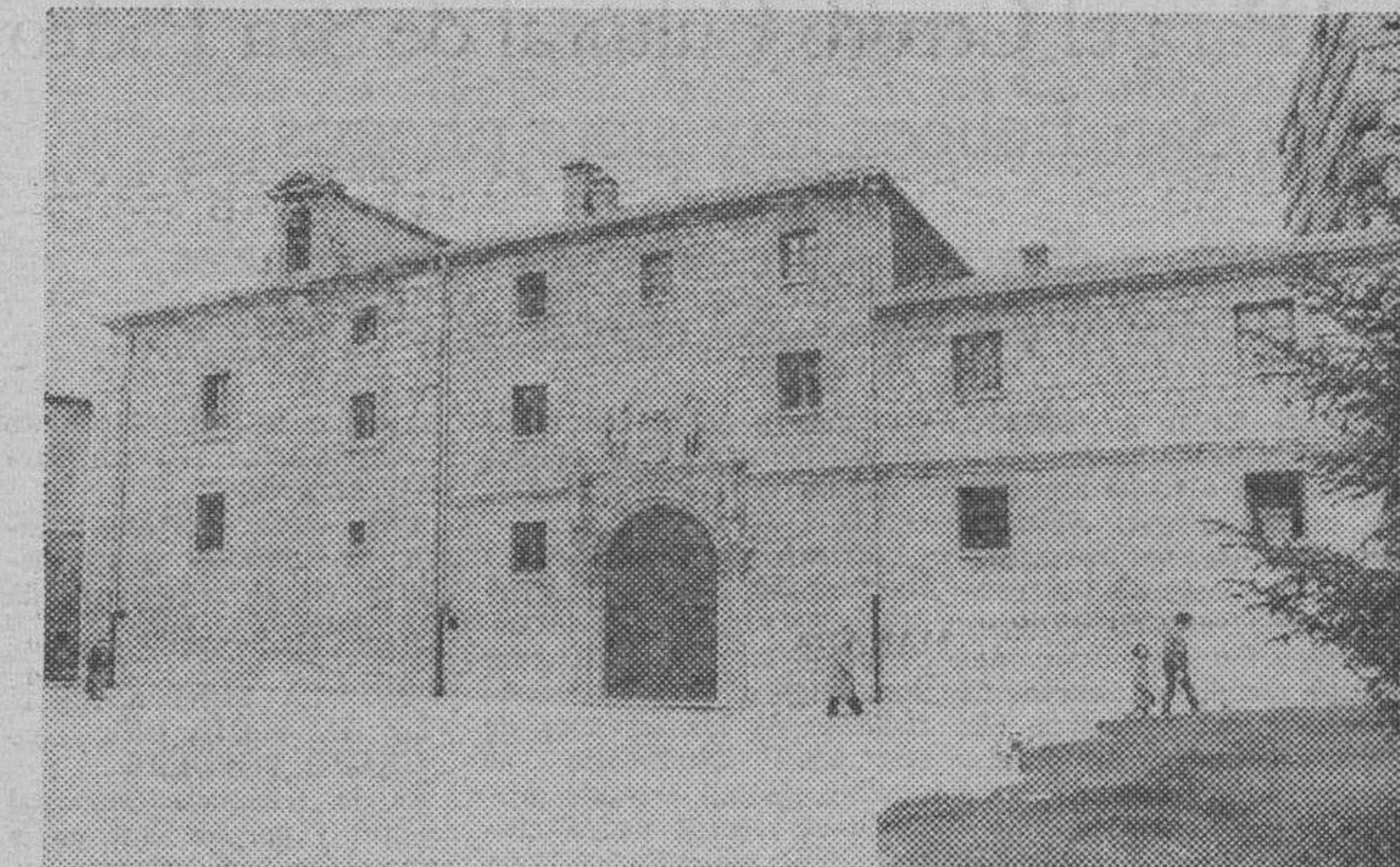
Este es el antiguo Monasterio de las Bernardas, cuyas obras de restauración de este palacio renacentista han concluido. — (Foto FEDE)
