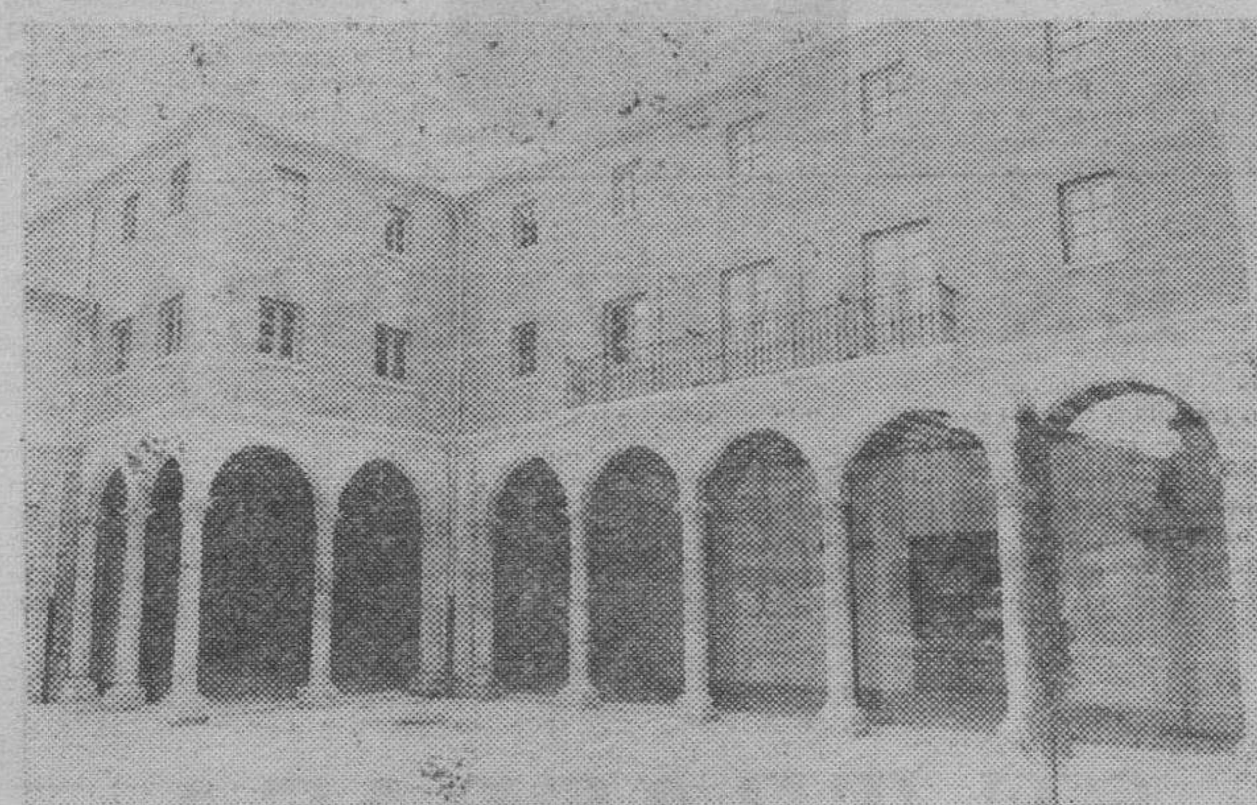
Este es el patio y el claustro del noble edificio que se ha recuperado para centro cultural y docente. La iluminación nocturna instalada es francamente magnífica. — (Foto FEDE)
