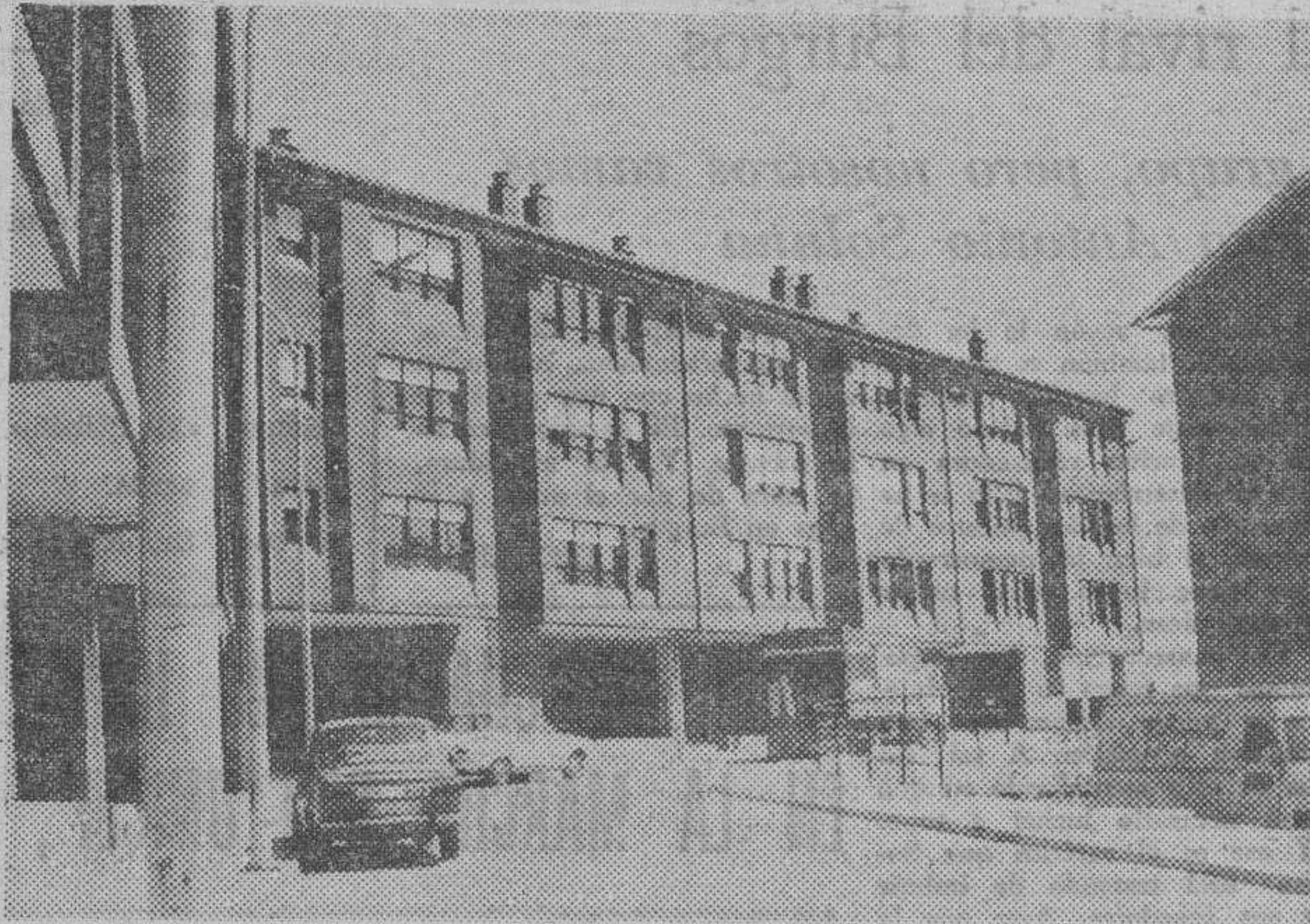
Lerma. — Grupo de viviendas del M.O.P.U. terminadas sin ocupar.
