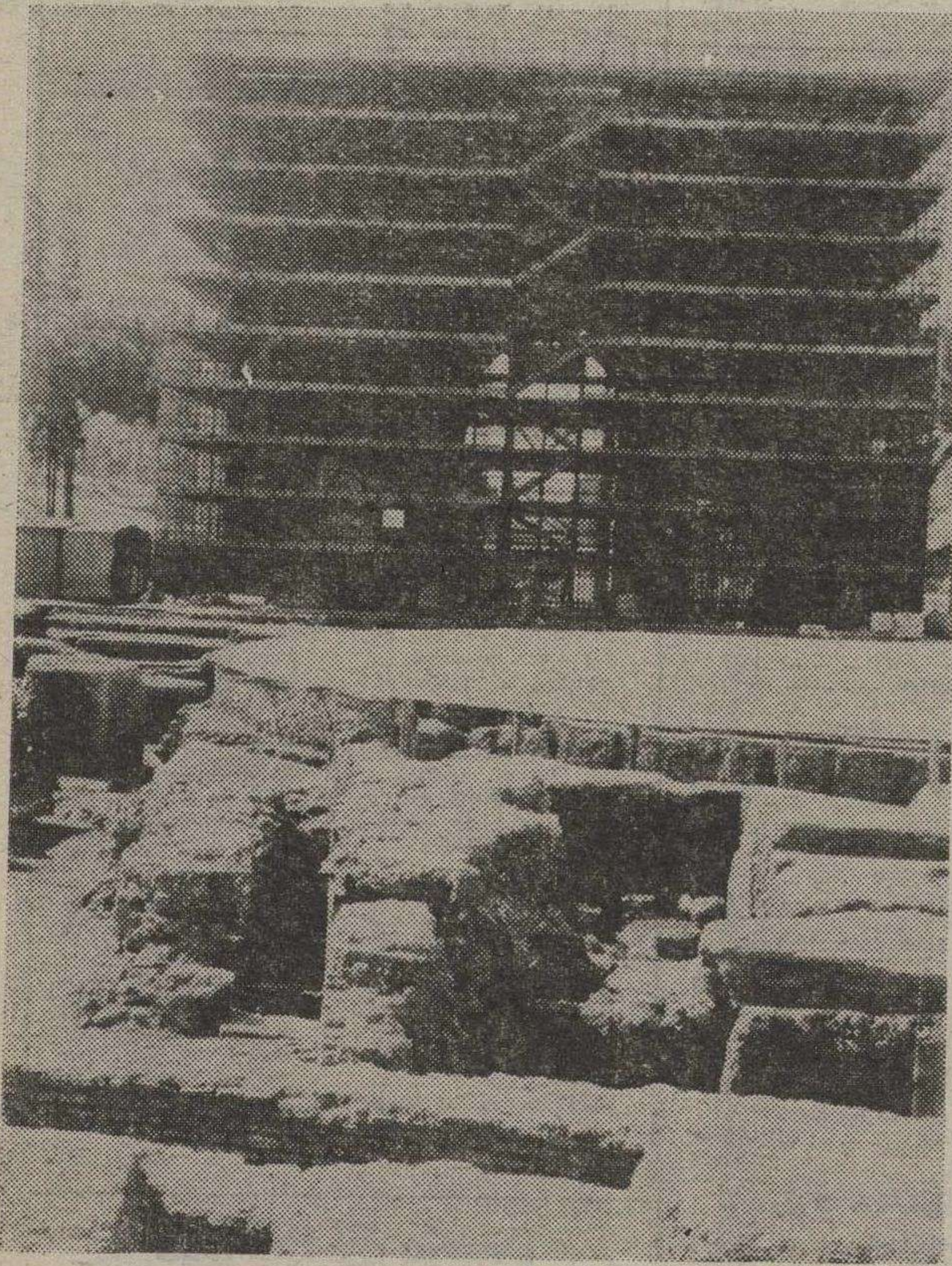
Roma. — En primer plano, excavaciones que se están realizando en Roma y que están permitiendo completar la información arqueológica sobre los edificios y la vida en la época romana. En segundo plano, el Arco de Constantino rodeado de andamios y que está siendo sometido a una restauración. — (Telefoto Efe-Upi)
