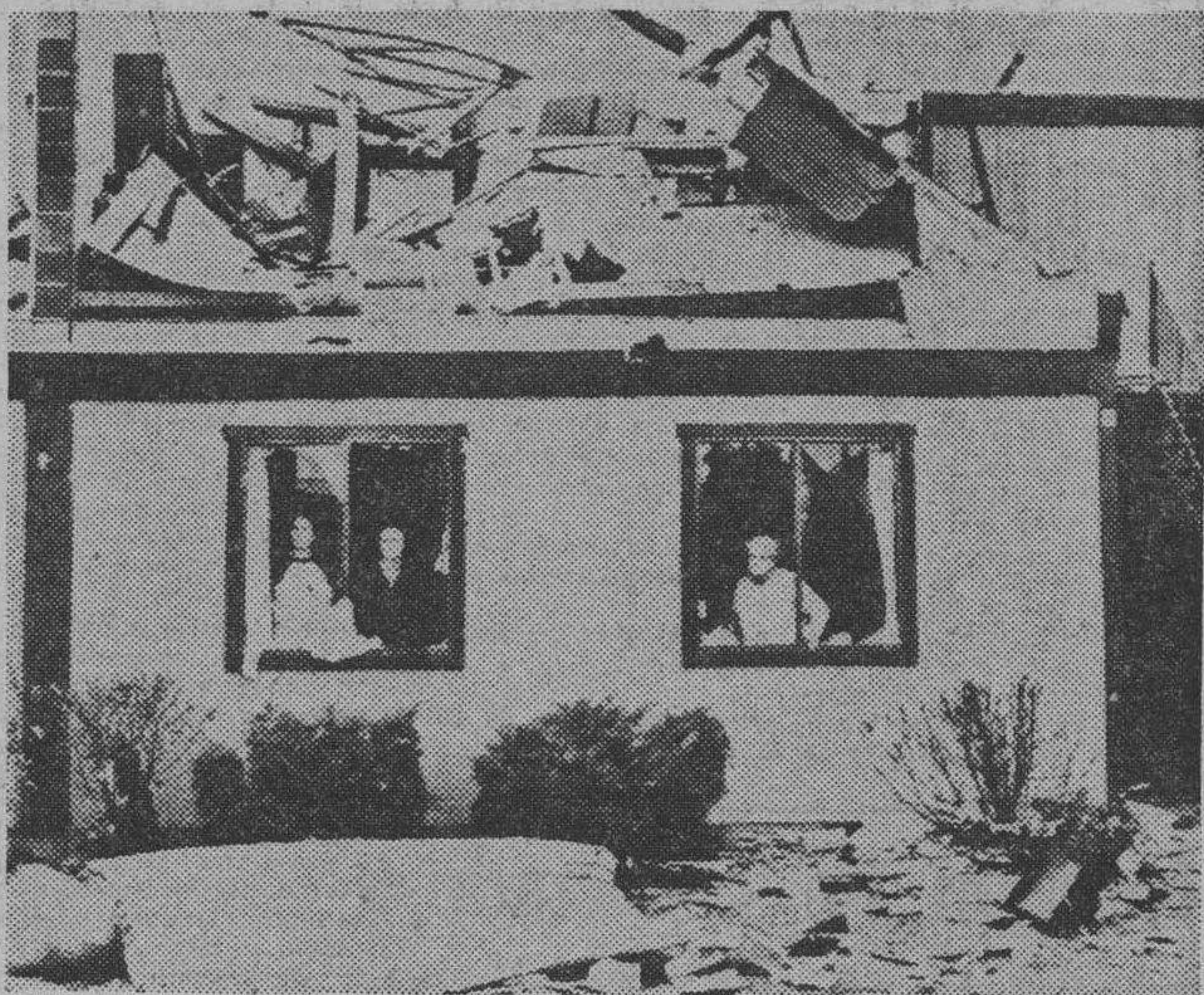
New Baden, Illinois, Estados Unidos. — Tres mujeres residentes en los apartamentos Parkview de esta ciudad, observan desde el interior de su vivienda demolida por un tornado, la caída de la lluvia. A consecuencia del tornado dos personas resultaron muertas y alrededor de 70 heridas. También un centenar de habitantes de la zona afectada perdieron sus hogares. — (Telefoto Efe-Upi)
