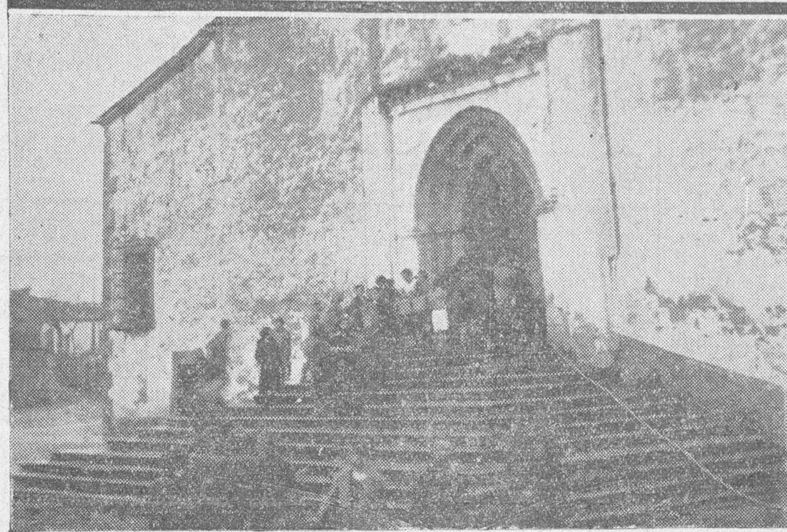
Arriba, a la izquierda: Lo que queda del Altar Mayor. A la derecha: El enterramiento de Burgalés — Abajo, a la izquierda: Fachada de la iglesia del Salvador. A la derecha: El magnífico arco del coro amenazando ruina
