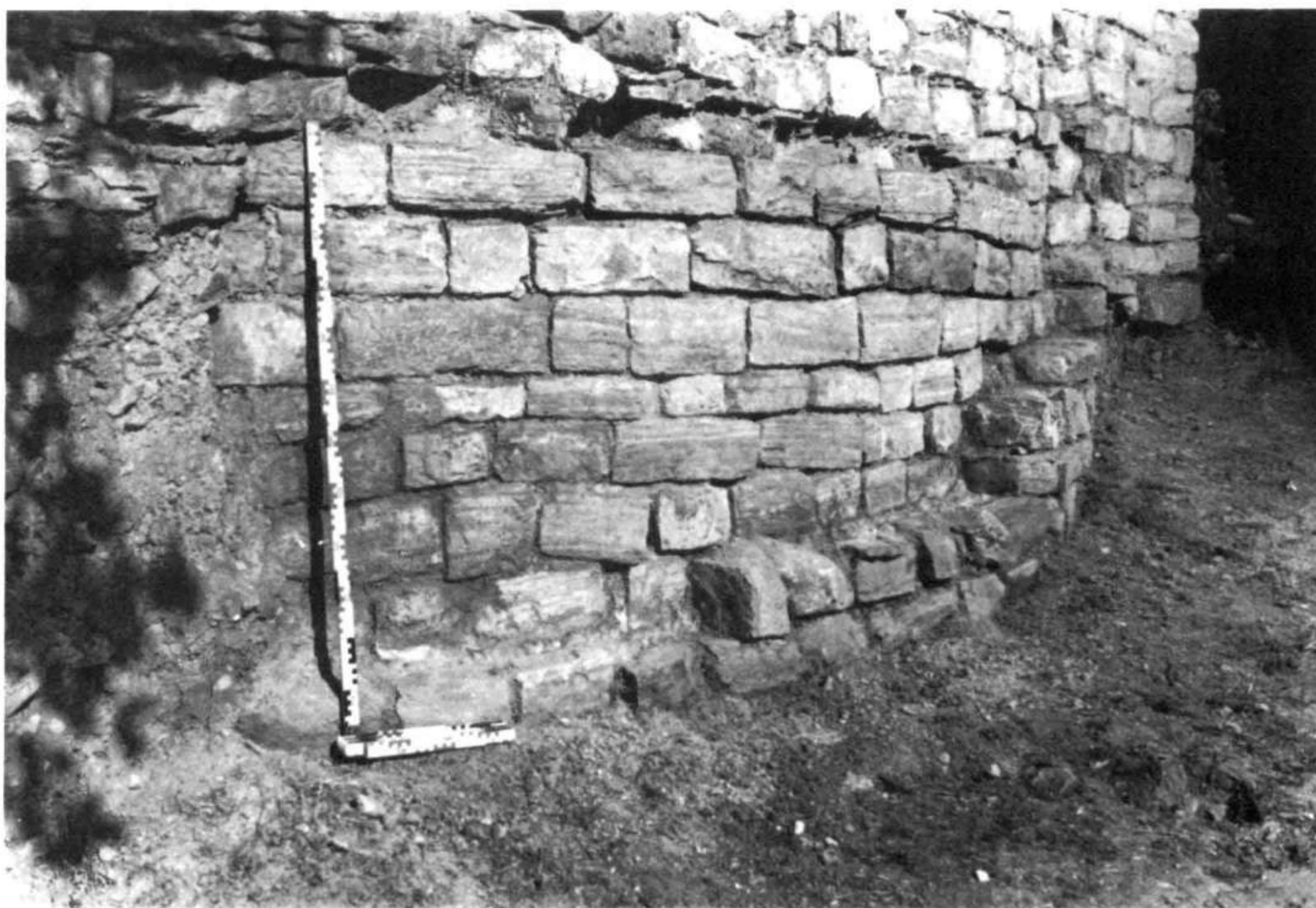
Lám. 4. Saldes, iglesia de San Martín. Aspecto del ábside y banqueta con sus sucesivos paramentos
