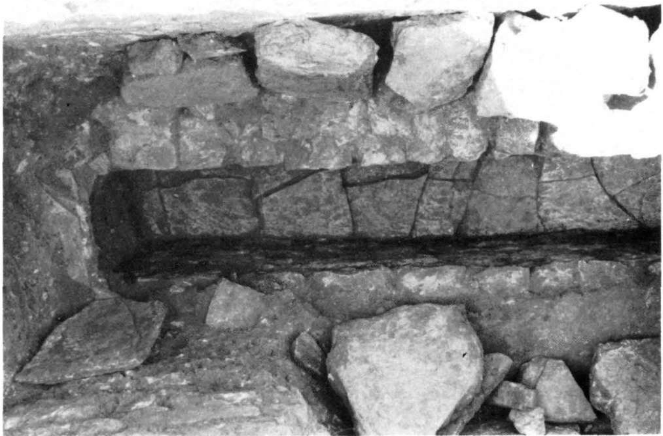
Lám. 29.— Alcantarilla en el sector III
