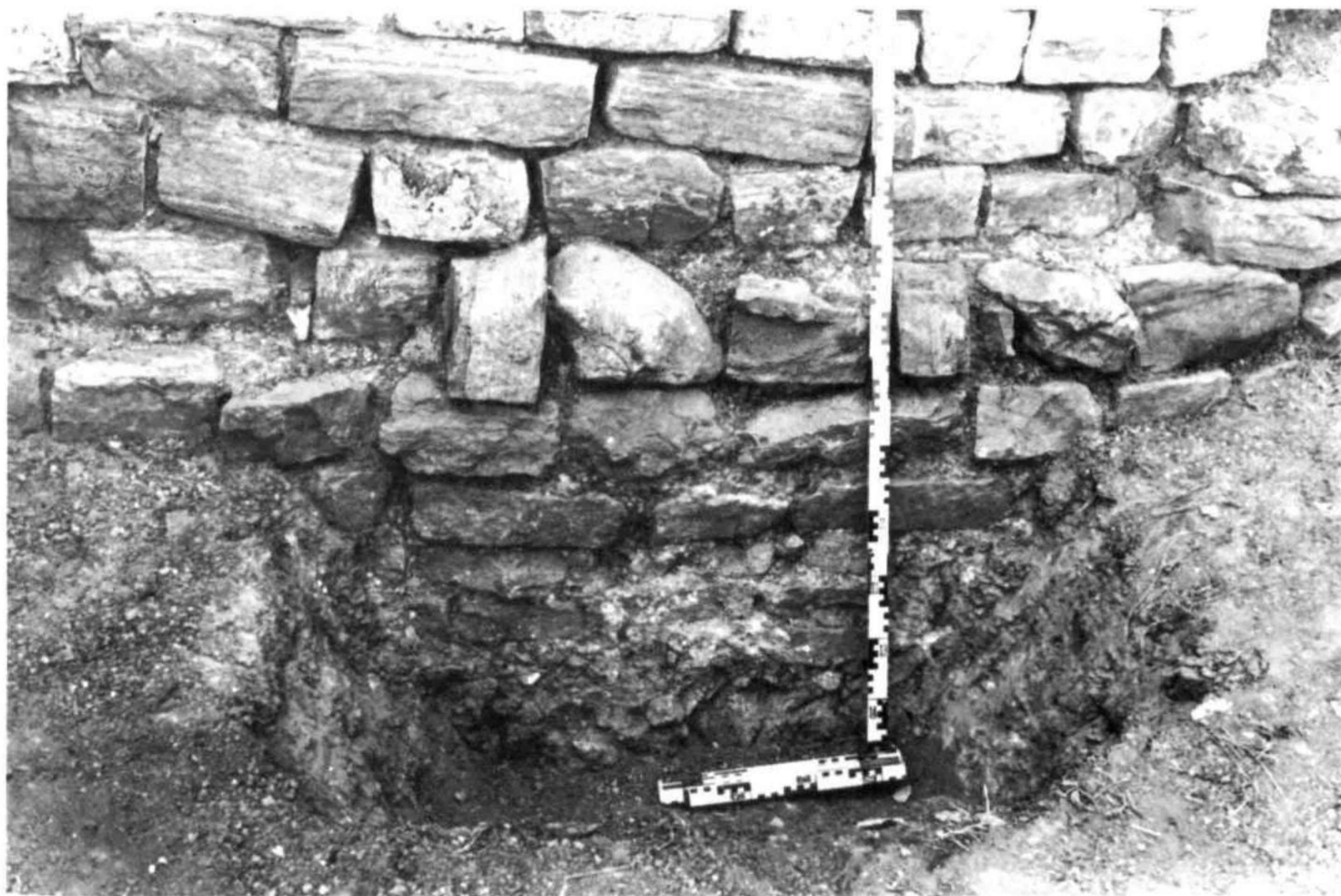
Lám. 5. Saldes, iglesia de San Martín. Cimentación del ábside
