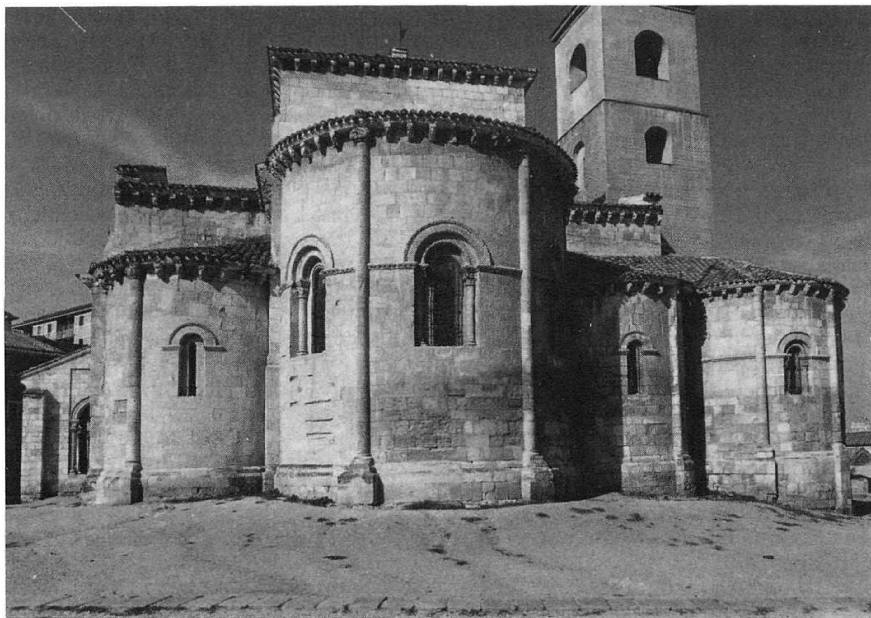
3. Cabecera de San Millán con los tres ábsides correspondientes a las naves del templo, más otro a la derecha que juega con los anteriores y queda desviado respecto de la planta de la torre.
