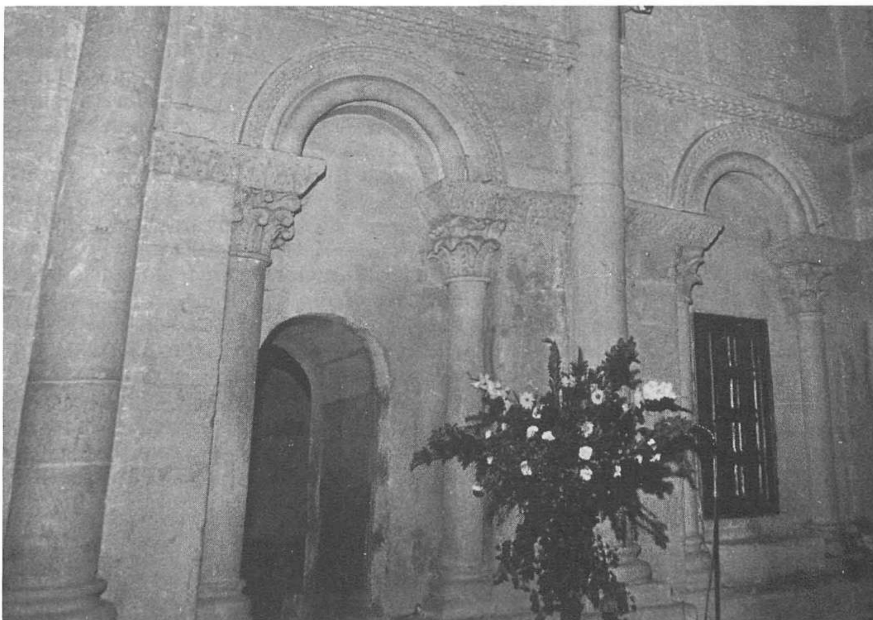
6. Presbiterio de San Millán, lado del evangelio. Semicolumnas que soportan el arco triunfal y el que refuerza la bóveda de medio cañón del tramo recto de la cabecera. Arcos ciegos laterales sumamente decorados.
