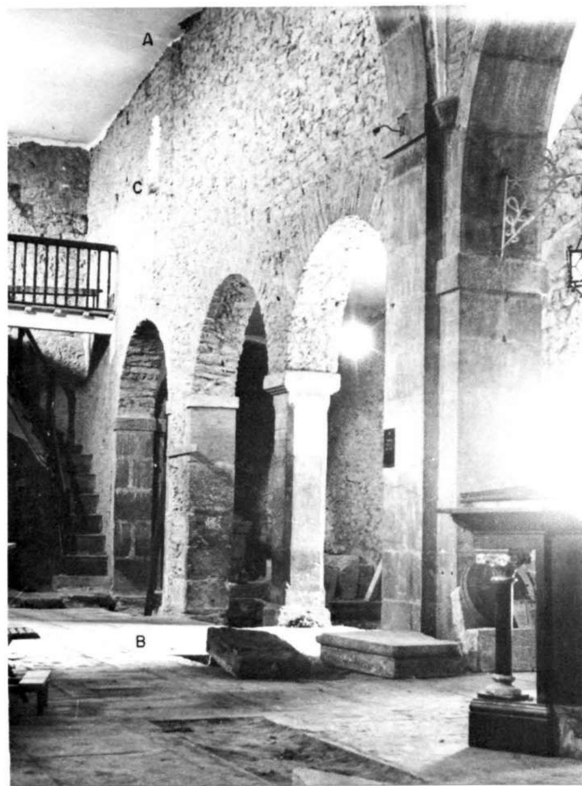
INTERIOR DEL TEMPLO VISTO DESDE EL ABSIDE. LA LINEA AB CORRESPONDE A LA DERRUIDA FACHADA PRINCIPAL, Y EL PUNTO C, SEÑALA LA ALTURA DEL PÓRTICO TAMBIÉN DESAPARECIDO. EL ÚLTIMO ARCO ES MODERNO, DEL AÑO 1868.
