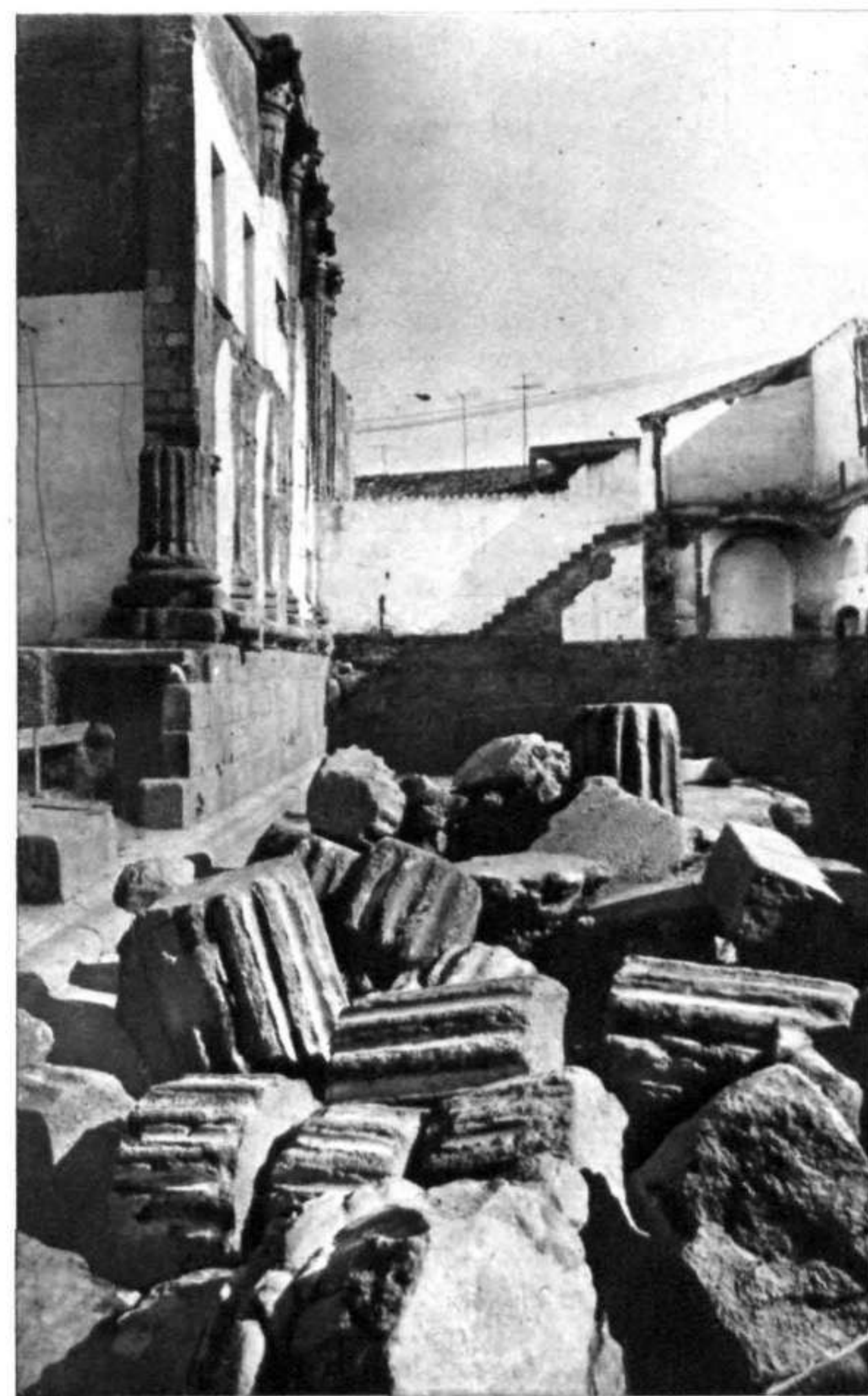
FACHADA LATERAL DEL TEMPLO. CON LOS ELEMENTOS DE LA COLUMNATA.
