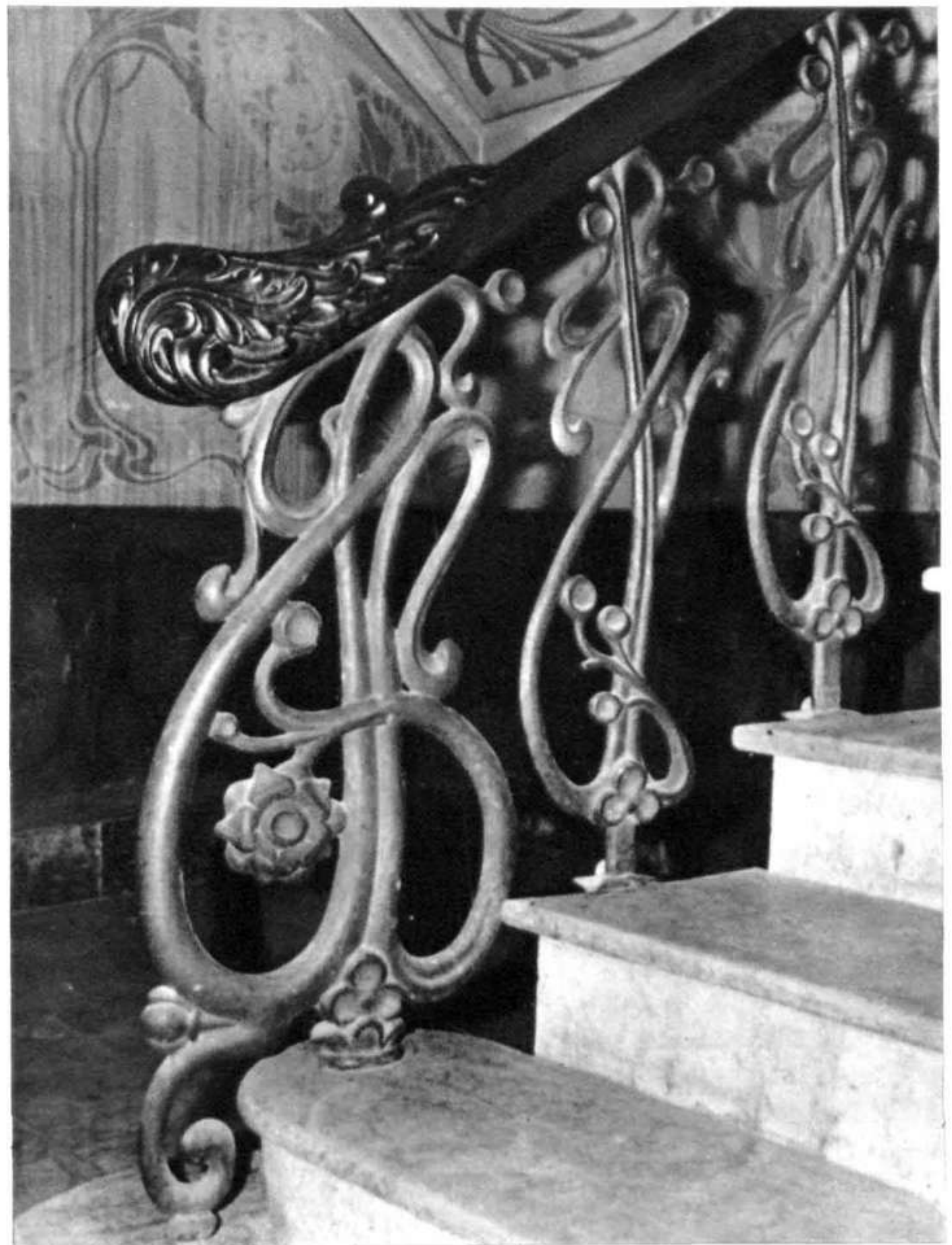
ESCALERA EN LA CASA DE ALDOGONERA, 6. ATRIBUIDA AL ARQUITECTO VICENTE J. PASCUAL PASTOR.
