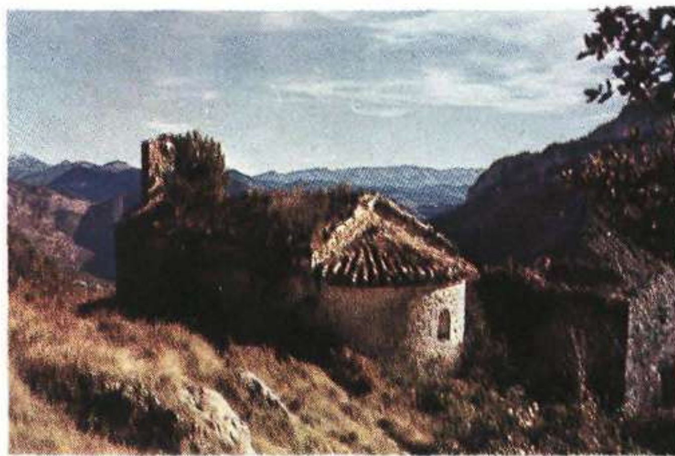
Nostra Sra. de les Agulles, antes de su restauración.
