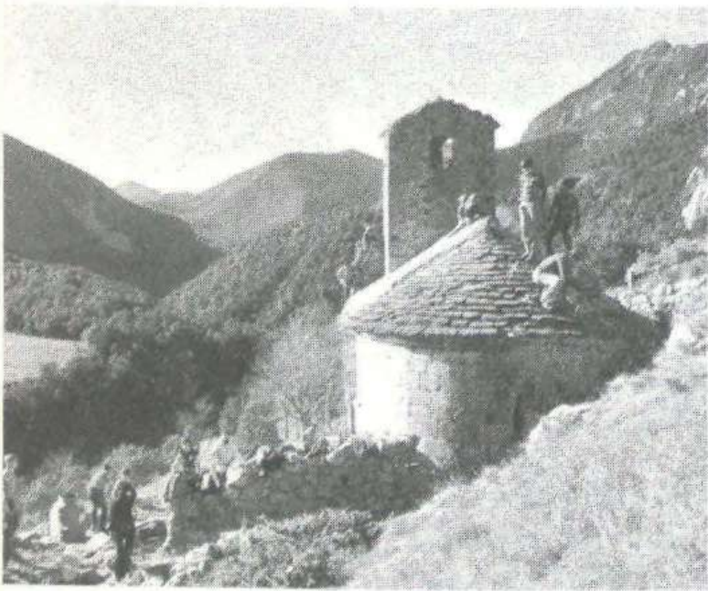
Santa Maria d'Escales durante su restauración.
