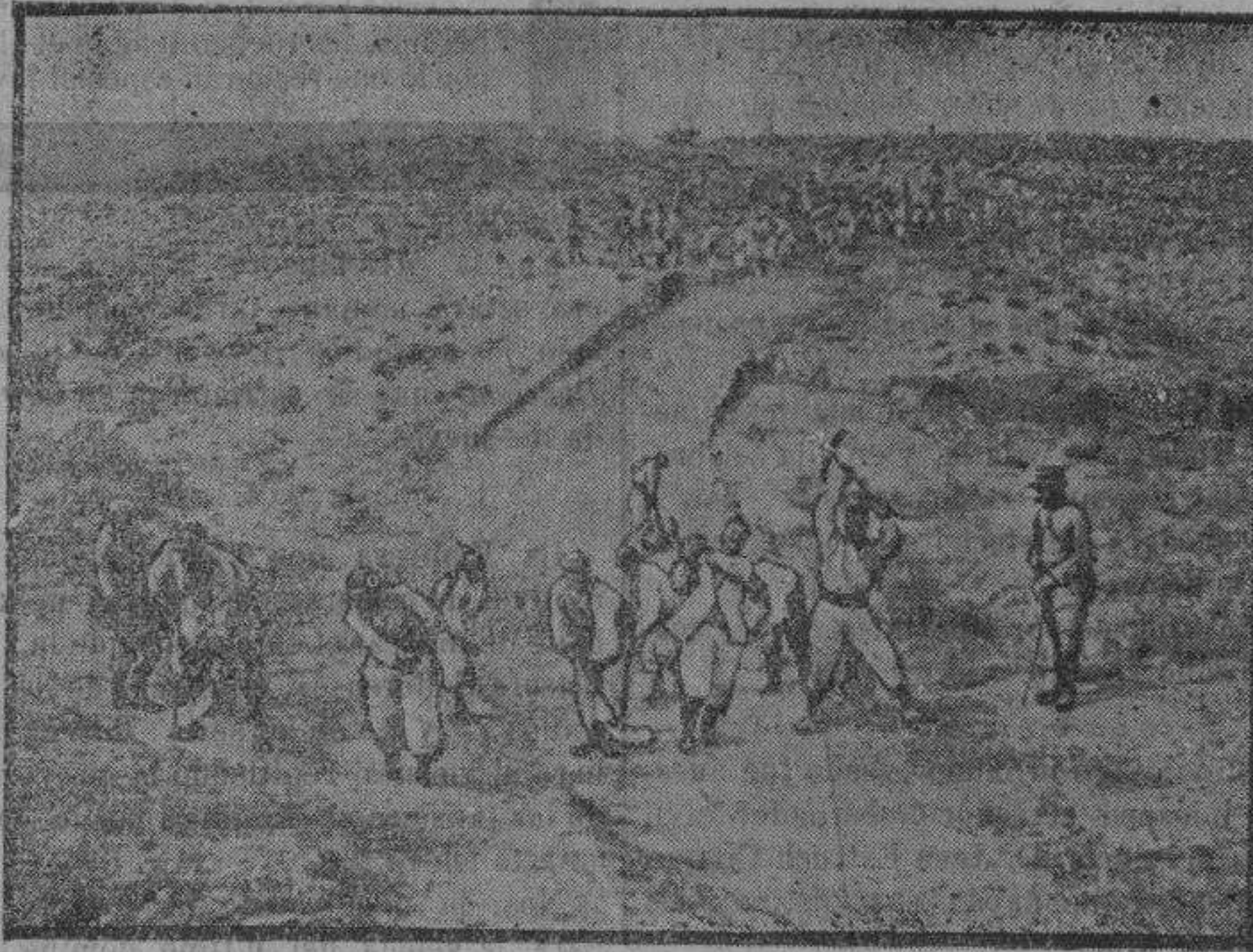
Construcción de un camino—(Foto Información)
