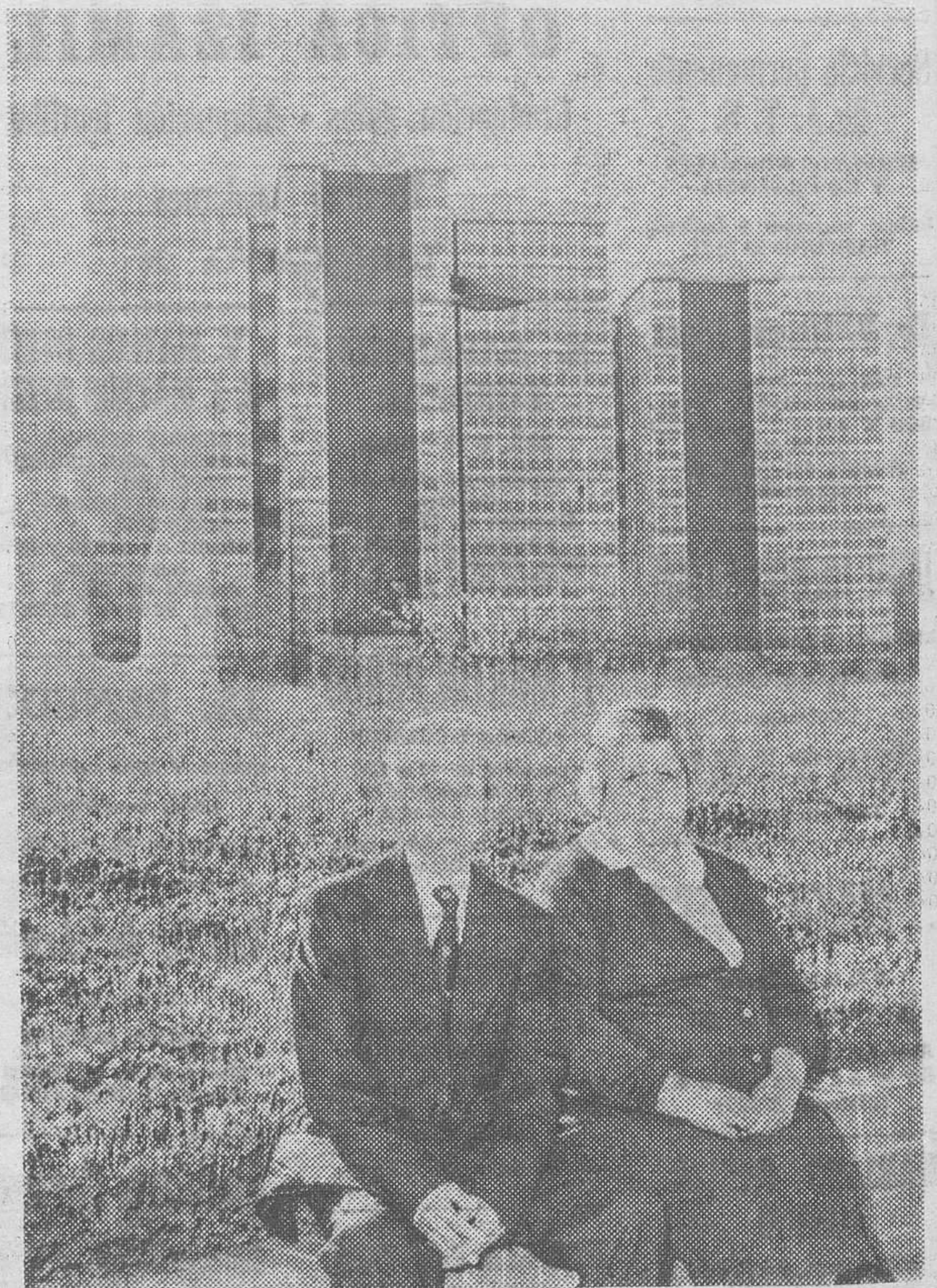
AL FONDO, SU NUEVO PISO, DE LA AVENIDA DEL GENERAL VIGON
