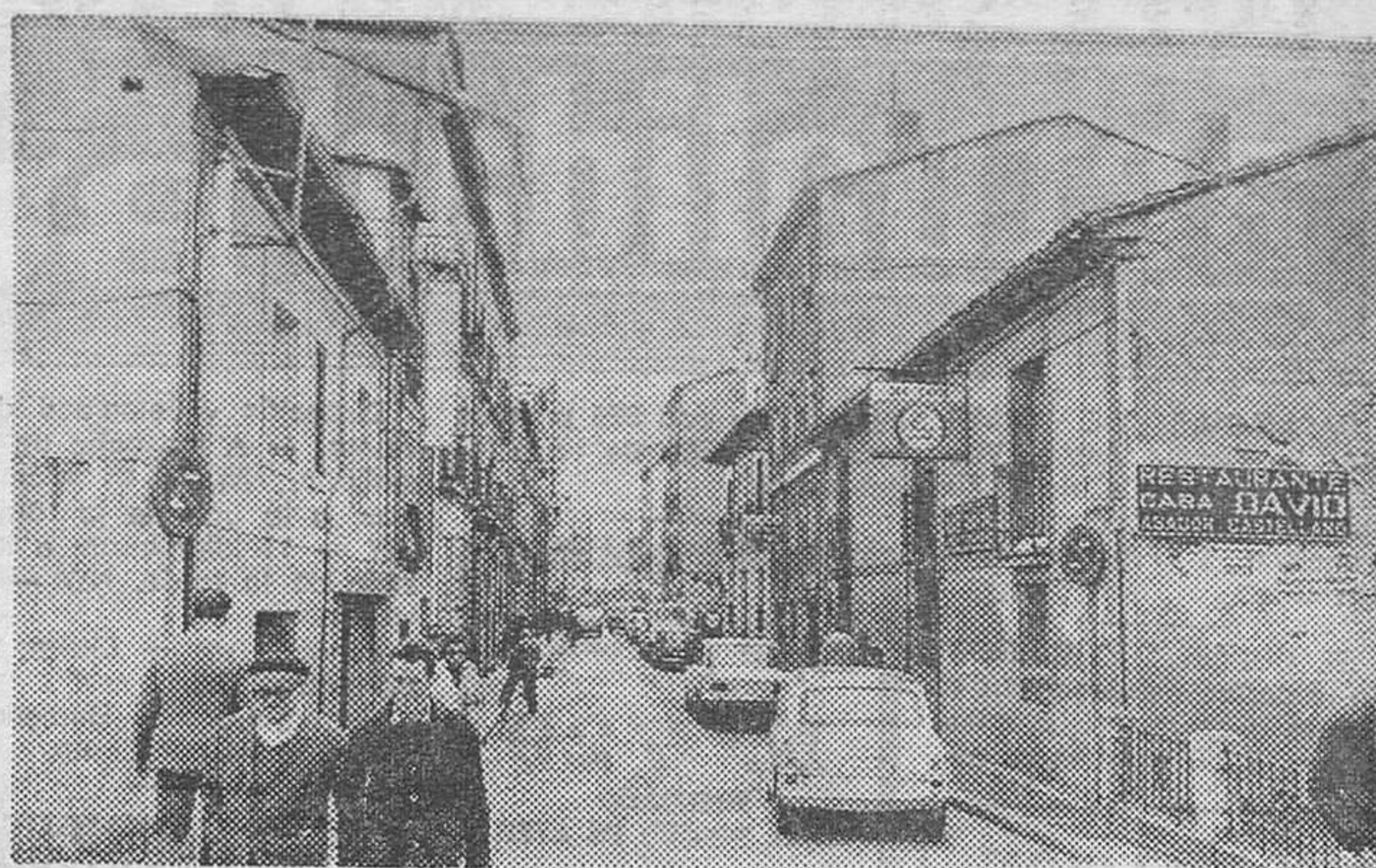
Con el encargo de la construcción del colector de la calle de Santa Dorotea, se inicia el plan municipal de solución de los graves problemas planteados por las inundaciones en la zona de San Pedro y San Felices. — (Foto FEDE)
