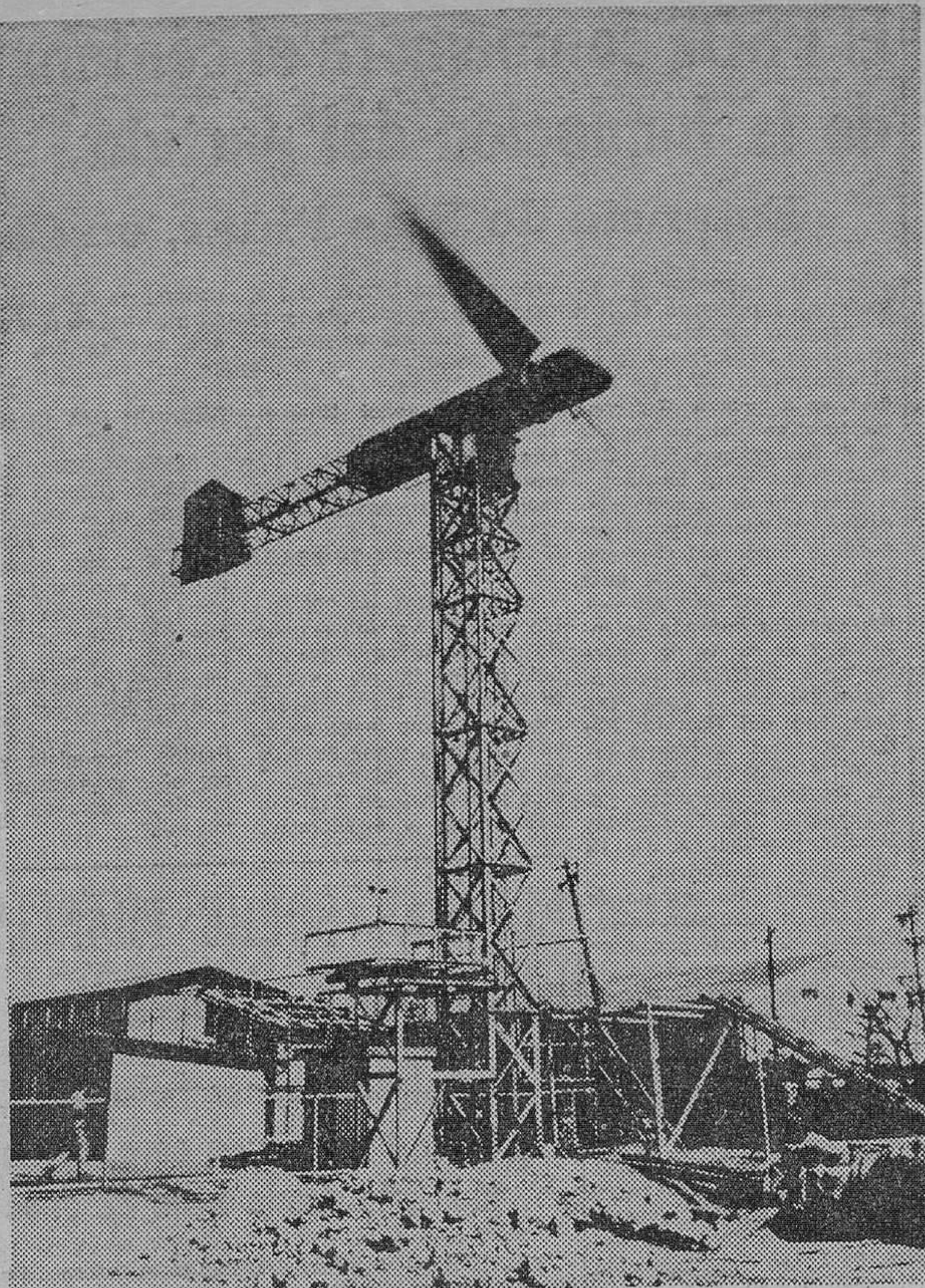
Motor eólico instalado en Japón. — (Foto FIEL-EFE)
