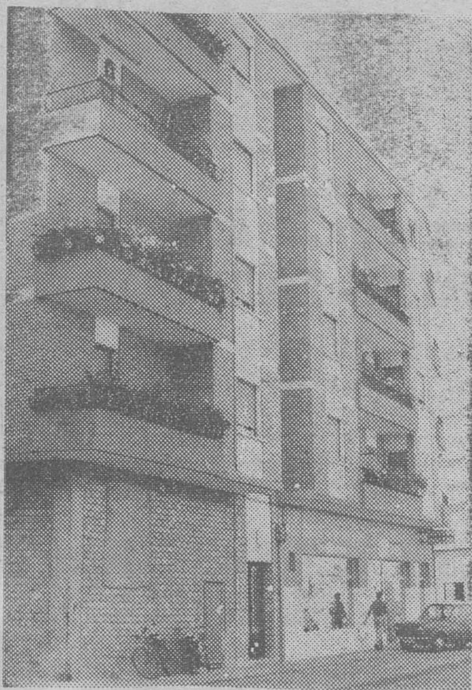
Otro aspecto de las modernas edificaciones de la calle de Pizarro. — (Foto Reyes).
