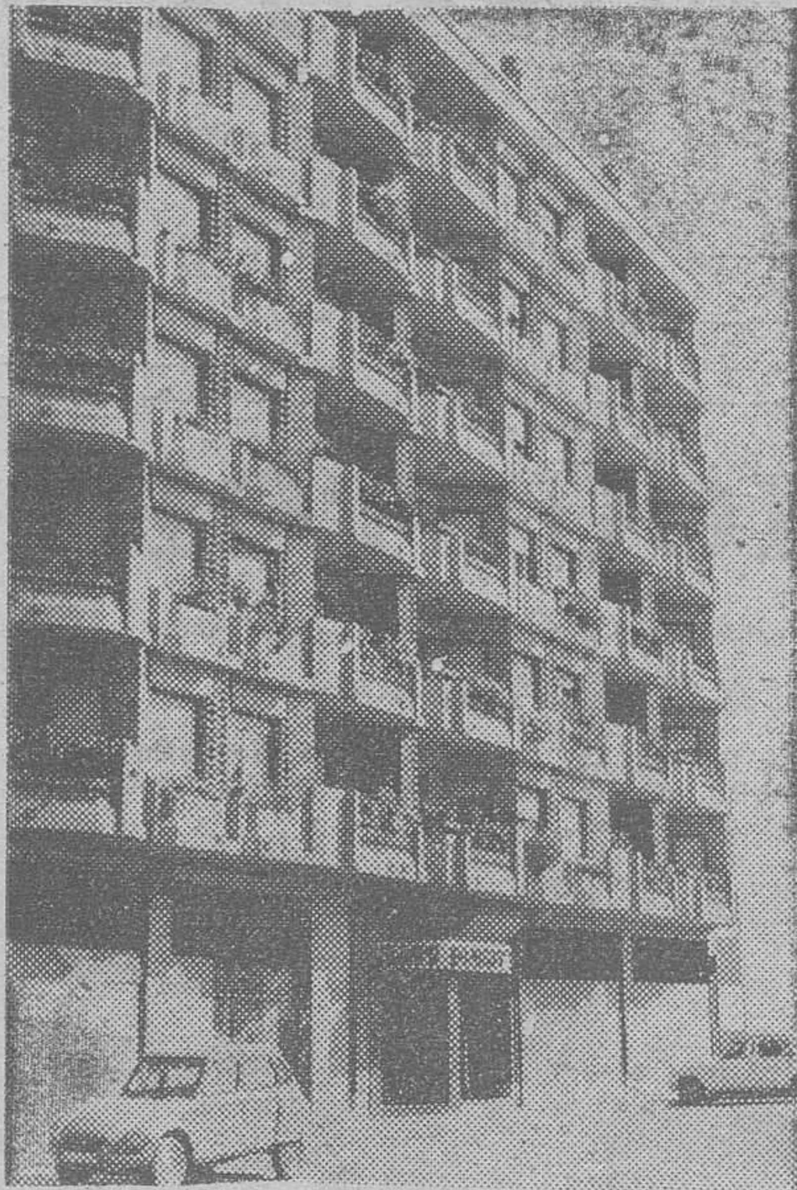
Moderna edificación de la calle de Santiago, de Aranda de Duero. — (Foto Reyes).
