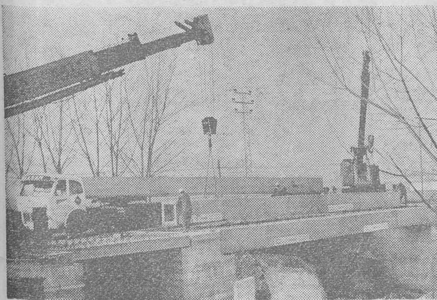
No se hundirá el puente, no. Nos referimos al del río Bayas de la carretera de Miranda a Logroño, que como saben nuestros lectores está siendo ampliado para dar mayor fluidez al tráfico rodado. Nada menos que cuatro vigas de hierro han sido colocadas en la parte central del puente. Cuatro vigas que pesan en total 64.000 kilos, o sea 64 toneladas de hierro.
